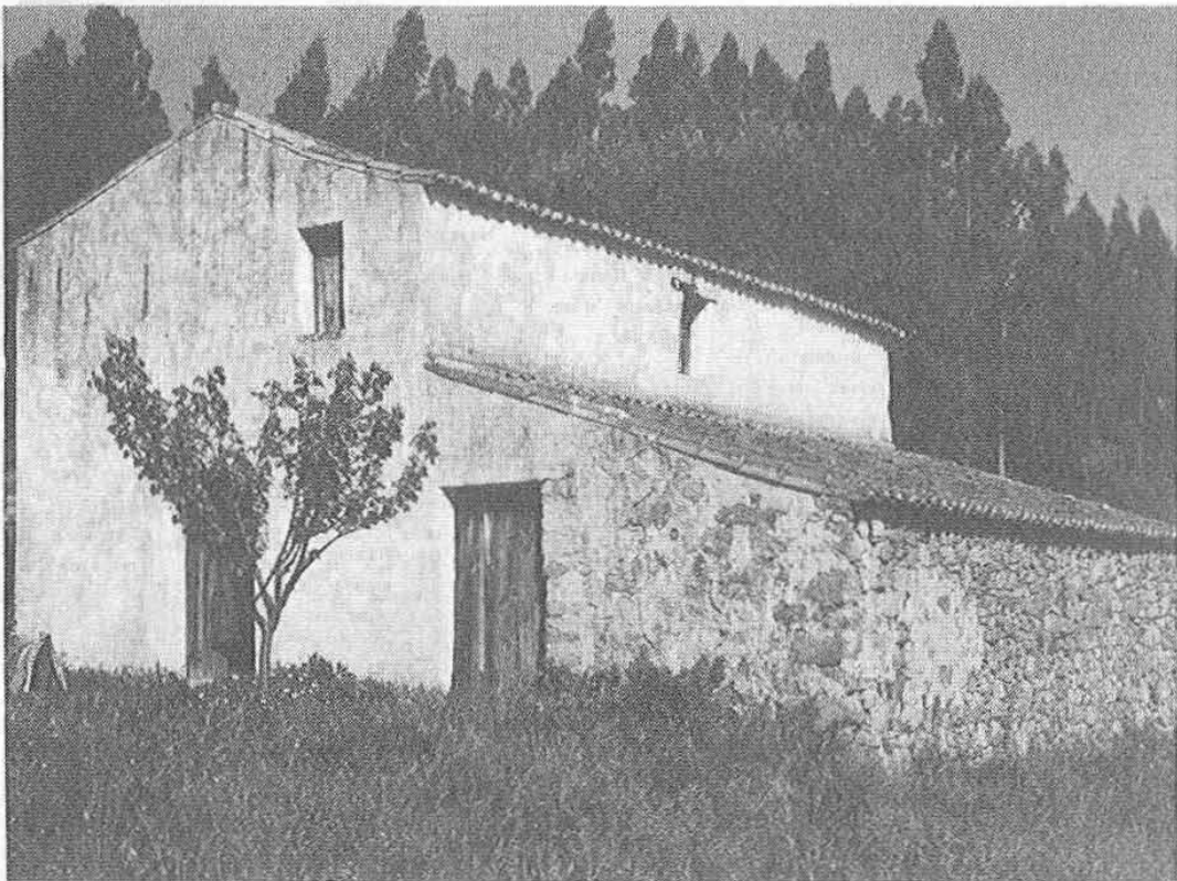
Fig. 11: Torre Fundeira: exterior da capela de N.ª S.ª das Sete Fontes. Modificações recentes alteraram definitivamente a traça do edifício original, construído nos meados do séc. XVI.
