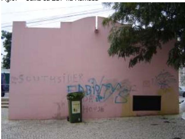
Fig.67 – Caixa da EDP na Ramada
