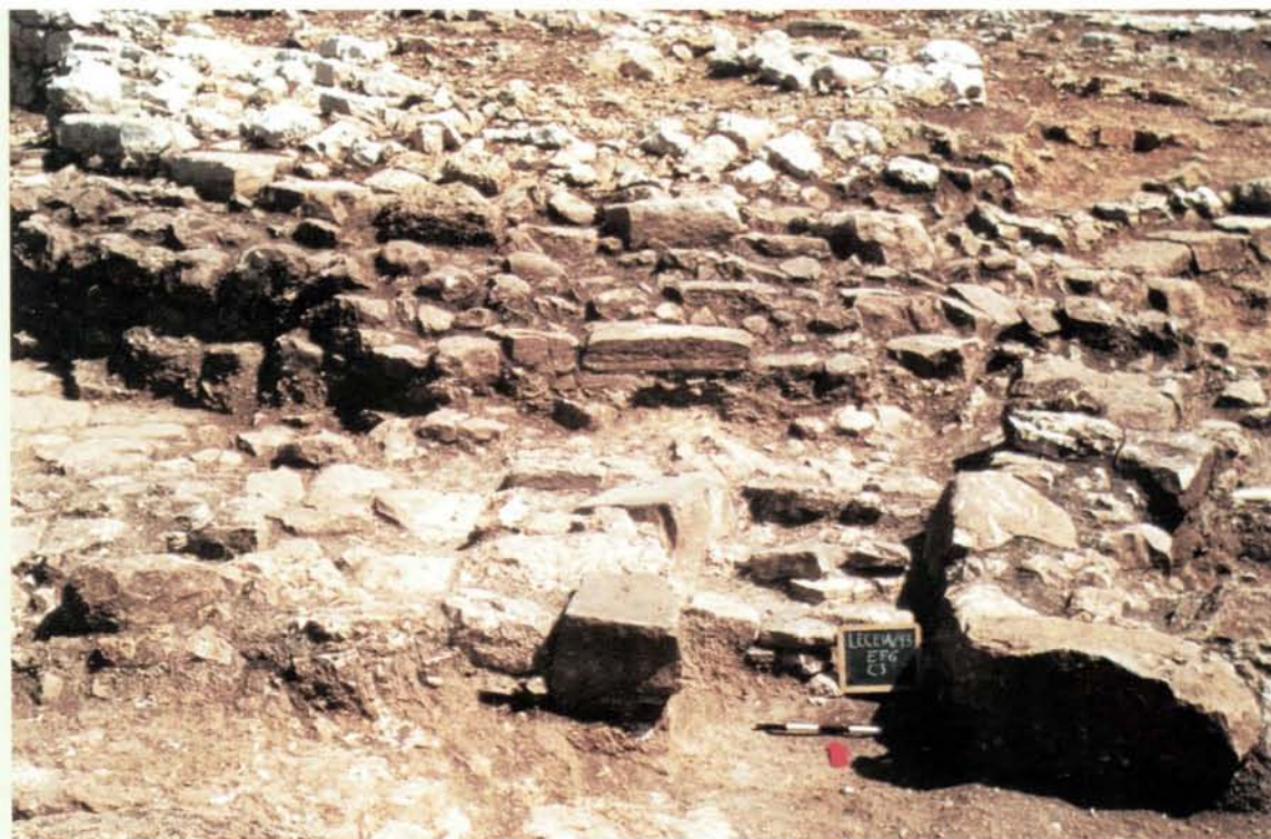
Leceia. Vista da Entrada EH 13, na junção da 2. a com a 1. a linha defensiva. Para vencer o desnível, consruíram-se três degraus. Calcolítico inicial (2. a fase construtiva).
