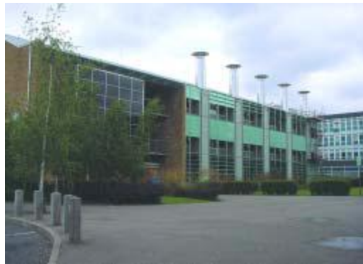
Figura 2 - Vista do exterior de um edifício de escritório com certificação BREEAM Offices, com chaminés para controlo de temperatura e sistema de controlo da iluminação (Pinheiro, 2007).
