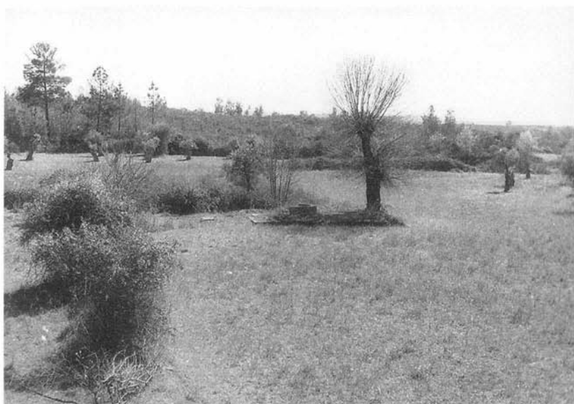
FOTO 7 – Barragem da Orca (Fundão). Vista parcial da área da antiga albufeira, asso- reada, obtida da margem esquerda, notando-se a estrutura hidráulica com poço
