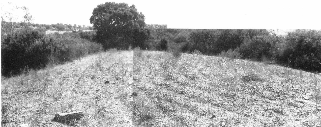
Foto 13 – Barragem da Egitânia (Idanha-a-Nova). Coroamento do aterro na margem direita
