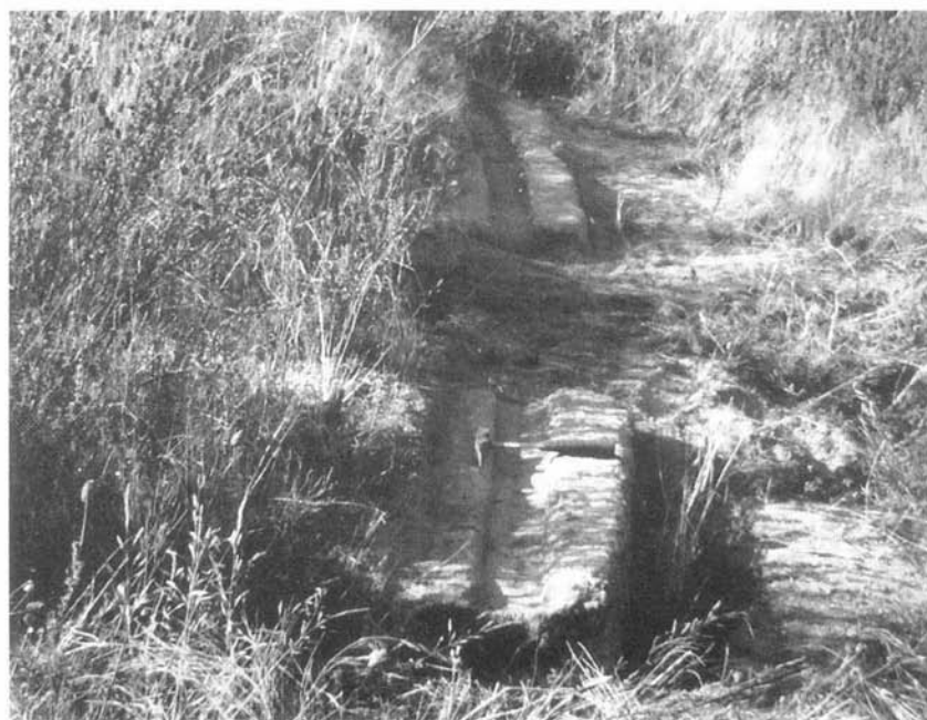
FOTO 12 – Barragem do Rochoso (Idanha-a-Nova). Caleira de granito, junto do encontro esquerdo da barragem
