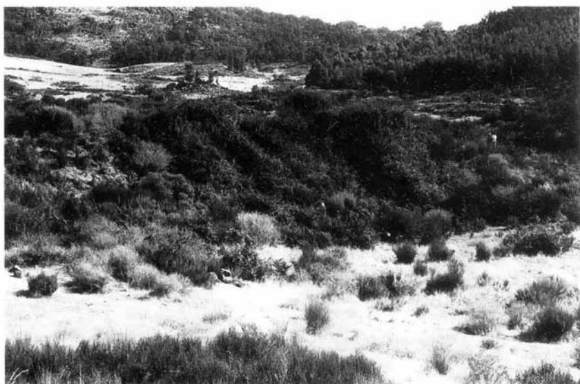
FOTO 9 – Barragem do Rochoso (Idanha-a-Nova). Vista geral do aterro na margem direita, observando-se na zona central o talude de jusante, coberto de mato, e o de montante, com pendente mais suave, em pousio
