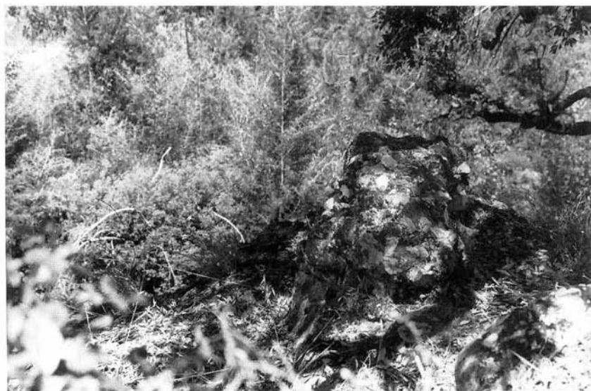
Foto 26 – Barragem do Souto do Penedo (Vila de Rei). Resto do muro no topo do penedo
