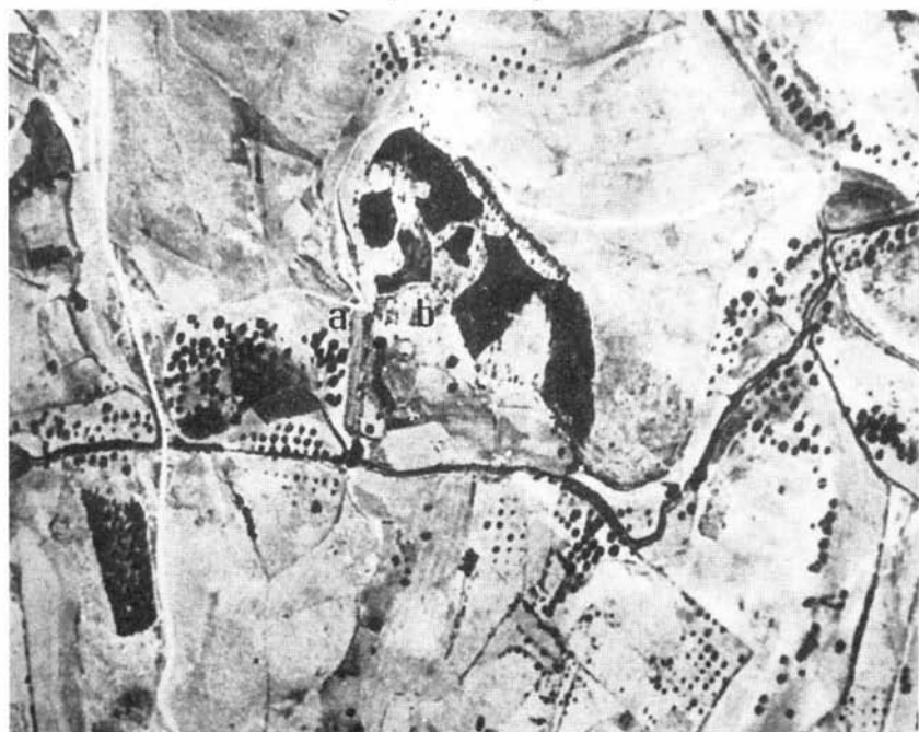
FOTO 6 – Barragem da Orca (Fundão). Fotografia aérea vertical, reconhecendo-se a barragem (a) e a zona de movimentação de terras (b)
