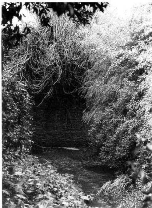
Foto 27 – Barragem de Alferrarede (Abrantes). Vista do paramento de montante, antes da desmatação
