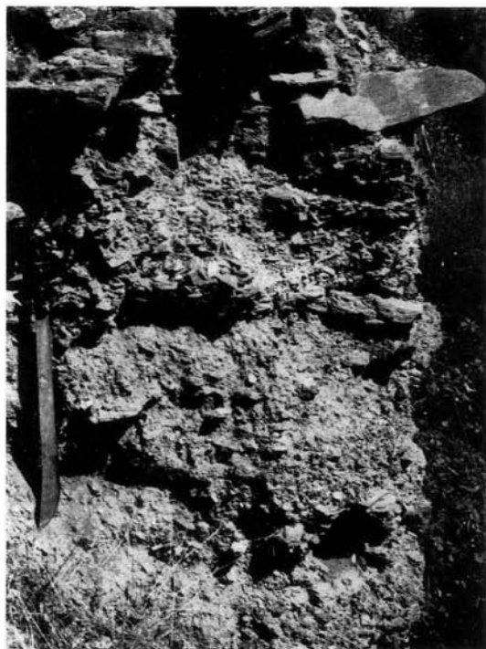
Foto 16 – Barragem da Egitânia (Idanha-a-Nova). Pormenor da estrutura do aterro
