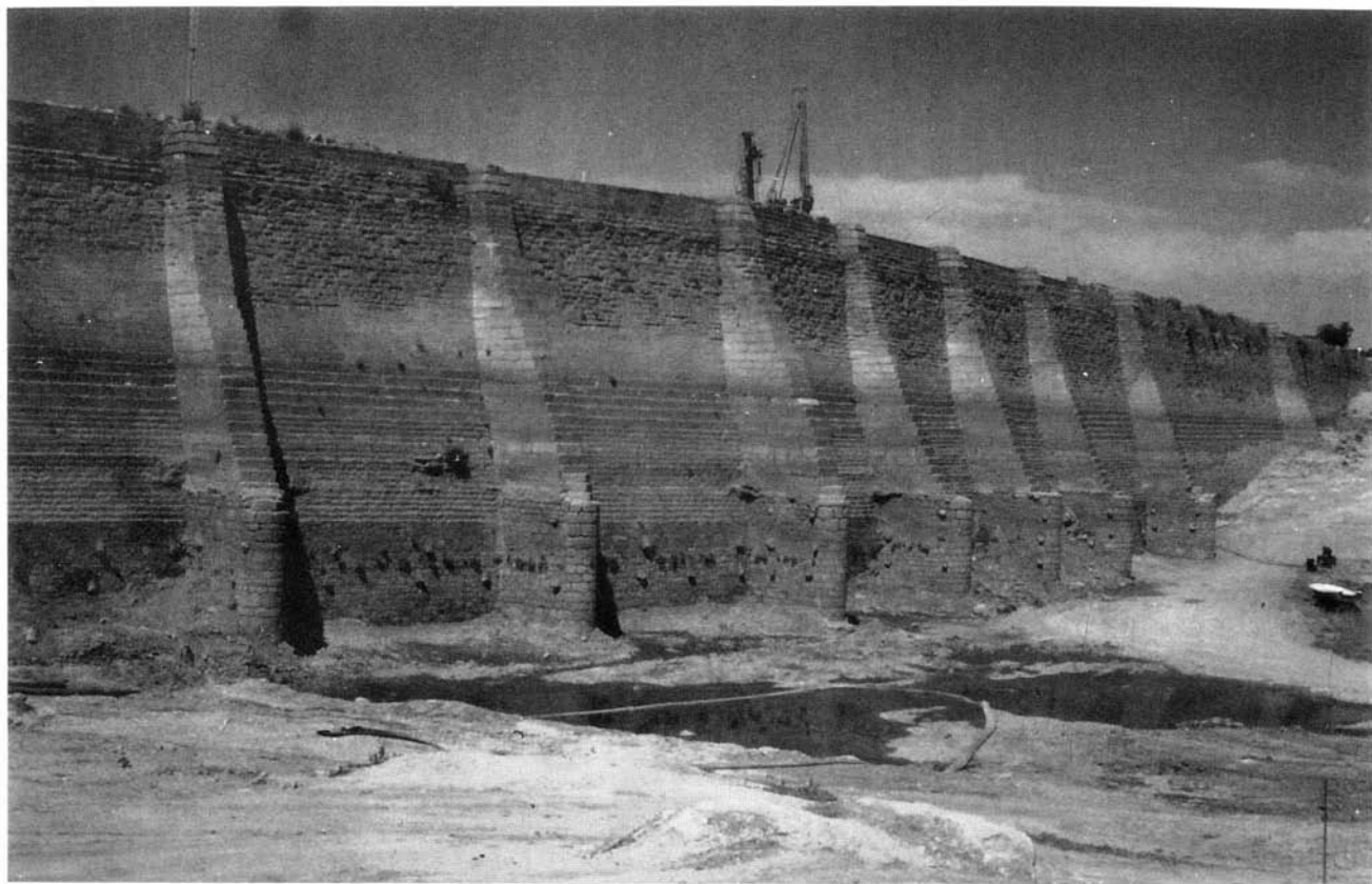
Foto 34 – Barragem de Proserpina. Vista do paramento de montante, com a albufeira vazia e desassoreada em 1992
