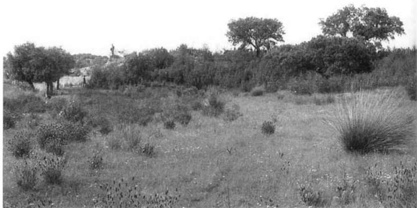
Foto 23 – Barragem da Lameira (Vila Velha de Ródão). Vista do aterro, obtida de jusante na margem esquerda
