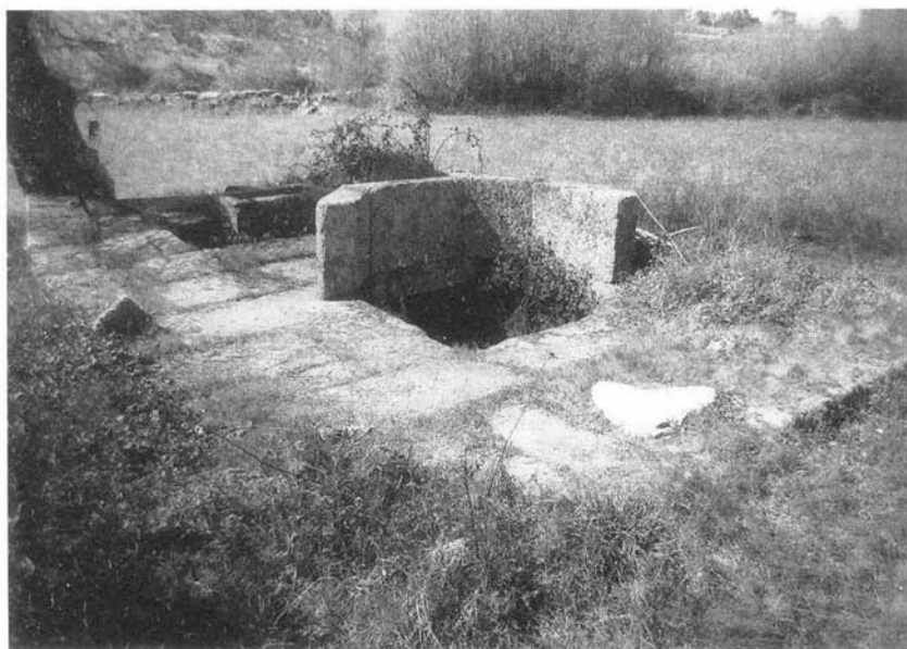
FOTO 8 – Barragem da Orca (Fundão). Pormenor da estrutura hidráulica, com lajeado, poço e tanque
