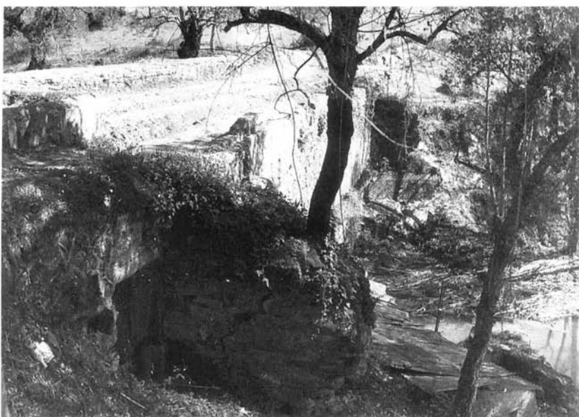
Foto 31 – Barragem de Alferrarede (Abrantes). Vista de jusante, notando-se em primeiro plano a saída de uma galeria transversal à barragem.
