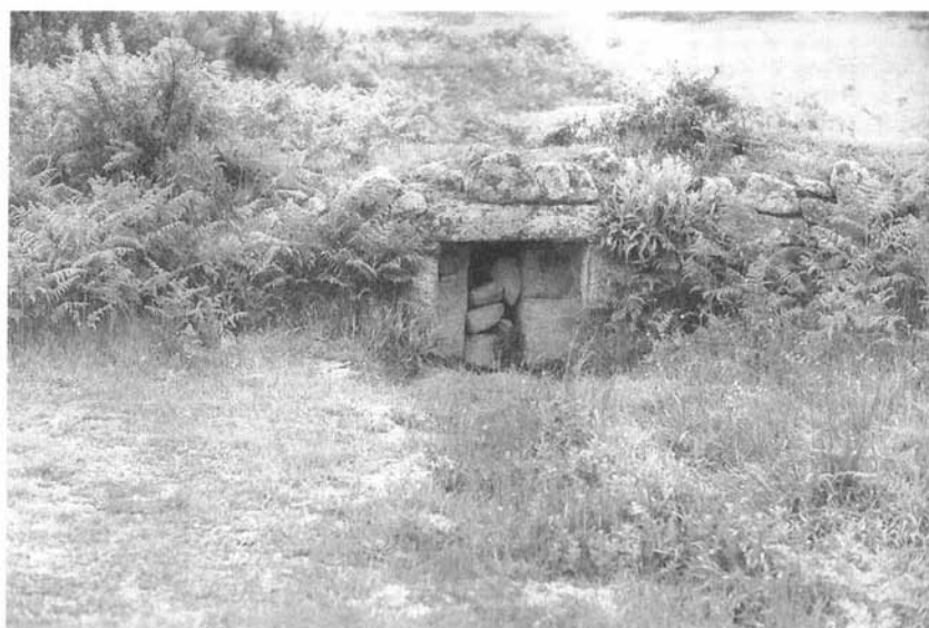
FOTO 11 – Barragem do Rochoso (Idanha-a-Nova). Fonte provavelmente romana, a cerca de 500 m a montante da barragem, que alimentava a villa de S. Lourenço
