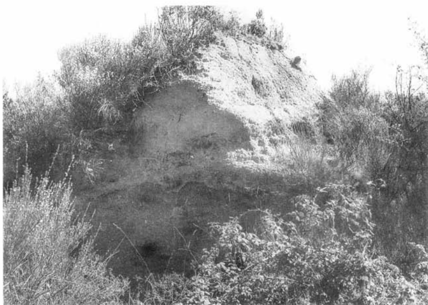
FOTO 4 – Barragem da Orca (Fundão). Vista da brecha na margem esquerda
