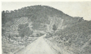
Fig. 5 – Estrada do lugar do Pareiro para o do Castelo e que ao fundo atravessa a ponte de Pôrto do Concelho.
