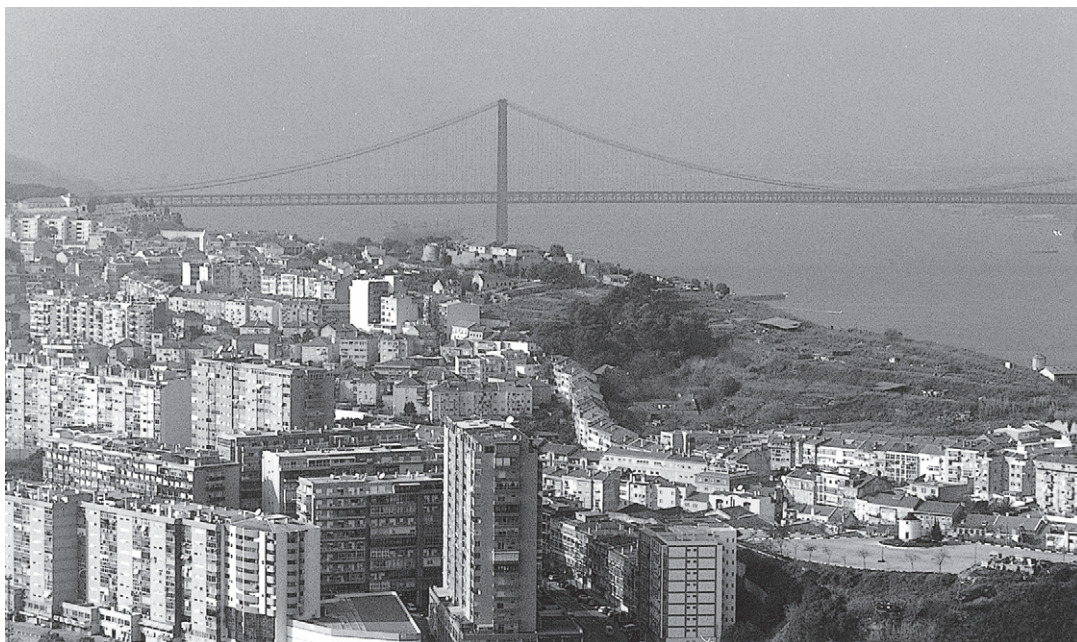
Fig. 172 – Vista parcial, do lado direito, da colina do Almaraz, Almada, voltada para o estuário do Tejo. No limite visível, a área habitacional já escavada, correspondente a telheiro. Mais abaixo, observa-se talude correspondente à muralha interna, a qual era acompanhada por um fosso, que se desenvolvia do seu lado externo. Foto J. L. Cardoso.
