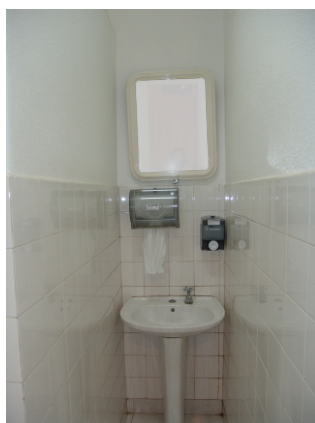
86 Instalações sanitárias modernas. Mário Lisboa 2006
