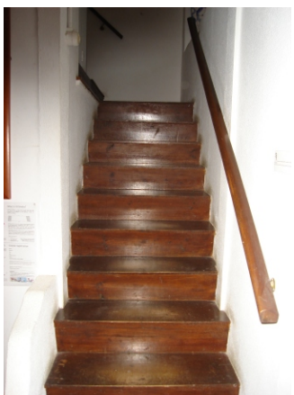
117 Imagem composta. Escada de finais do século XIX de acesso ao 3º piso Nascente. Dois lanços perpendiculares. Mário Lisboa 2006
