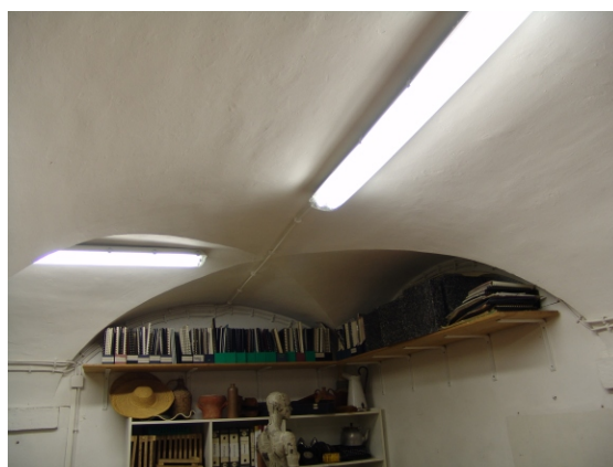
Sala com pilares e abóbas de aresta. 68 Mário Lisboa 2006
