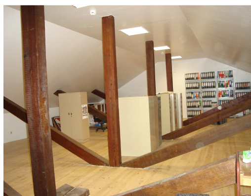
39. Adaptação de espaço sob a cobertura, acrescentando área ao terceiro piso do lado Nordeste. Mário Lisboa 2006
