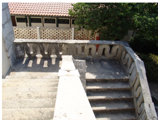
Escadaria Nascente de acesso à esplanada. 41 Mário Lisboa 2006
