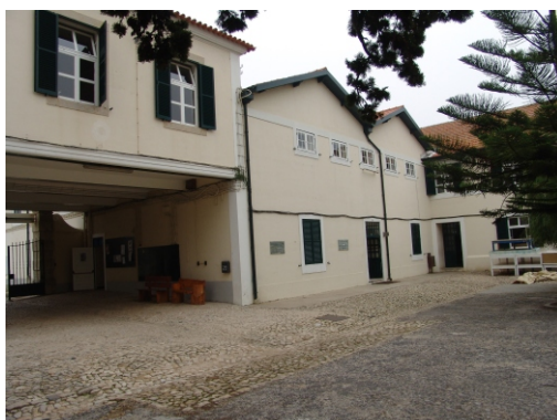
5 Alçado Nordeste e entrada do Pátio. Mário Lisboa 2006
