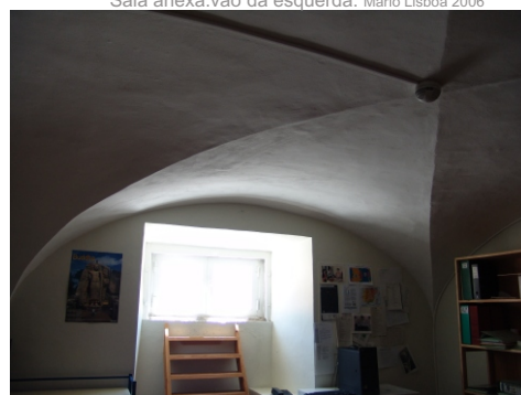
3ª sala anexa com abóbada de aresta. 74 Mário Lisboa 2006
