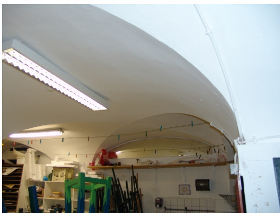
67 Sala com pilares e abóbas de aresta. Mário Lisboa 2006
