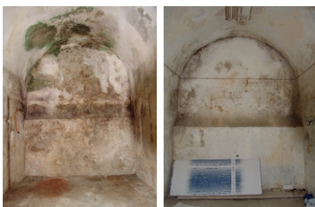
51 Imagem composta Salas laterais de abóbada de berço. Antes do restauro. Mário Lisboa 2006
