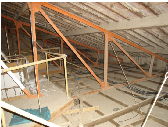
18 Estrutura metálica da cobertura da antiga adega, reestruturada na década de 1920. Mário Lisboa 2006
