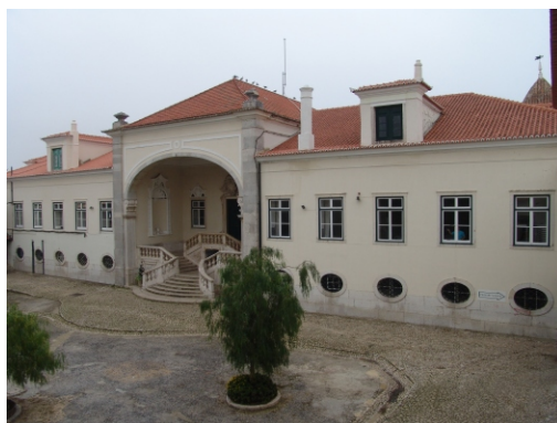
1 Alçado Sul do Pátio/fachada Norte do solar. Mário Lisboa 2006
