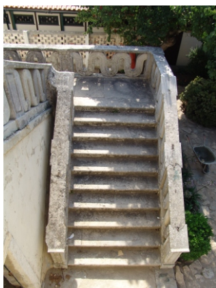
40 Escadaria Nascente de acesso à esplanada. Mário Lisboa 2006
