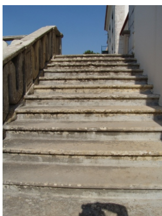
42 Escadaria Nascente de acesso à esplanada. Mário Lisboa 2006
