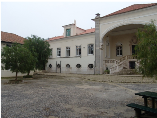
24 Pátio. Fachada lateral Nascente do solar. Mário Lisboa 2006
