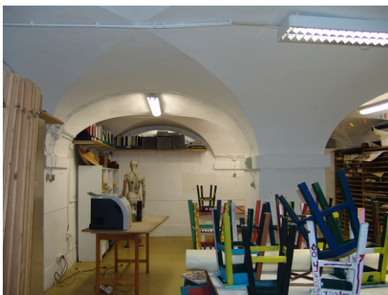
65 Sala com pilares e abóbas de aresta. Mário Lisboa 2006
