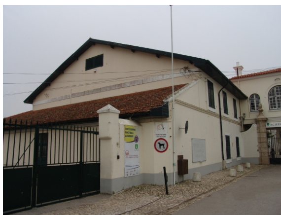
Perspectiva Norte da antiga adega, com ampliação telhada. 15 Mário Lisboa 2006
