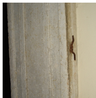
Aplicação em ferro para prender o cabo de segurança da lanterna. Mário Lisboa 2006
