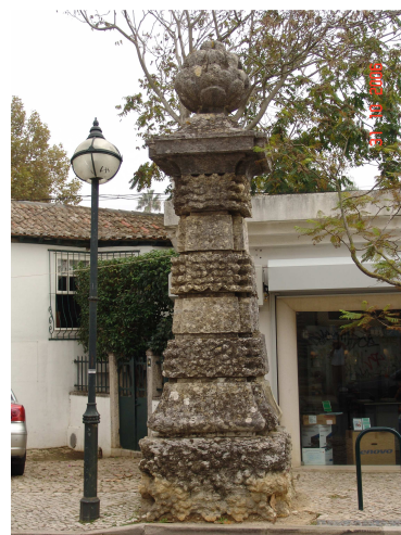
17. Pilar do Portal a Norte da quinta. Mário Lisboa 2006
