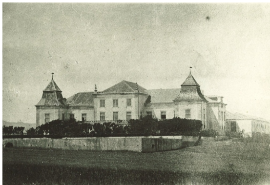
Fachada Sul do solar da Quinta Nova. 2 AHMC/PES-CALM B 112-059
