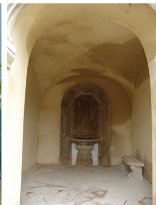
47 Sala de fresco, fonte, banco e falsa abóbada de arestas. Após restauro. Mário Lisboa 2006
