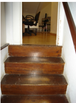
117 Imagem composta. Escada de finais do século XIX de acesso ao 3º piso Nascente. Dois lanços perpendiculares. Mário Lisboa 2006
