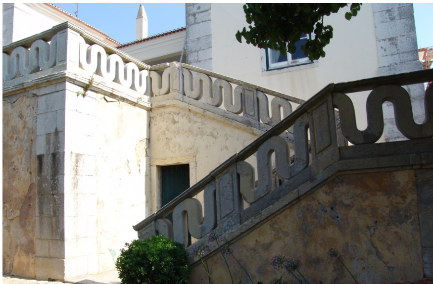
39 Escadaria Nascente de acesso à esplanada. Mário Lisboa 2006
