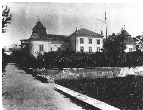
Fachada Sul do solar da Quinta Nova. 4 Porthcurno Telegraph Museum.
