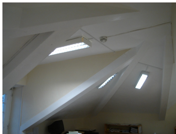
Sala. 3º piso Nascente. Vigamentos da cobertura visíveis. 118 Mário Lisboa 2006
