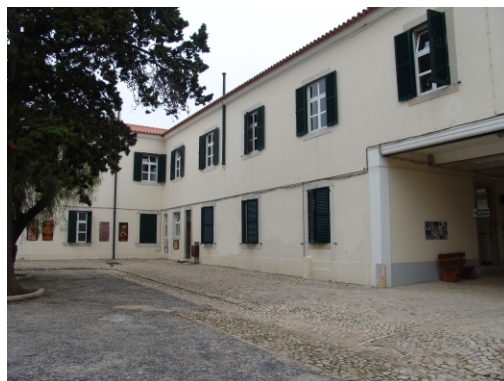
Alçado Noroeste e entrada do Pátio. 4 Mário Lisboa 2006
