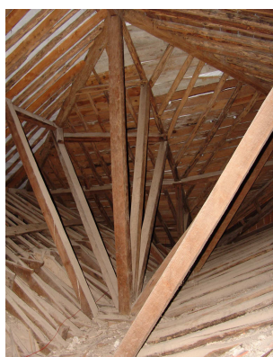
38. Estrutura de madeira de suporte da cobertura. Mário Lisboa 2006
