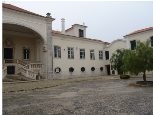
Pátio. Fachada lateral Poente do solar. 25 Mário Lisboa 2006
