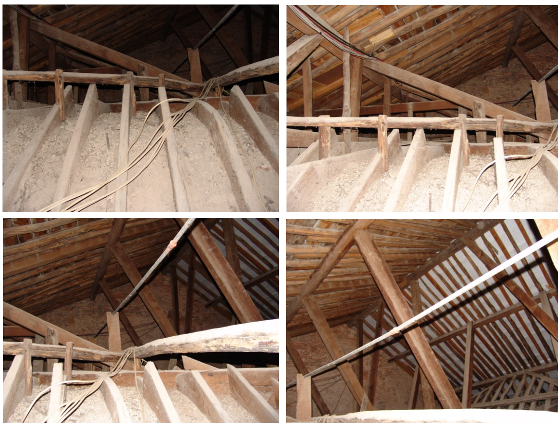
110 Imagem composta Área esconsa sob a cobertura. Estrutura de madeira da cobertura e do tecto do 2º piso. Mário Lisboa 2006
