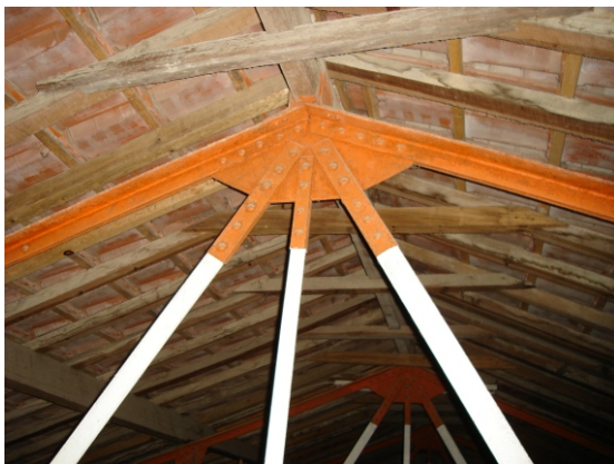
16 Estrutura metálica da cobertura da antiga adega, reestruturada na década de 1920. Mário Lisboa 2006
