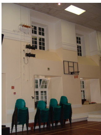
14 Novas fenestranças da década de 1920. (Espessura da parede, aprox. 1.15m) Mário Lisboa 2006
