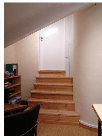
Escada de acesso a recente aproveitamento de área esconsa. 121 3º piso Nascente. Mário Lisboa 2006
