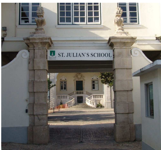
16. Portal de acesso ao pátio. Mário Lisboa 2006
