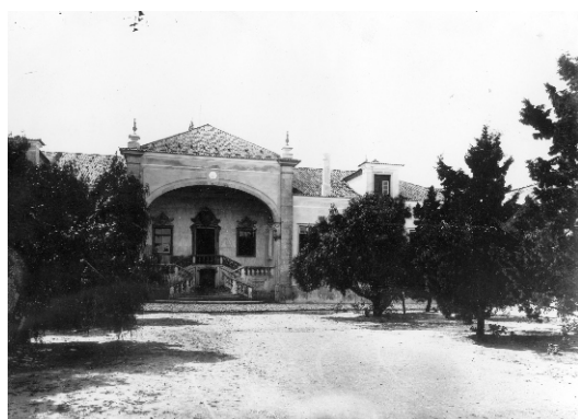
5 Fachada Norte, escadaria barroca do solar da Quinta Nova. AHMC/A74680
