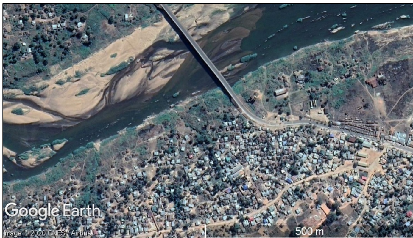
Figura 2.11: Malha urbana desordenada e a proximidade do rio Licungo.
