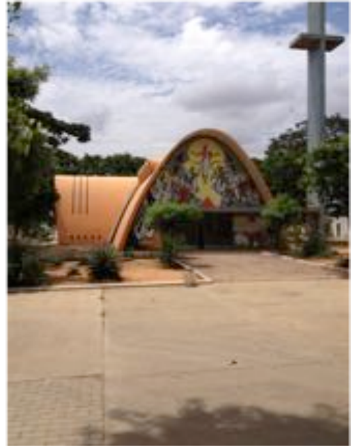
Fig.102 Vista geral Capela Cemitério Santana. Luanda
