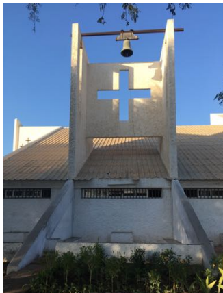
Fig. 155 Torre Sineira da Igreja de São Pedro
