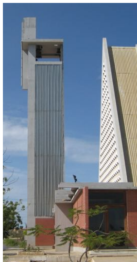
Fig.154 Torre Sineira da Catedral do Sumbe
