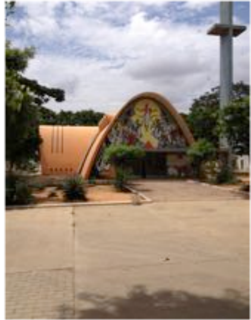
Fig.102 Vista geral Capela Cemitério Santana. Luanda
