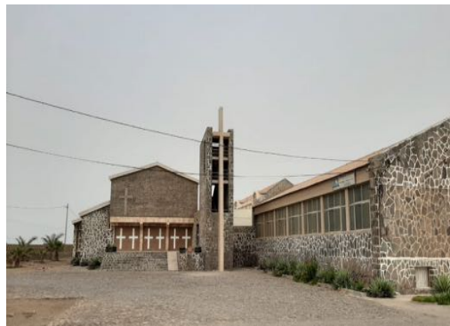
Fig.46 Igreja Seminário – Cabo Verde Fonte: César Freitas. Fevereiro 2021
