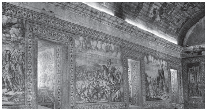
Fig. 4. Basílica Real de Castro Verde, nave; autoria: IAPC.
