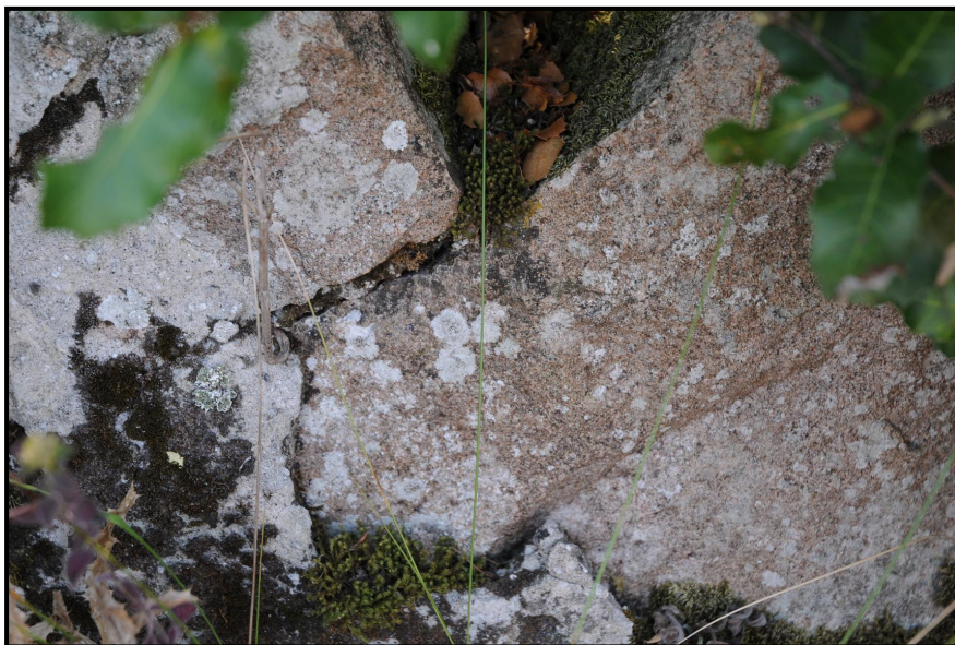
Foto Nº 24 – Pormenor da tipologia construtiva da ruína da estrutura circular encontrada em Valado dos Frades. De notar a colocação da pedra a 45°. (Foto: Carlos Fidalgo)
