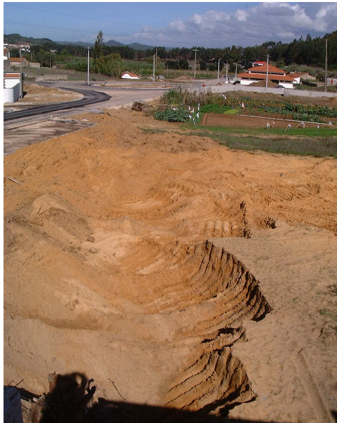
Foto: 01 e 02 – Escavações efectuadas em Famalicão da Nazaré durante a movimentação de terras, para construção de uma habitação, trouxeram ao conhecimento a composição do subsolo, areia fina, a uma profundidade de 6 metros, idêntico ao que existe na zona da várzea da Nazaré e na foz do Rio Alcoa aquando o seu assoreamento em 2003. (Fotos: Adriano Monteiro)
