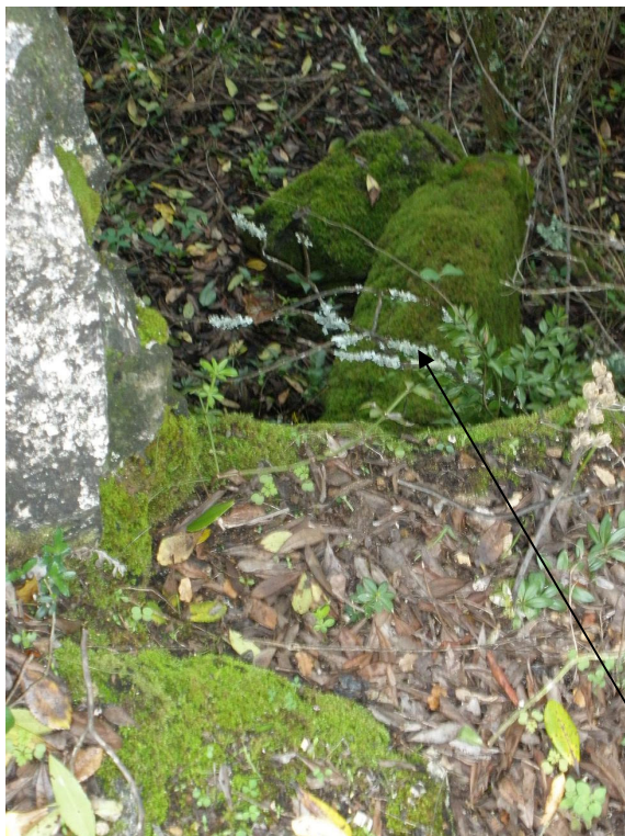
Foto: 22 – Vista interior da Cisterna, onde se podem ver duas pedras, estruturais, no interior da mesma. (Foto: Carlos Fidalgo)
