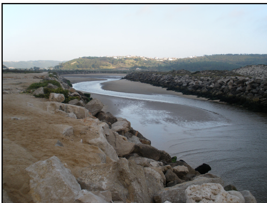
Foto: 07 – Foz do Rio Alcoa (Nazaré) em 16/09/2009. Observe-se a acumulação de areias marítimas junto às estruturas laterais, originado, desta forma, a criação de meandros e diminuição do caudal do rio junto à foz. (Foto: Carlos Fidalgo)
