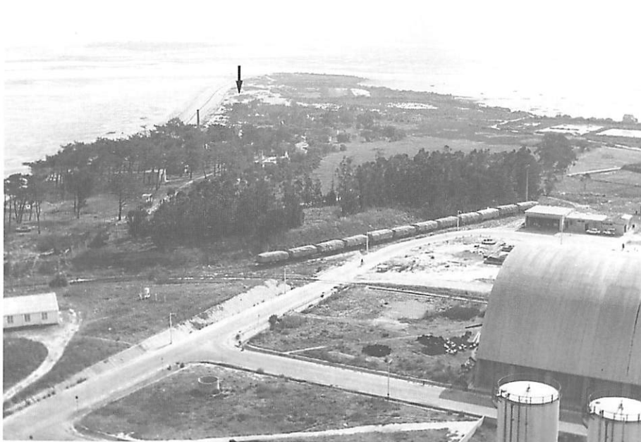
FIGURA 4 – Vista aérea da Ponta da Passadeira, em 1973, antes das obras de terraplenagens, destinadas à construção da Fisipe. A seta assinala a área ocupada pelo povoado pré-histórico. Arquivo fotográfico da Quimiparque
