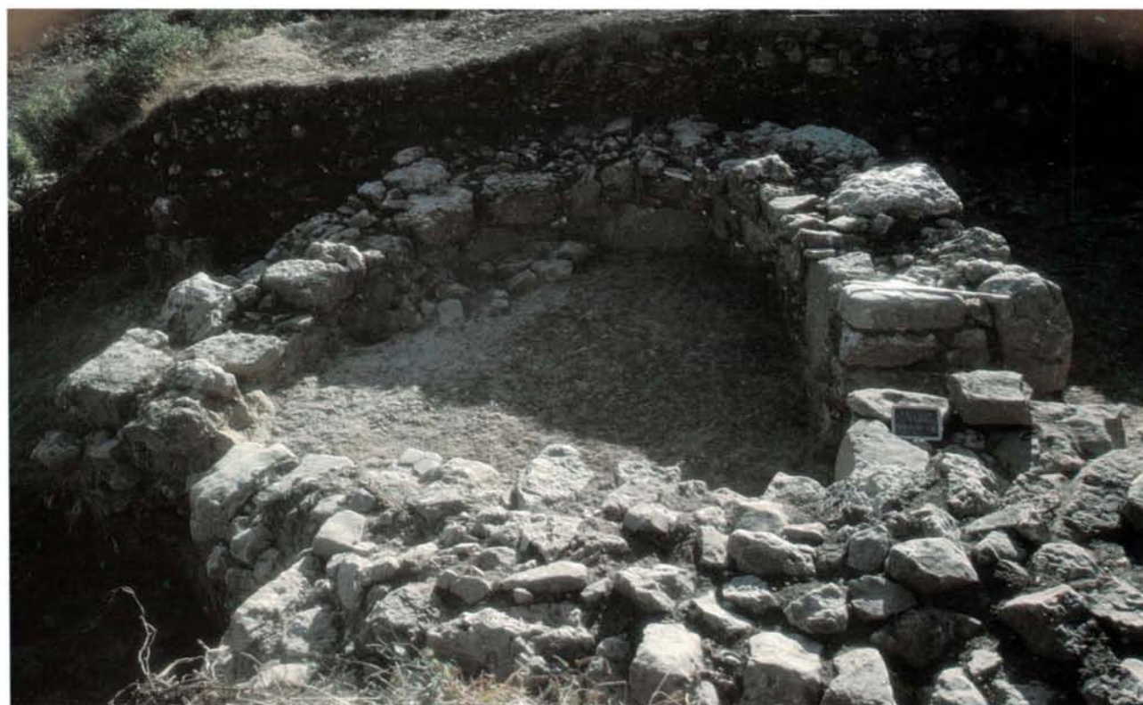
Fig. 64 — Leceia 1991. O Bastião EP (2. a Fase Construtiva), adossado à Muralha EH (2. a Fase Construtiva), integrada na primeira linha defensiva. Do lado direito, observa-se entrada comunicando directamente para o exterior do espaço defendido.
