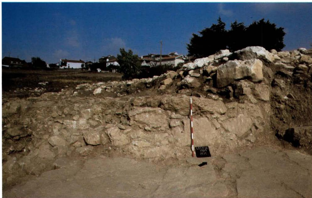
Fig. 43 — Leceia 1989. Vista do lado interno do paramento da Estrutura MM (2.ª Fase Construtiva), fundada directamente no substrato geológico, constituído por bancadas calcárias (ver Fig. 39 e 42).
