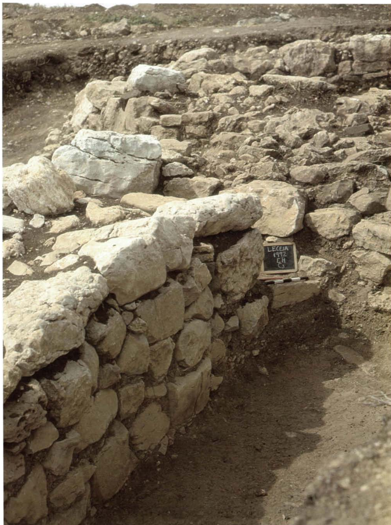
Fig. 70 — Leceia 1992 Vista parcial do paramento interno de Muralha EH, integrando a primeira linha defensiva (2. a Fase Construtiva), em 1. o plano, evidenciando aparelho regular e cuidado de blocos bem arrumados.
