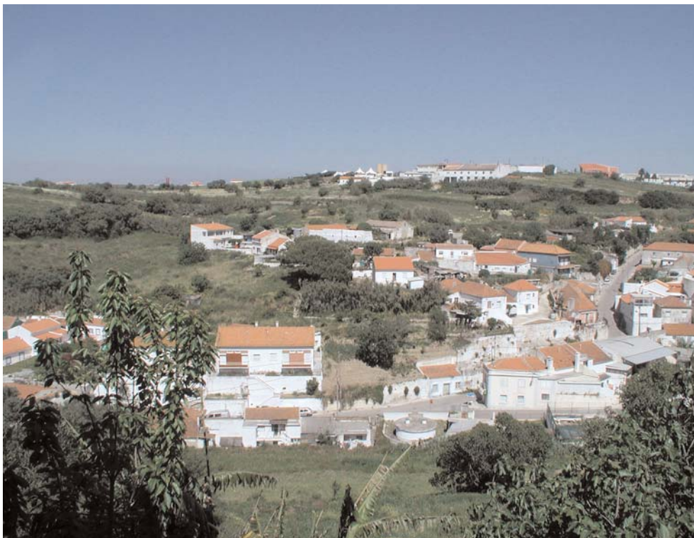
Foto 45 - Vista panorâmica da localidade da Fonte Santa, Caparica, Francisco Silva, 2007.
