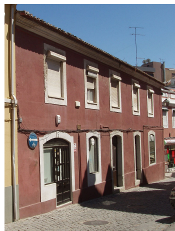
Fig. 8 - Edifício setecentista. N.º 5 da Rua João Mantas. Anabela Ferreira. 2005.
