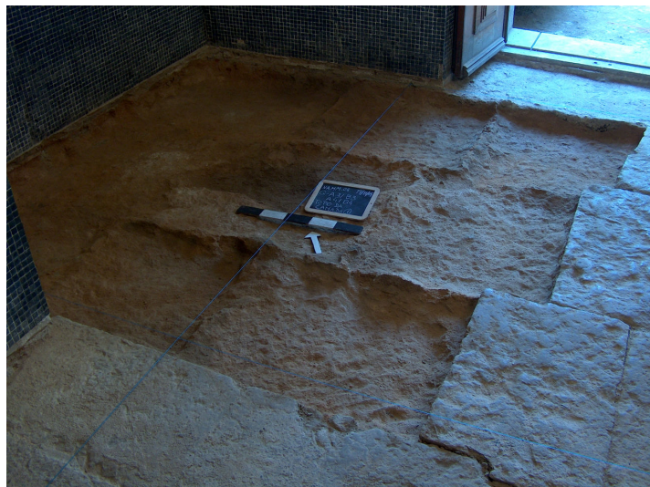
Piso empedrado na sala Nordeste do piso térreo. Zéphiro. 2004.
