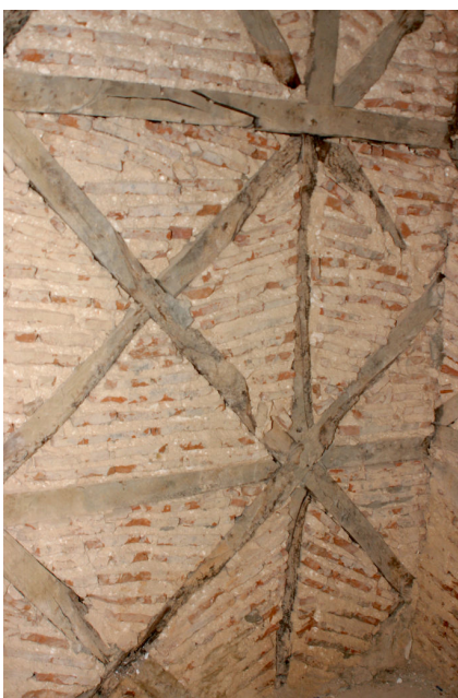
Fig. 18 – Estrutura de gaiola pombalina no primeiro piso da antiga Casa da Câmara. Ricardo Caetano. CMVFX. 2005.
