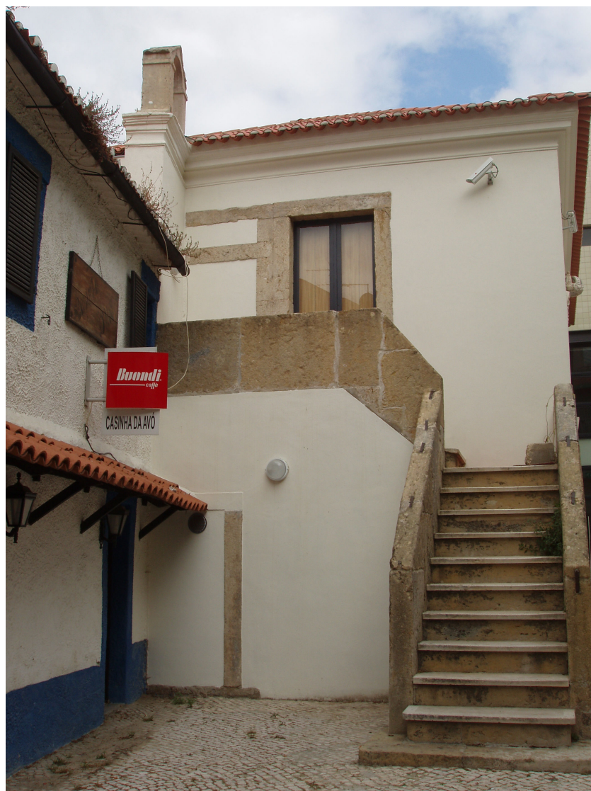
Fachada Este da antiga Casa da Câmara pormenor das escadas de acesso. Note-se as ombreiras das portas, actualmente suprimidas, da antiga cadeia – no piso térreo – e da sala de sessões da Câmara – no primeiro piso. Anabela Ferreira. 2007.
