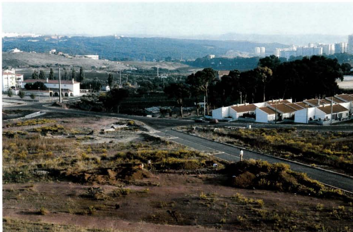
Fig. 109 - Vista geral da encosta, voltada para sul, onde se implantou a estação de Outurela I, ao centro, em primeiro plano (foto obtida em 1986, antes da urbanização do local).
