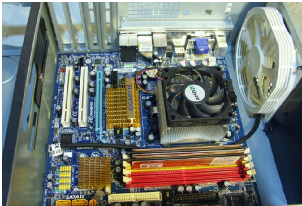
Figura 36 – Sistema computacional refrigerado a ar 28
