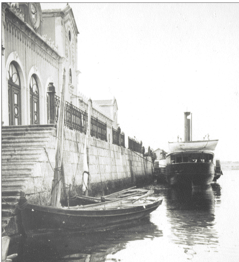
Fig. 6 – Cais da estação ferro-fluvial dos Caminhos de Ferro do Sul e Sueste (c. 1910). Fonte: CMB-Espaço Memória.
