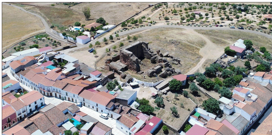
Fig. 4 – Vista aérea del castillo de Villanueva del Fresno (Imagen © del autor, 2018).
