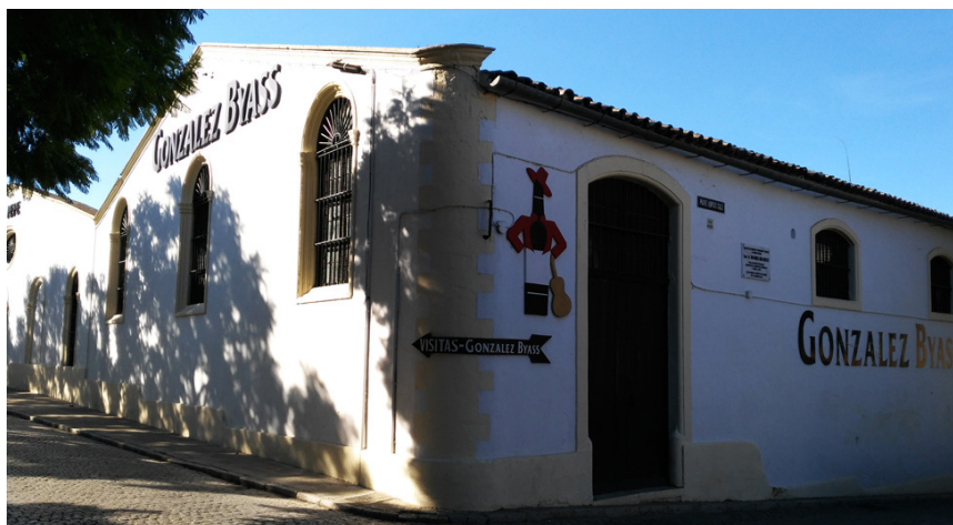
Fig. 2 – Bodegas Gonzalez Byass, Jerez de la Frontera. Exterior (Fotografia: © S. Palomares-Alarcón, 2016).
