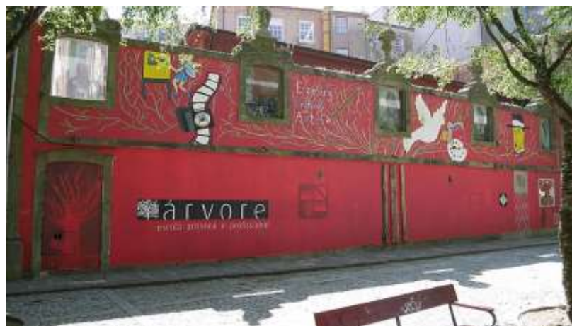
Fig. 1.6. Fachada traseira do edifício da Árvore - Escola Artística e Profissional (2014). Passeio das Virtudes (Porto, Portugal).
