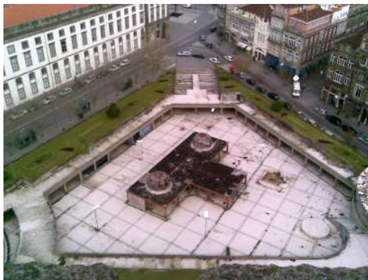
Fig. 3.14. Vista aérea do Clérigos Shopping em ruína, na Praça de Lisboa (2007).
