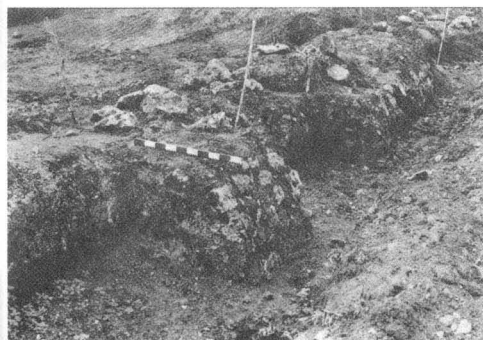
Fot.3 - Barragem do Vale Tesna do . Contrafortes de montante, na zona central.
