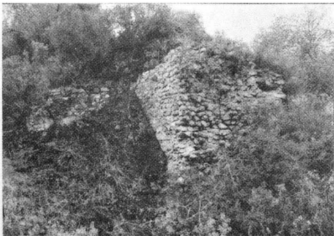
Fot.6 - Barragem da Ponte dos Mouros. Vista a partir da mar- gem esquerda, notando-se o mu- ro e o contraforte a jusante.
