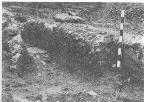
Fot.1 - Barragem do Vale Tesna do . Tomada de água para o canal do Cerro da Vila, vista do local da albufeira.
