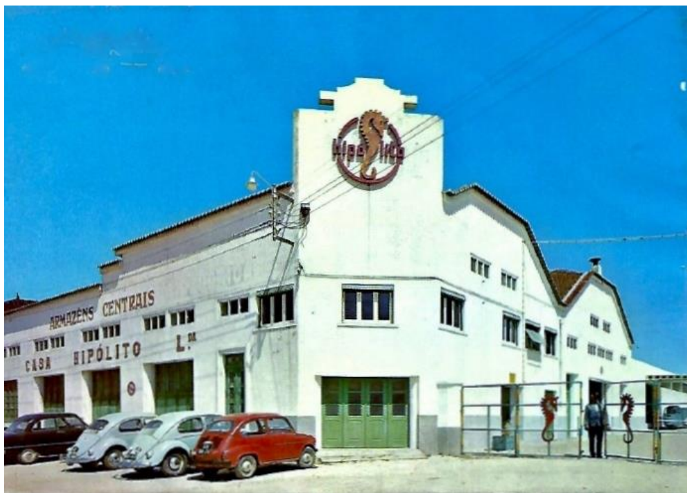
Figura 36 - Armazéns Centrais, R. Cândido dos Reis
