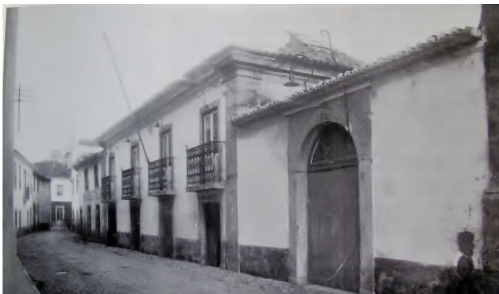
Figura 32 - Antigo Grémio Artístico Torreense, ao lado da Igreja de Santiago. Foi demolido para se construir a Fábrica A
