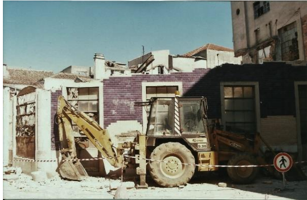
Figura 74 - Demolição da Casa
