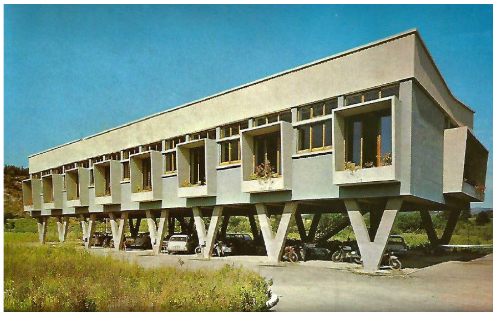
Imagem 57 - Refeitório da Casa Hipólito , em Arenes
