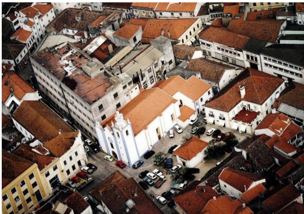
Figura 33 - Vista aérea da Fábrica A, ao lado da Igreja de Santiago
