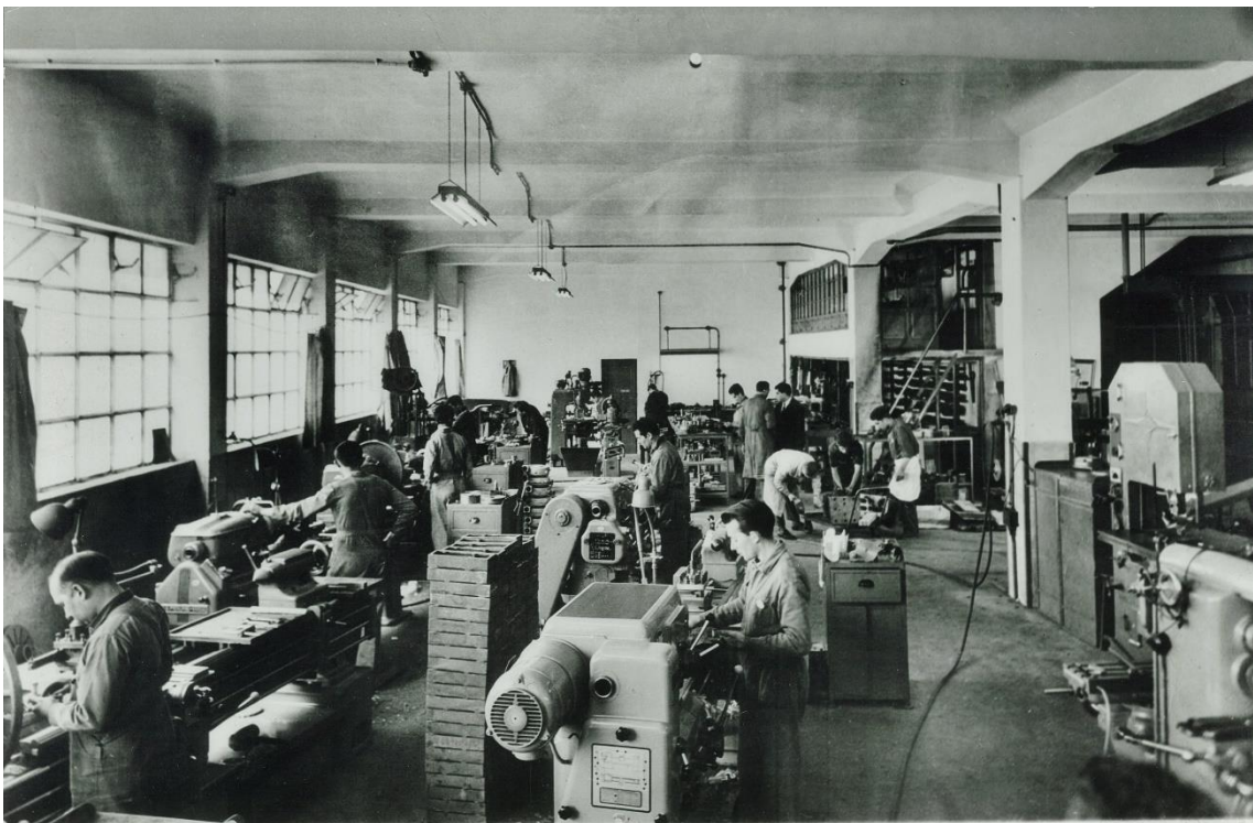
Imagem 49 - Aspecto do interior da Fábrica A
