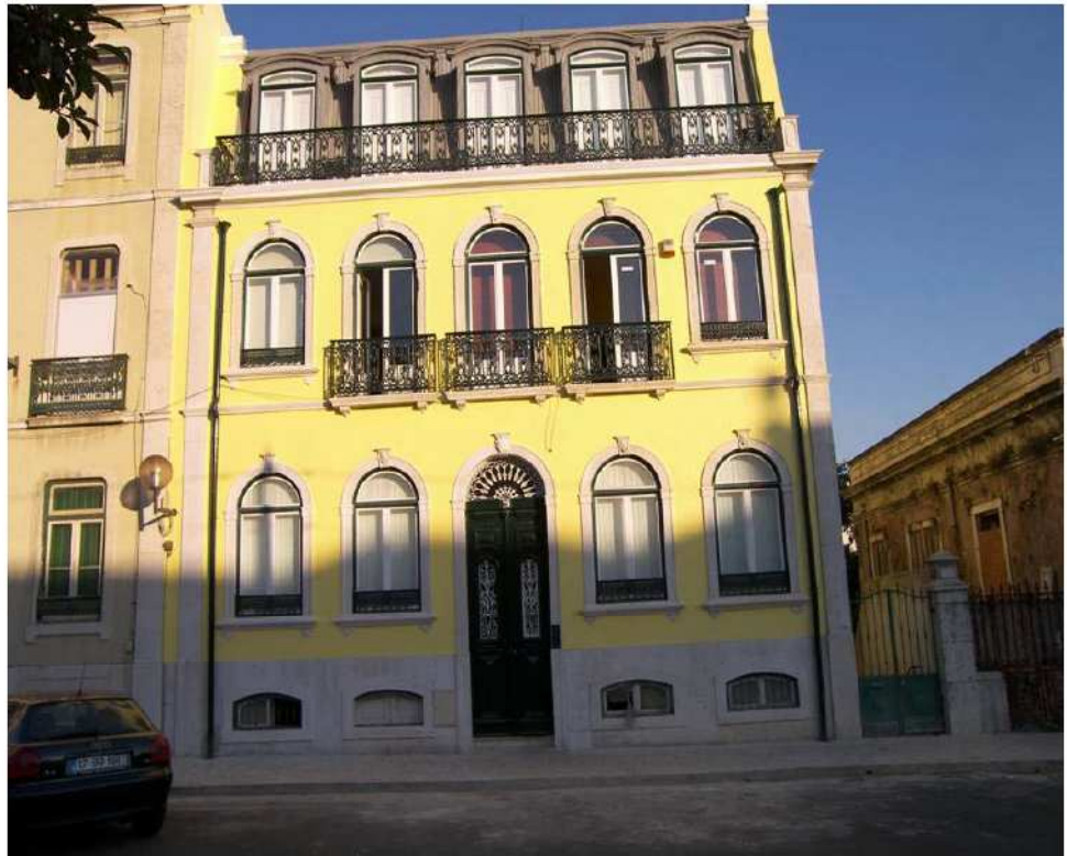
Figura 5.4 – Junqueira, Lisboa – Reabilitação de edifícios antigos.
