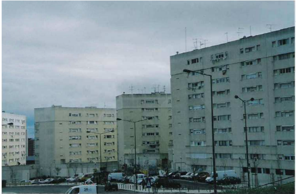
Figura 5.7 – Chelas, Lisboa – Edifícios de Habitação Social.
