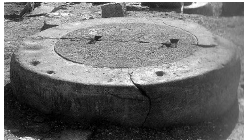
Base de uma coluna do pórtico do segundo pátio do Ramesseum, composta por dois meios tambores unidos por grampos e pontilhada na parte central de apoio do fuste. (Cf. AAVV, La Construction Pharaonique , p. 328).
