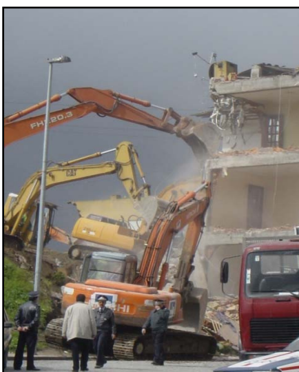
Imagem 6 – Demolição de um bloco habitacional
