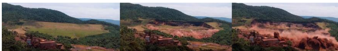
Figura 3.6. Três momentos: à esquerda, um segundo antes do rompimento da B1; ao centro, 12 segundos após o início do rompimento; à direita, 22 segundos após o início do rompimento. Fonte: Imagens capturadas e modificadas do vídeo de Globo.com, 2019.
