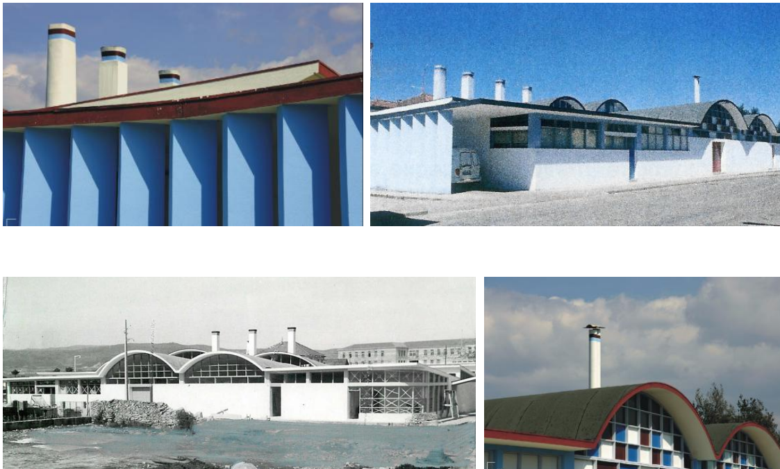
Imagem 37. Imagens da Panificadora de Chaves. Em baixo, à esquerda, em fase de construção.
