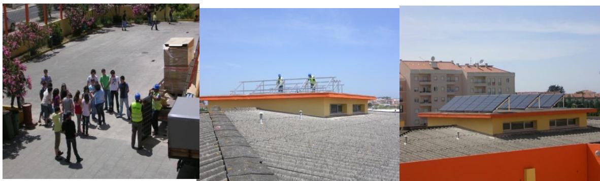
Figura 14 - Projecto Escola Mais Verde - Preparação e Instalação dos Painéis Fotovoltaicos
