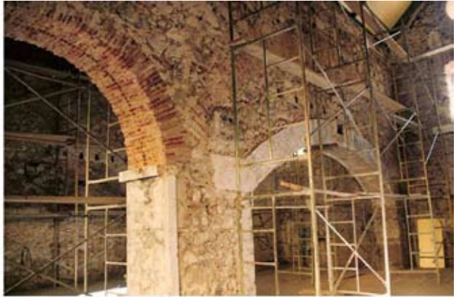
Fig 14 Trabalhos de picagem das paredes tendo em vista a identificação de pré-existências construtivas, realizados em 1996 no edifício designado por "Fábrica de Baixo", no âmbito do projecto de instalação do Museu da Pólvora Negra, inaugurado em 1998. A concepção de alguns elementos museológicos que o integram foi, nalguns casos, morosa e exigente: é o caso do sistema de galgas, cujo projecto de execução parcialmente se reproduz.
