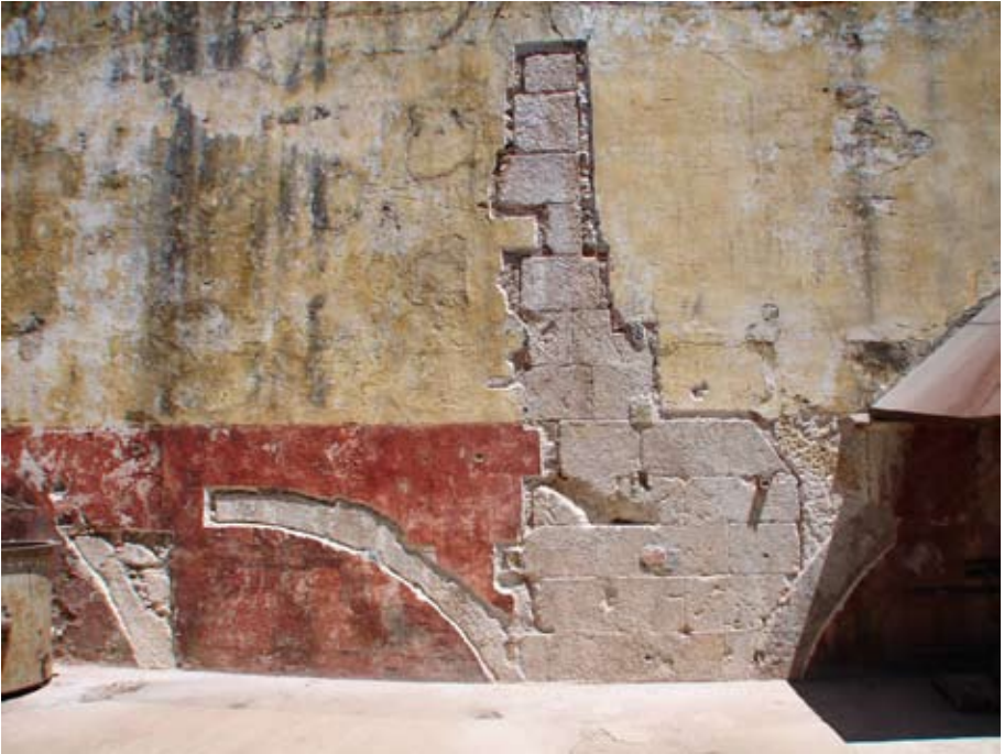
Fig. 12 Aspecto dos trabalhos conducentes à identificação de diversas fases construtivas no edifício das antigas “Ferrarias d’El Rey”, em 2007, depois da sua identificação como tal, com base em planta de Leonardo Turriano, que se manteve inédita até 2005, ano em que foi publicada, por J.L. Gomes e pelo signatário.
