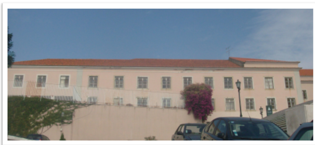
Vista Exterior Conventinho do Desagravo (Fotografia de Autor)
