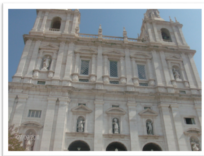
Fachada Principal da Igreja de S. Vicente de Fora (Fotografia de Autor)
