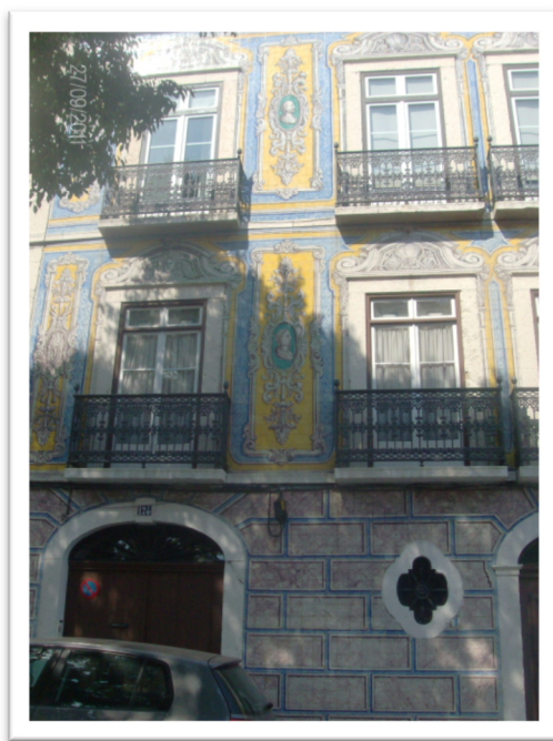
Vista da fachada do Palácio nº 125 do Campo de Santa Clara (Fotografia de Autor)
