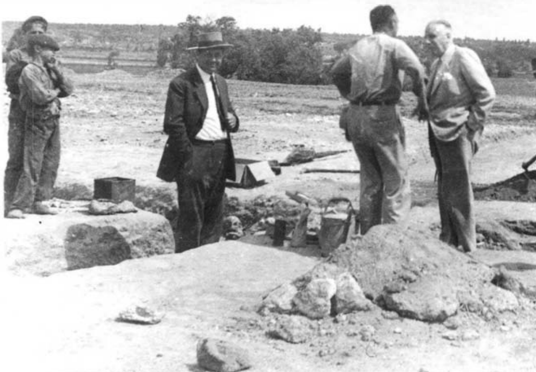
Fig. 27 - Escavações de 1952 do concheiro da Moita do Sebastião. Visita aos trabalhos de G. Zbyszewski (à esquerda) e Mendes Corrêa (à direita). Ao centro, J. Roche (Foto de 14/6/1952).
