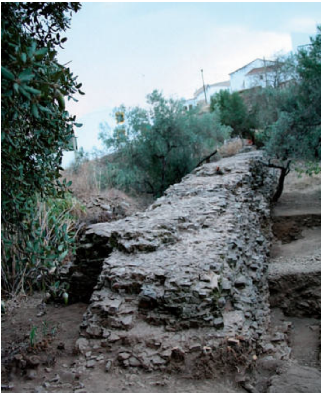
Vista de norte da barragem em 2007
