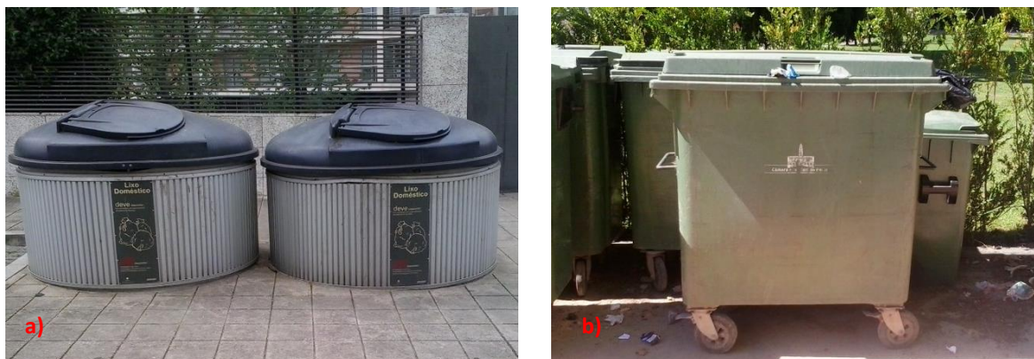
FIGURA 4.9 – Tipos de equipamentos para Recolha Indiferenciada a) Contentor Subterrâneo tipo Molock b) Contentor 800 l
