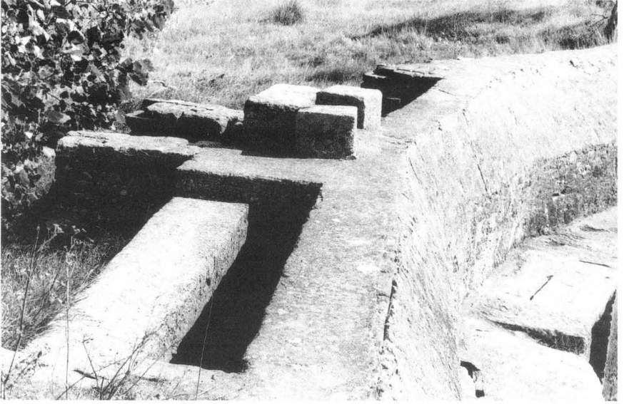
Fig. 7: Conde. Pozos del aliviadero de superficie y desagüe de fondo en el centro.
