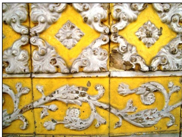
Fig.79 – Pormenor dos azulejos relevados a duas cores, amarelo e branco, que revestem a fachada do prédio do nº 194 da Rua Antero de Quental, no Porto.
