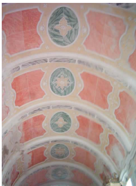
Fig. 34 – Convento do Espinheiro – cobertura de meio canhão da nave
