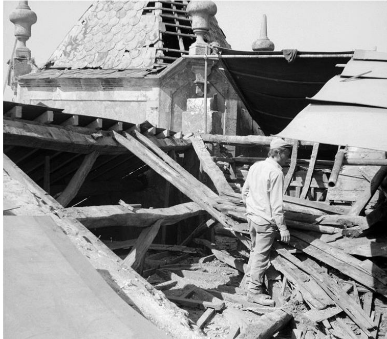
Figura 3.2.- Obras no Palácio do Freixo em 1987, onde é visível a degradação do Palácio. 13
