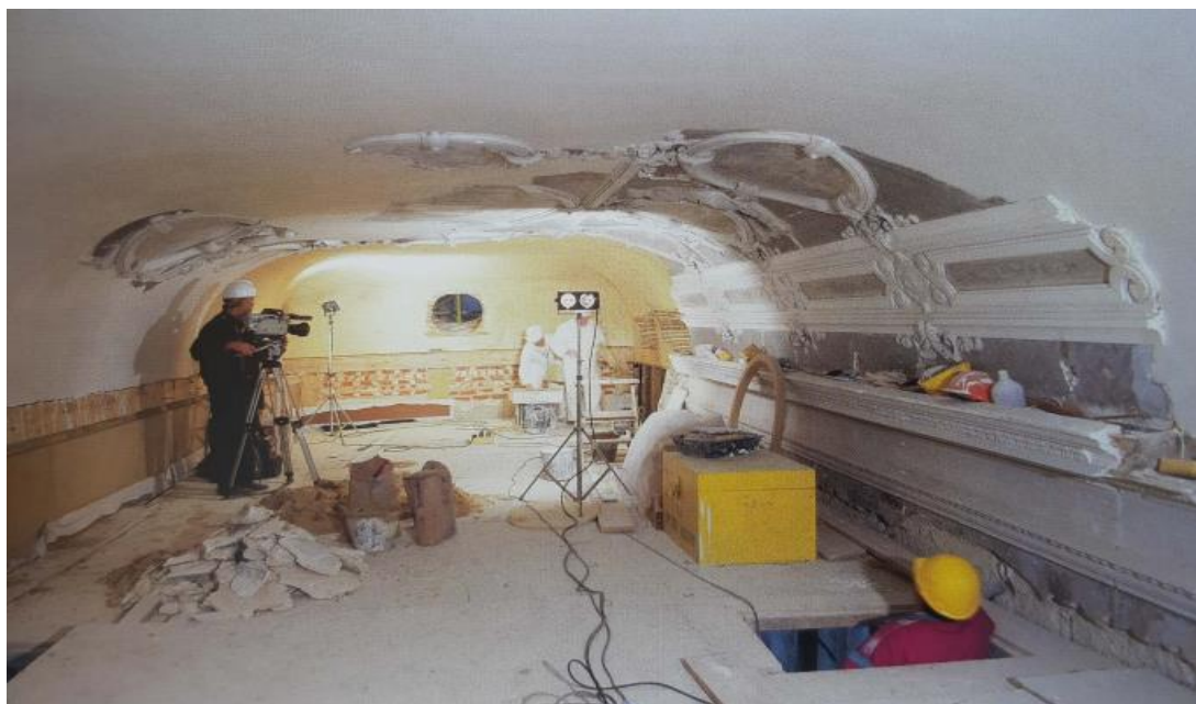
Figura 4.25. - Processo de conservação e restauro num corredor interior do Palácio (Alves & Piqueiro, 2003).
