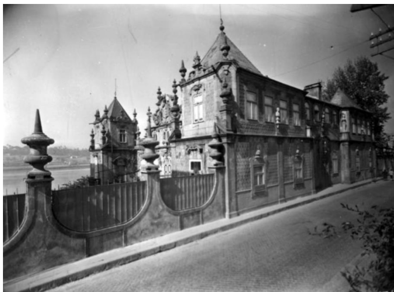
Figura 1.4. – Perspetiva geral da aplicação das placas de lousa cinzenta e cimento, em forma de escamas, nas fachadas este e norte. – Arquivo Municipal do Porto.
