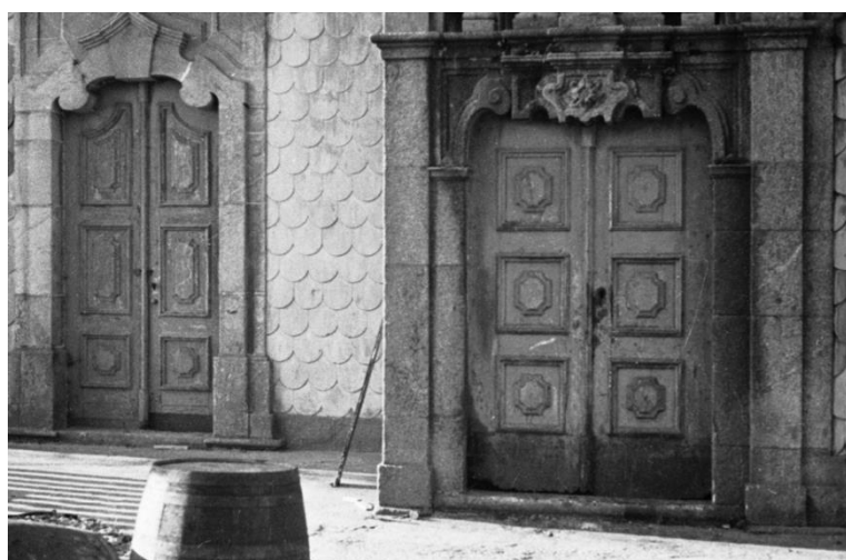
Figura 1.1. - Pormenor da fachada sul que evidencia as placas de lousa cinzenta e cimento, em forma de escamas. – Arquivo Municipal do Porto.
