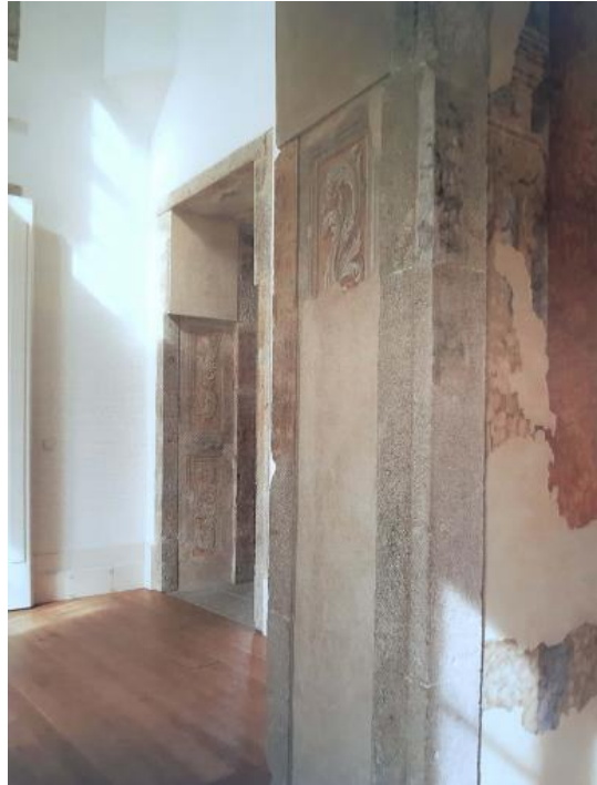
Figura 4.35. – Interior do Palácio do Freixo já recuperado (Alves & Piqueiro, 2003).
