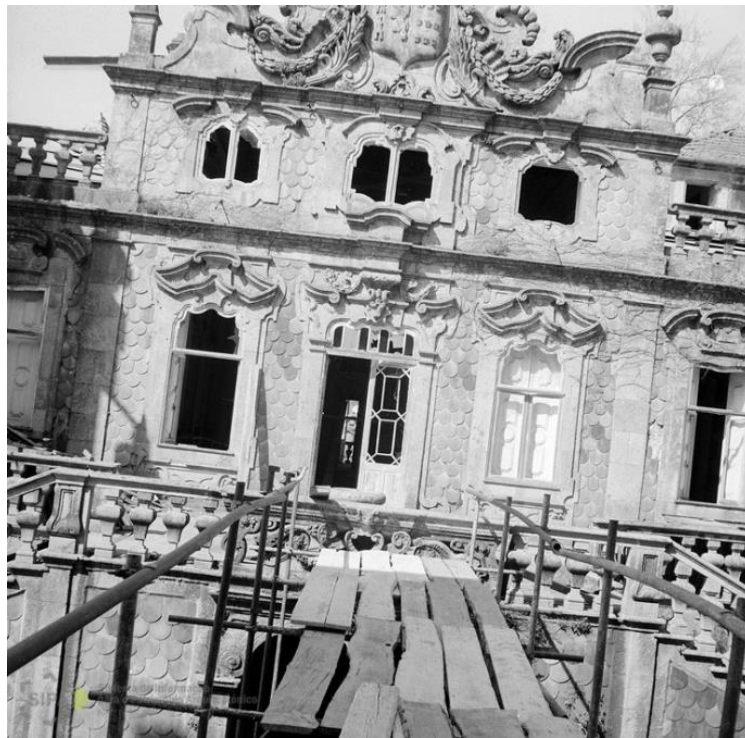
Figura 3.1.- Obras no Palácio do Freixo em 1987. 12
