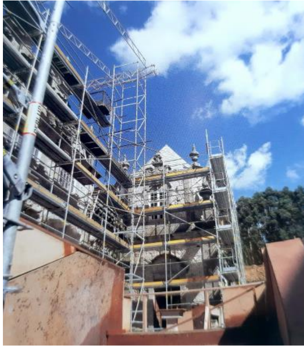
Figura 4.18.- Início das obras de recuperação do Palácio do Freixo (Alves & Piqueiro, 2003)
