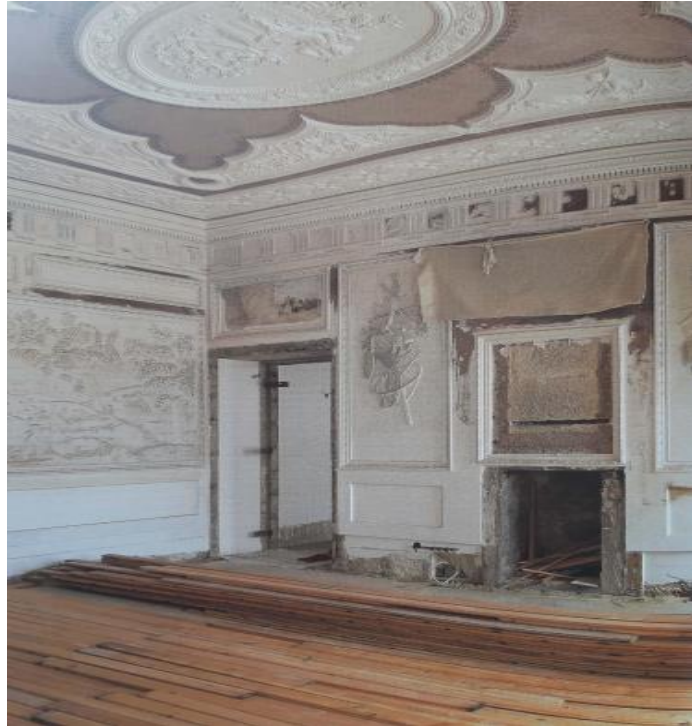
Figura 4.27. - Processo de conservação e restauro no interior do Palácio - Sala do Visconde Velado (Alves & Piqueiro, 2003).
