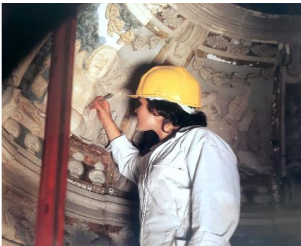
Figura 4.20. - Processo de conservação e restauro no interior do Palácio. Pormenor de uma parede (Alves & Piqueiro, 2003).
