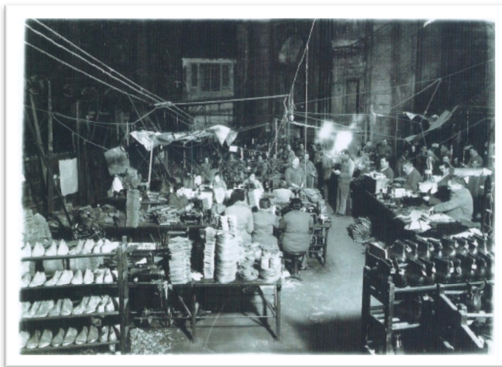
Fig. 29 - Fábrica de calçado militar a funcionar nas instalações da Igreja de Santa Engrácia (1939), “Obras de Santa Engrácia – O Panteão na República”, p, 70.
