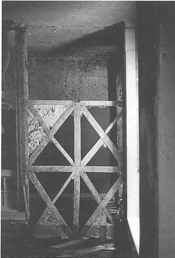
Partes de uma estrutura de gaiola , observadas num edifício da Baixa
