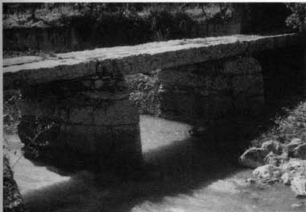
Fig. 6 Talhamares da ponte da ribeira da Lage.
