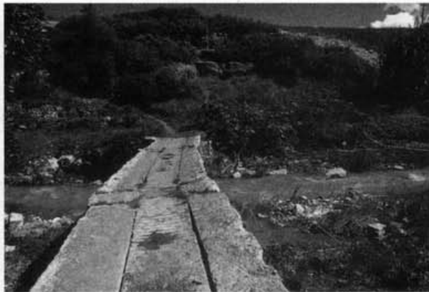
Fig. 7 Lajões constituintes do tabuleiro da ponte da ribeira da Lage.
