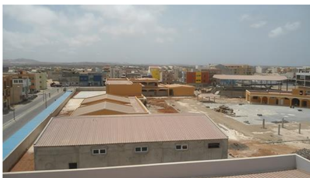
Ilustração 5: Vista aérea da ESBV durante as obras de ampliação (5ª fase) 24
