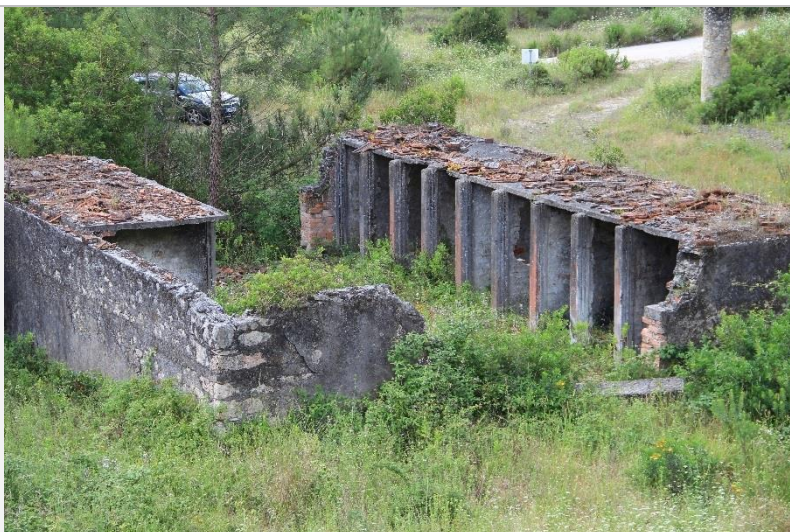
Figura 3 – Depósito de cal, 2019
