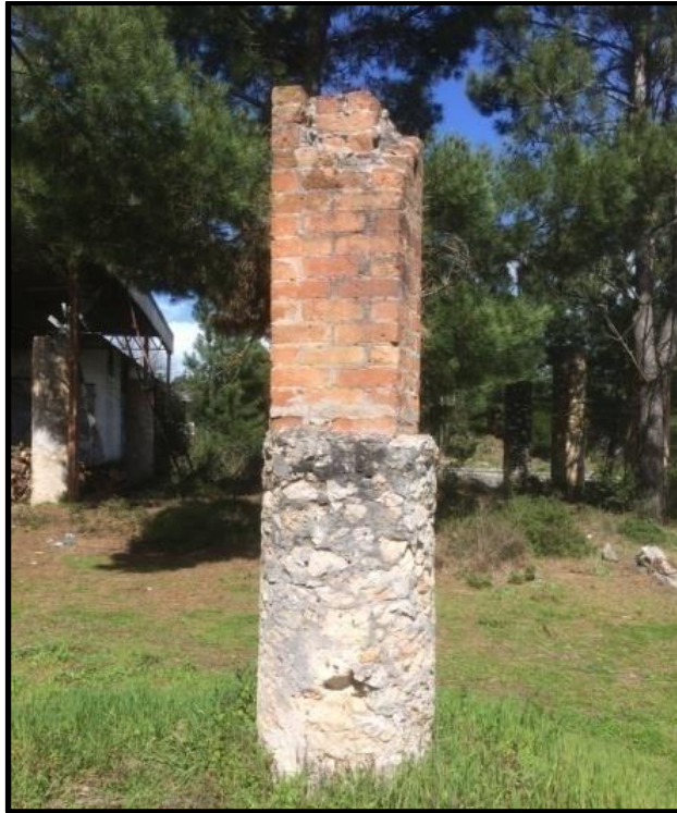
Figura 42 – Pilar quadrangular com base cilíndrica do barracão do forno RO 7
