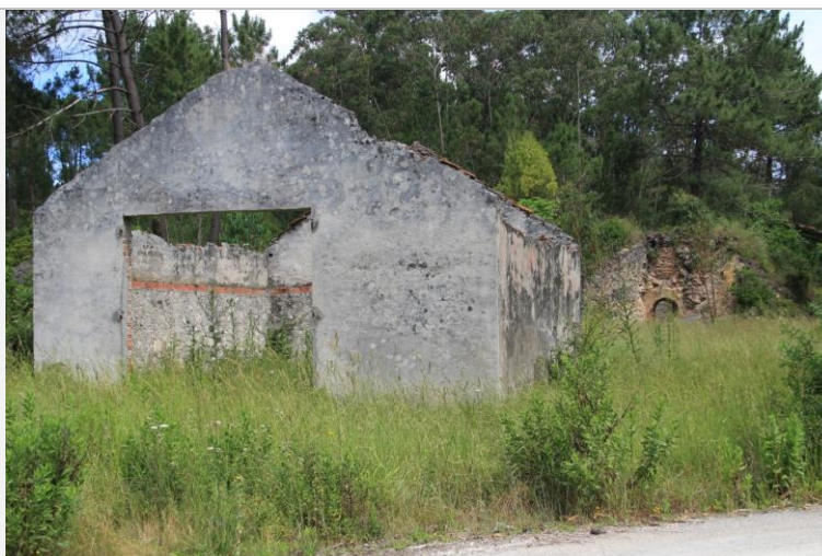
Foto 3 – Ruínas do depósito de cal. Ao fundo o forno, 2019
