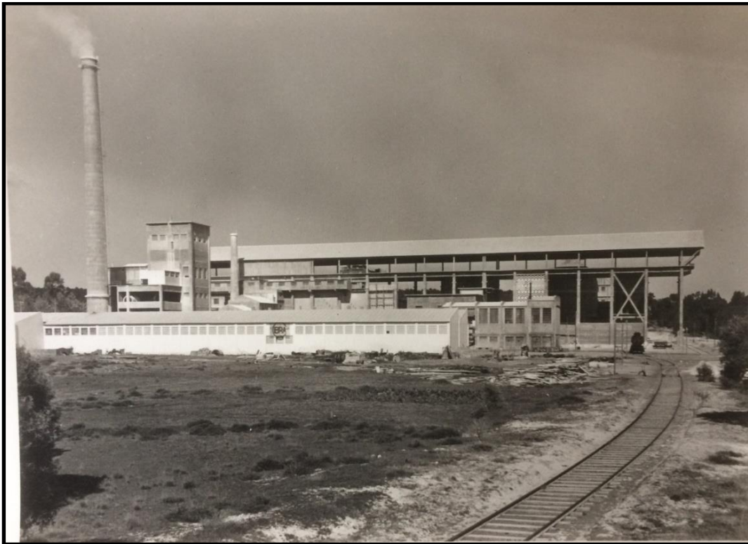
Figura 82 – Ramal Ferroviário da Cibra
