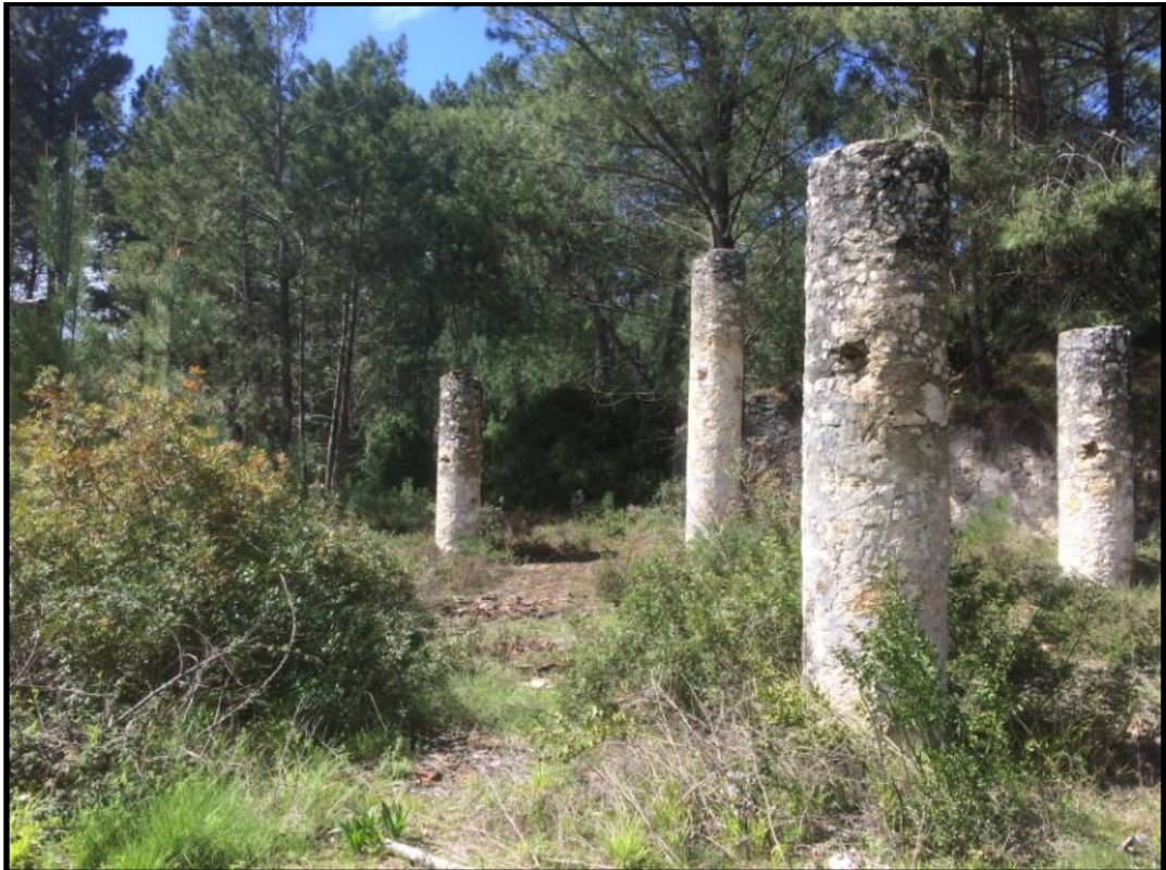
Figura 41 – Pilares cilíndricos do barracão do forno B 11
