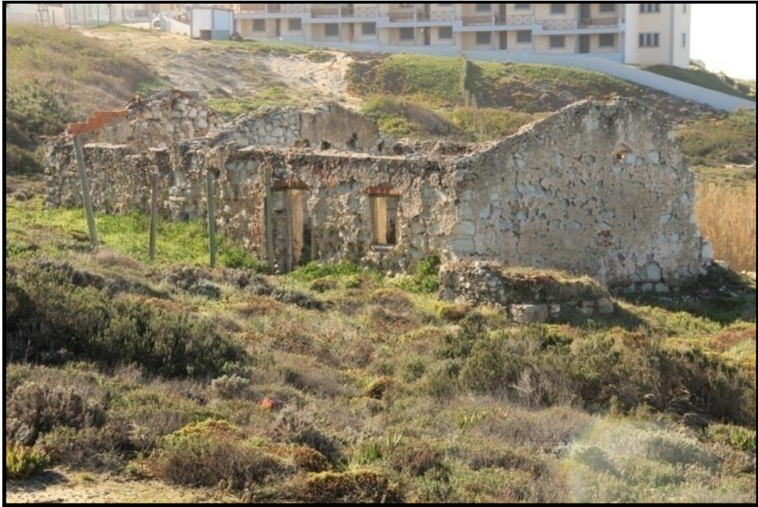
Figura 83 – Ruínas do armazém / arrecadação na Pedra do Ouro
