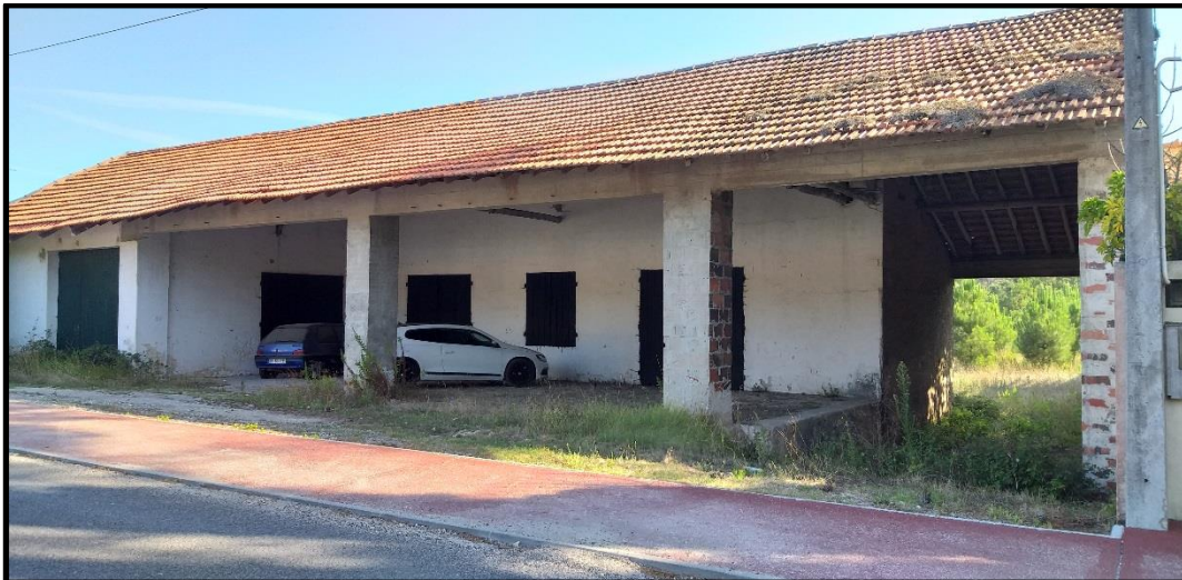
Figura 47 – Depósito de cal de António Rosálio Vieira
