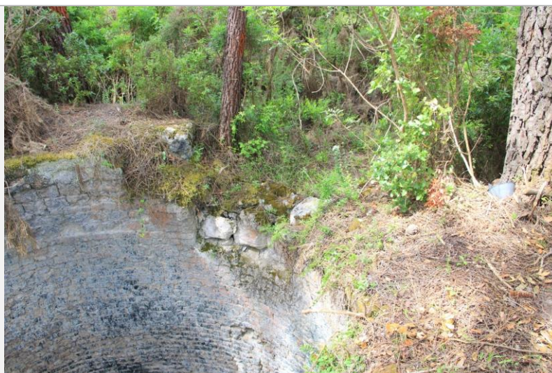
Figura 3 – Portal superior do forno, 2019
