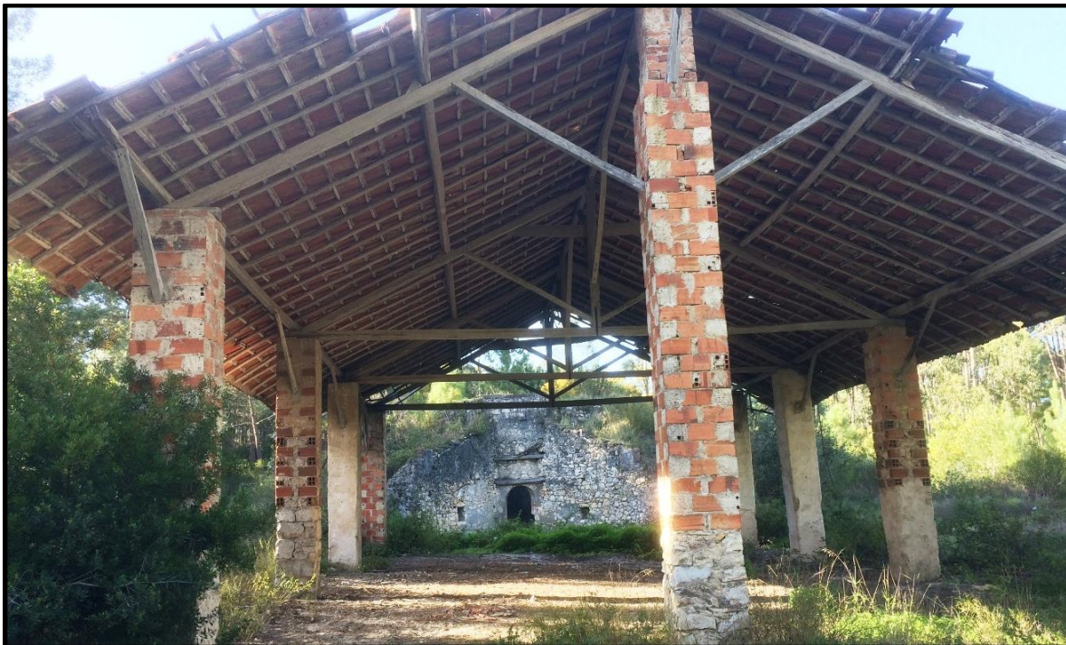
Figura 5.3 – Barracão do forno B 17
