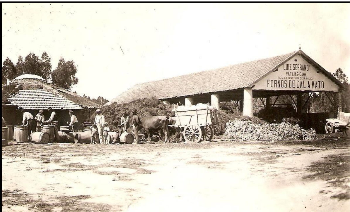
Figura 4.5 – Fornos de cal dos Serranos
