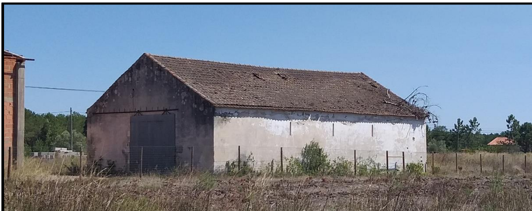
Figura 48 – Depósito de cal de António Vieira Vaz
