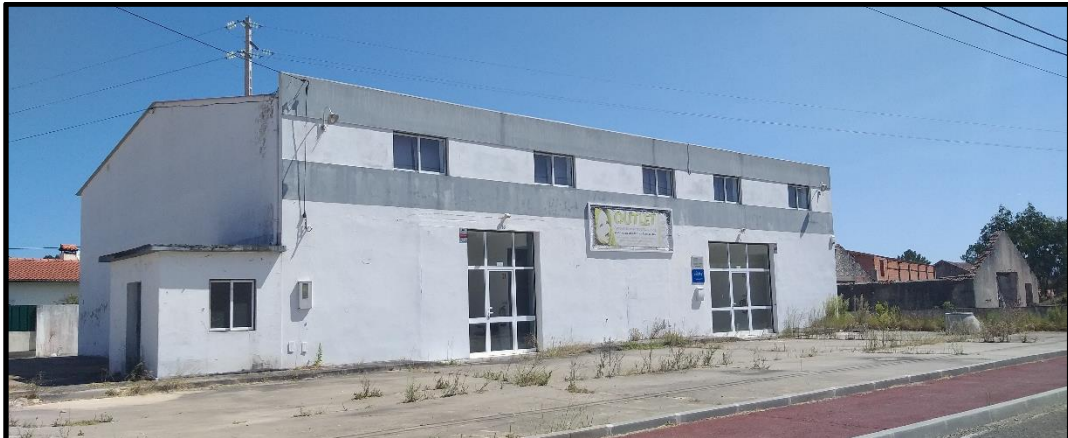
Figura 51 – Depósito de cal de António de Sousa Coutinho (Coutinhos & Salgueiro)
