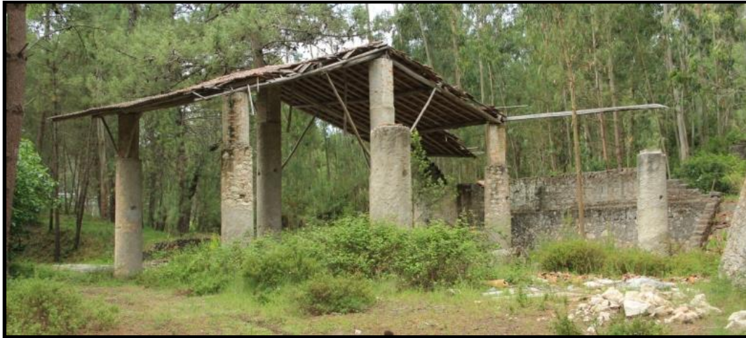
Figura 46 – Barracão do forno B 8
