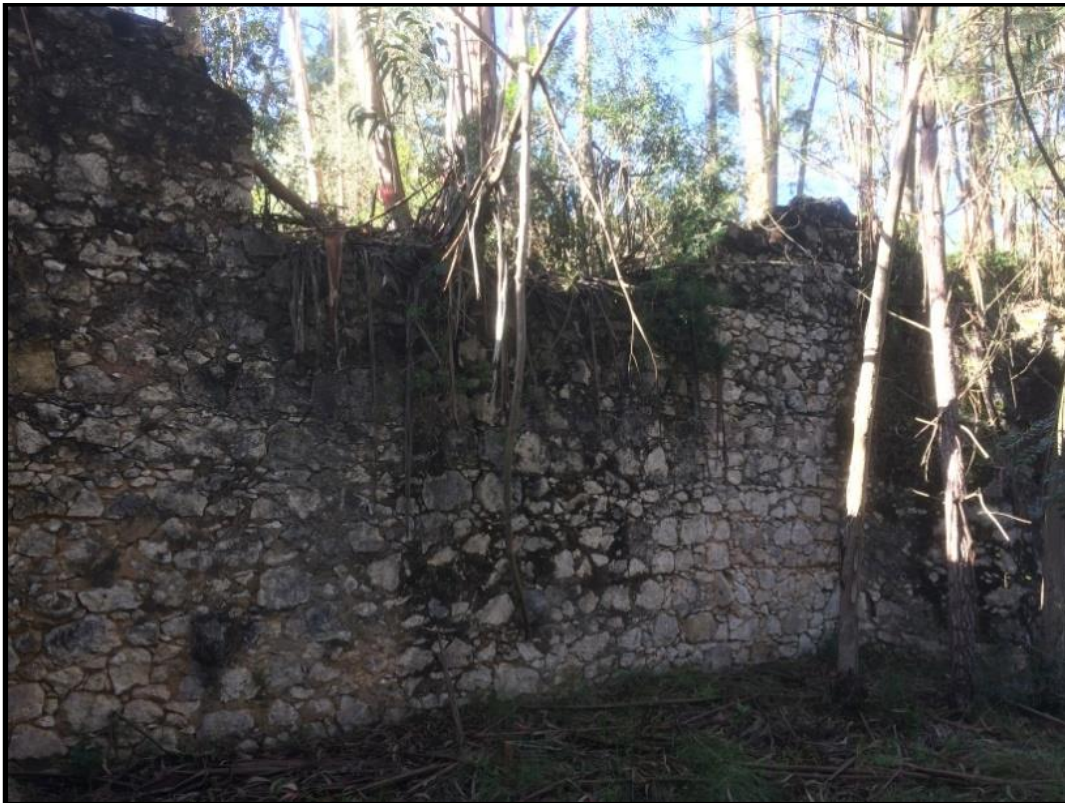
Figura 43 – Muro de suporte do morro sobranceiro do forno B 7
