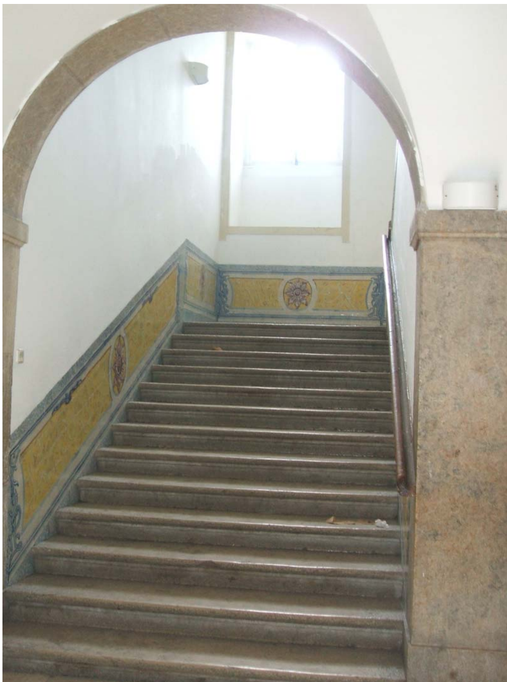
71. Escadaria principal, vendo-se o silhar de azulejos primitivo
