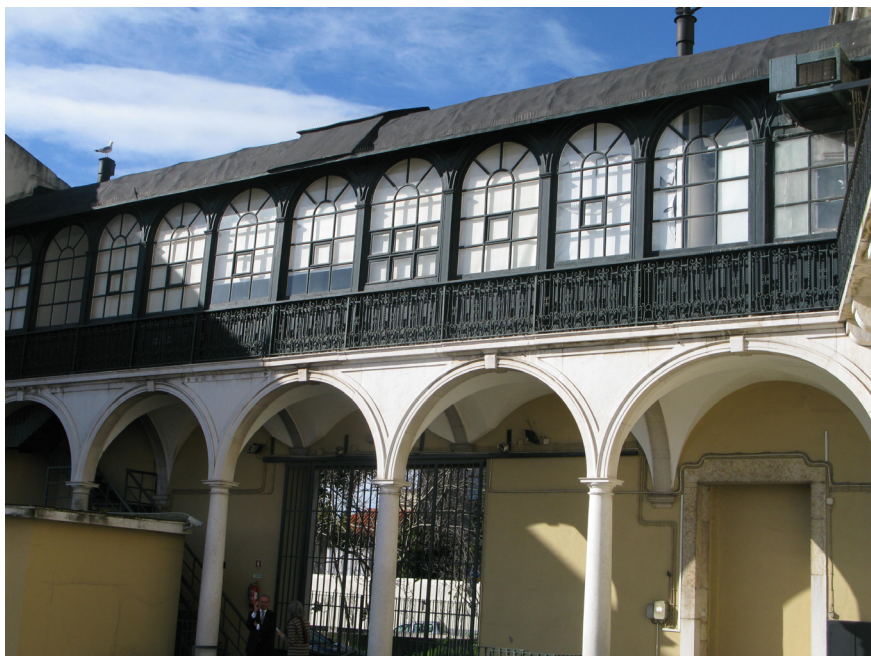
Figura 18 – Palacete Pereira da Costa, fachada interior da galeria.
