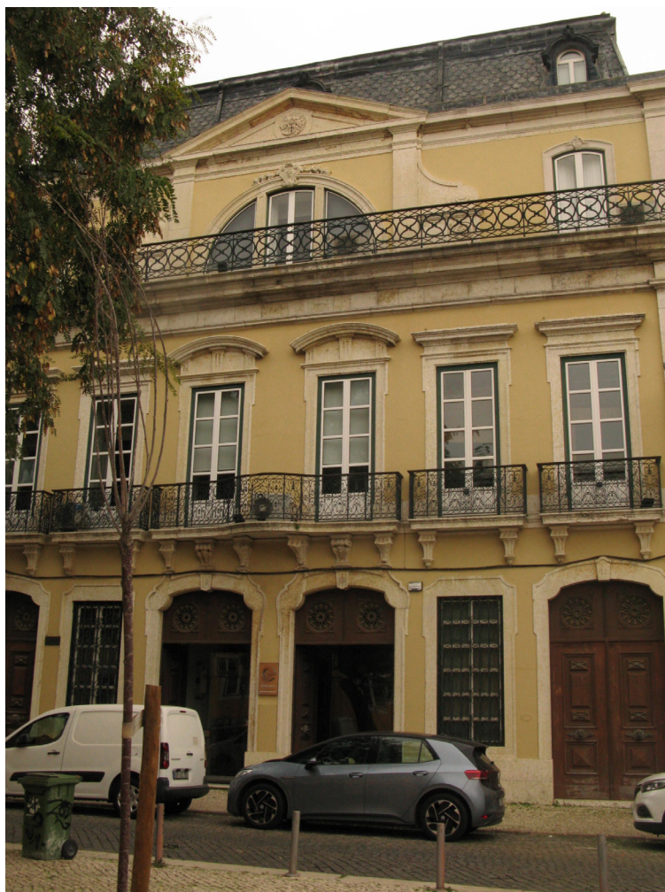
Figura 7 – Palacete Pereira da Costa, fachada.
