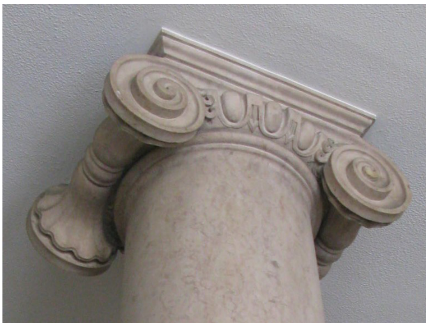
Figura 12 – Palacete Pereira da Costa, pormenor dos capitéis do átrio.
