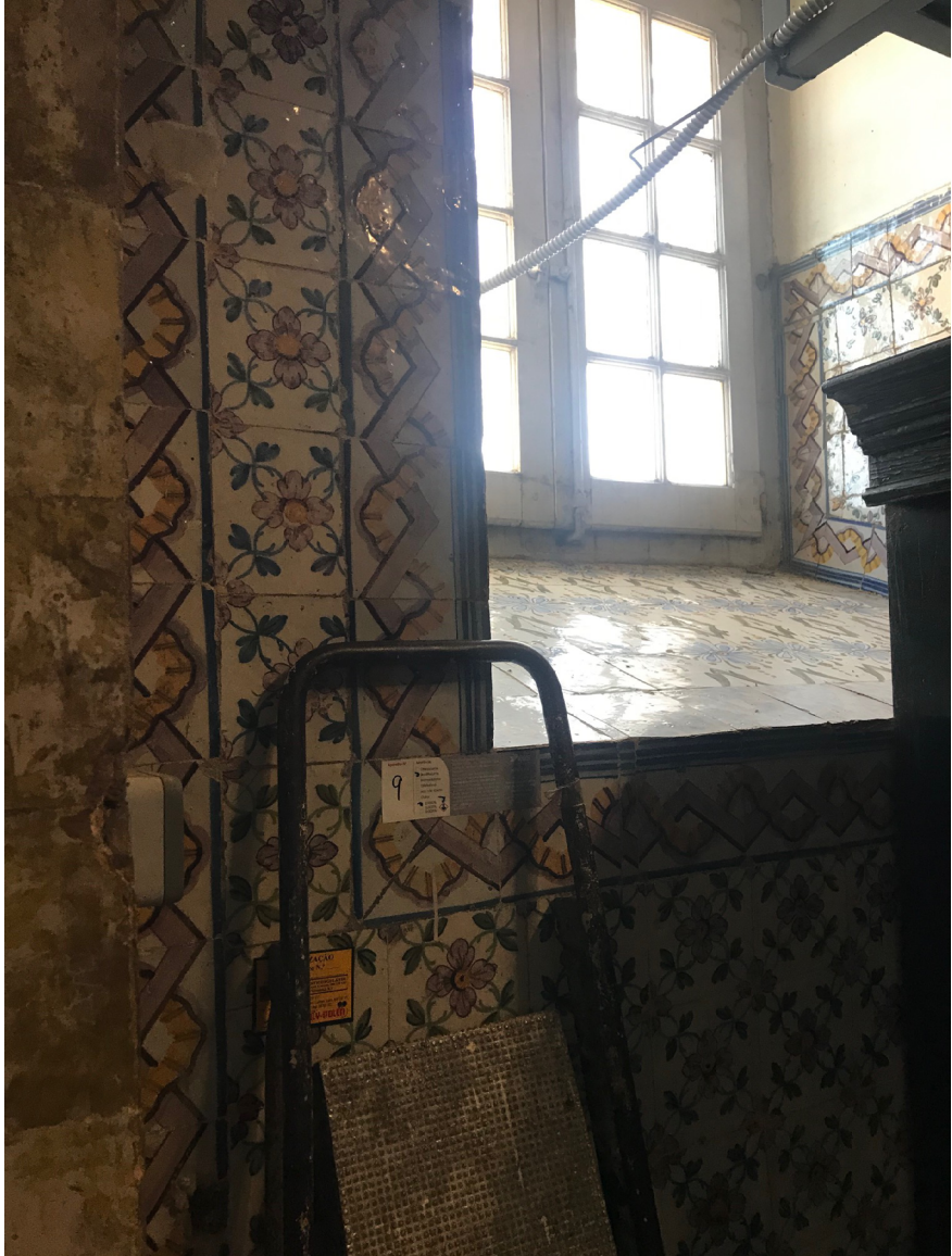
Figura 26 – Cave de acesso interno com o revestimento de paredes em azulejo policromo pombalino. © Alexandra Trindade Gago da Câmara.
