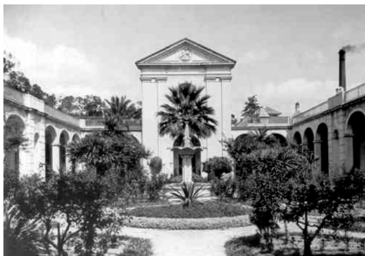
Figura nº 37 – Hospital de D. Estefânia – Claustro
