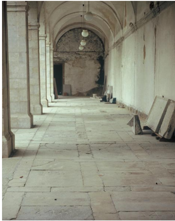
Fig. 23 – Aspecto do chão de alvenaria aparelhada da ala poente do claustro, com lajes numeradas, cuja disposição reflecte a estrutura dos alvéolos subjacentes, semelhantes aos identificados e postos a descoberto na ala sul do claustro (Foto de J. L. Cardoso).
