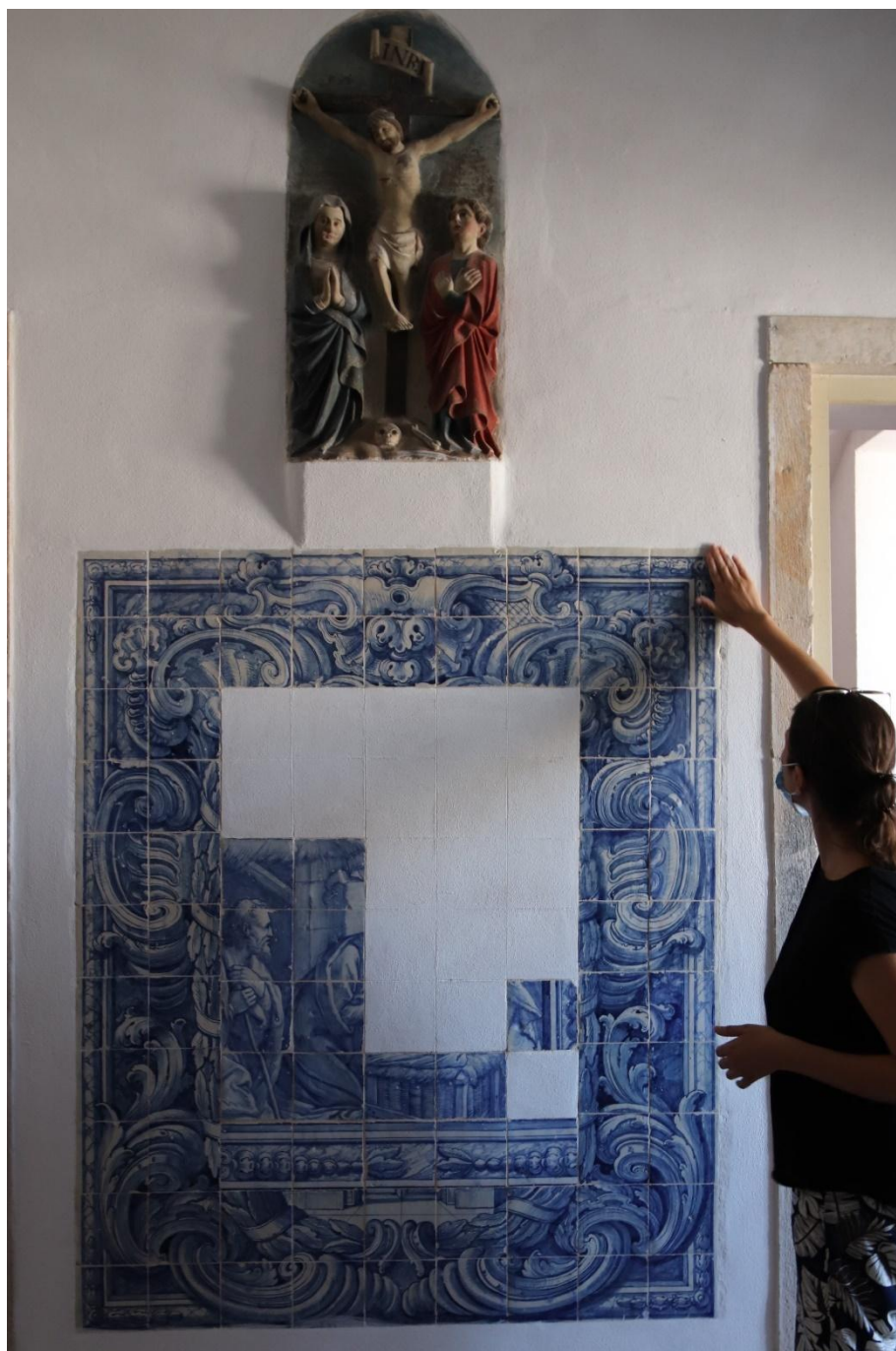
Imagem de azulejos em falta num painel da Sacristia da Igreja dos Capuchos.
