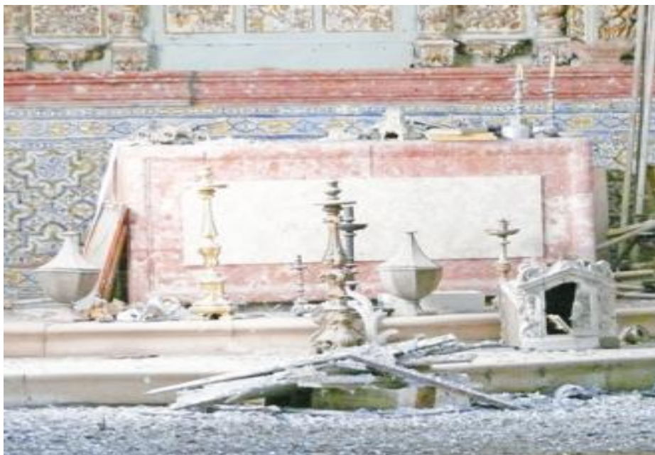
Figura 31 – Pormenor das obras de recuperação da Igreja de Santa Iria - Foto obtida por António Valente 2021-02-12
