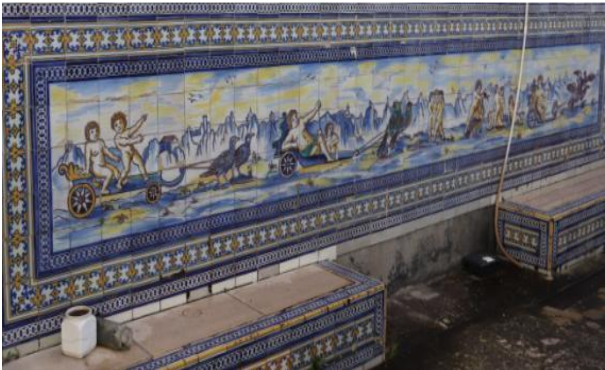
Figura 36 – Pormenor na parede lateral do jardim dos Paços do Concelho
