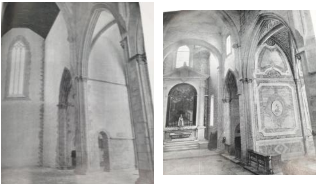
Figura 25 –. Capela de São Nicolau, antes e depois das obras - Foto obtida por António Valente, retirado do Boletim da DGEMN 65, autor desconhecido
