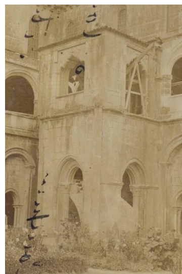
FIGURA 3 – Edícula da Galeria Sul, durante o restauro de Fuschini
