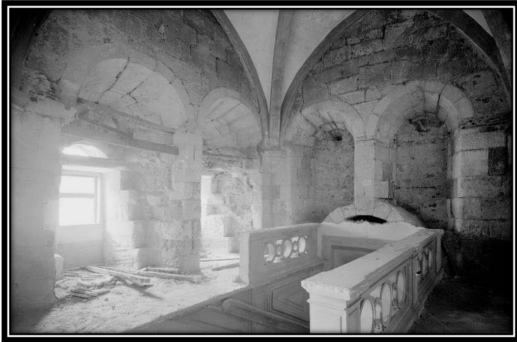
FOTO 309: 1º Piso do Dormitório
