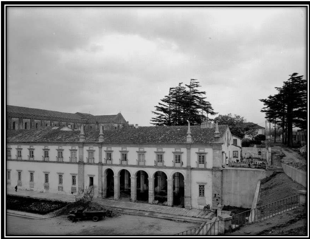
FOTO 426: Fachada Poente da Ala Sul
