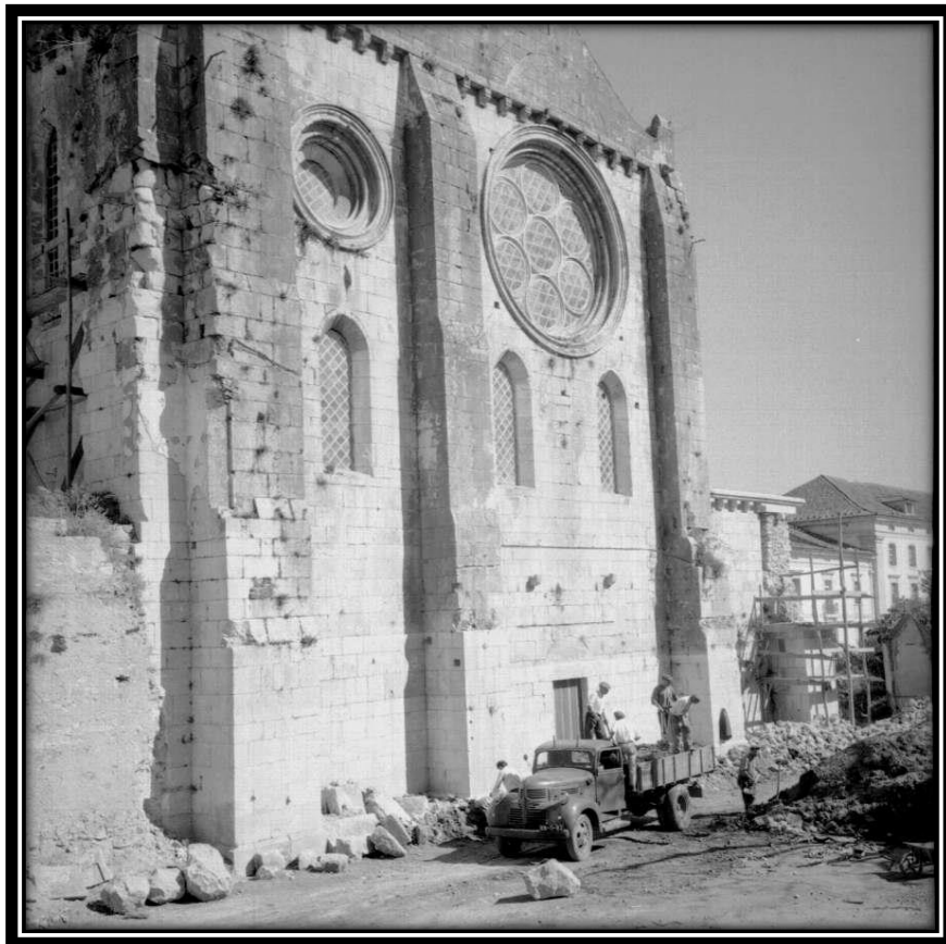
FOTO 394: Fachada Sul do Transepto
