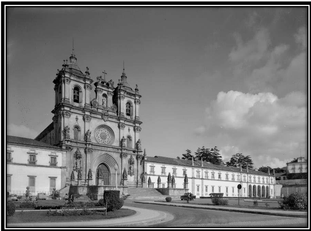
FOTO 428: Fachada Poente da Ala Sul
