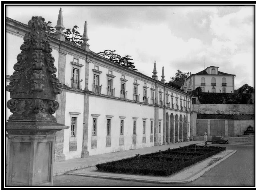
FOTO 429: Fachada Poente da Ala Sul
