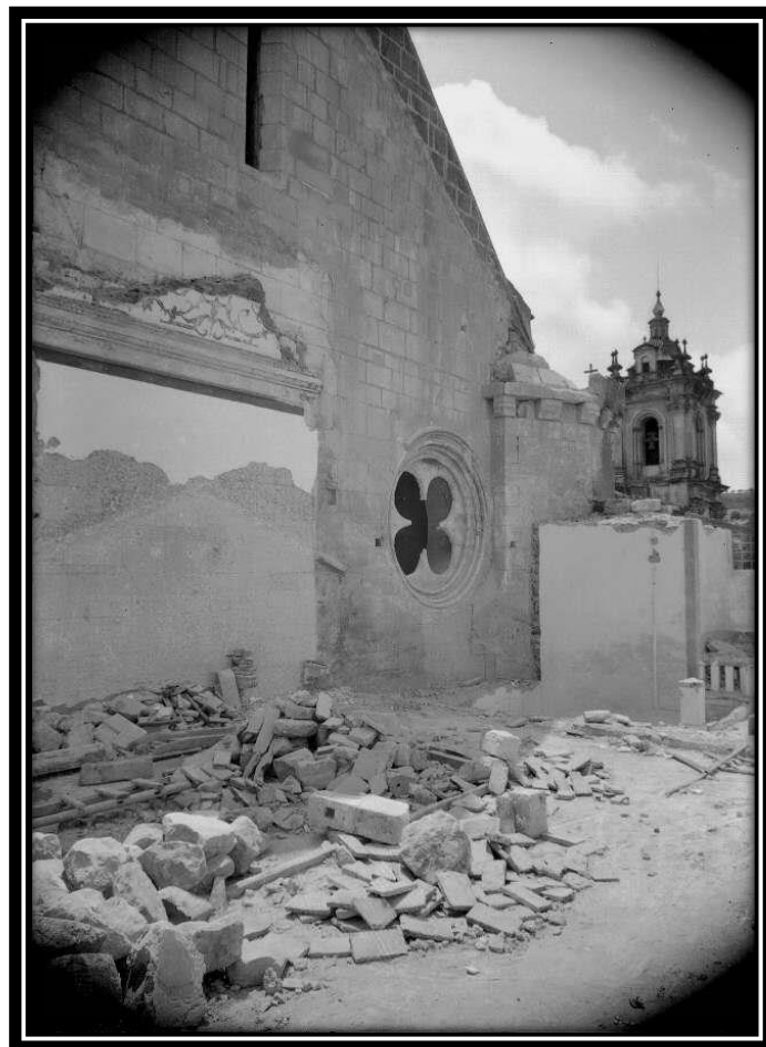
FOTO 284: Exterior do 2º Piso do Dormitório
