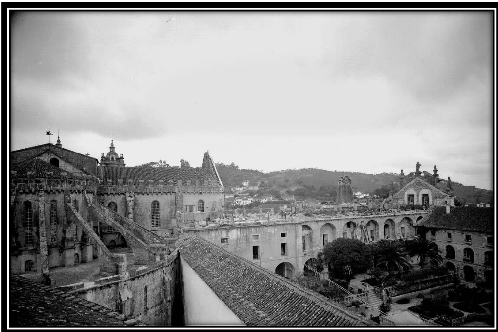
FOTO 280: Exterior do 2º Piso do Dormitório
