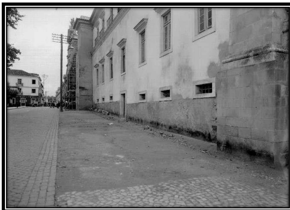
FOTO 444: Fachada Norte do Mosteiro
