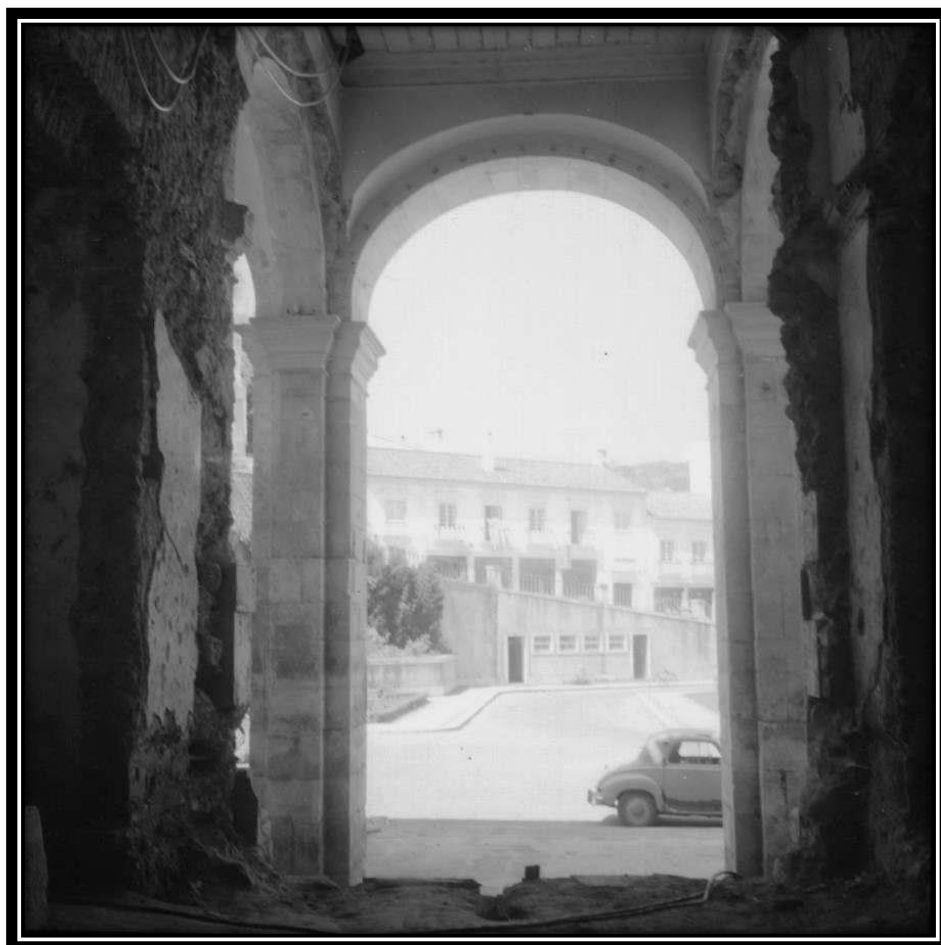
FOTO 414: Fachada Poente da Ala Sul
