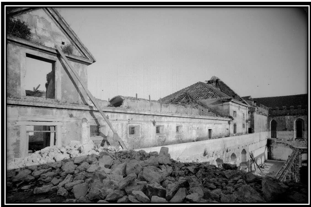
FOTO 278: Exterior do 2º Piso do Dormitório
