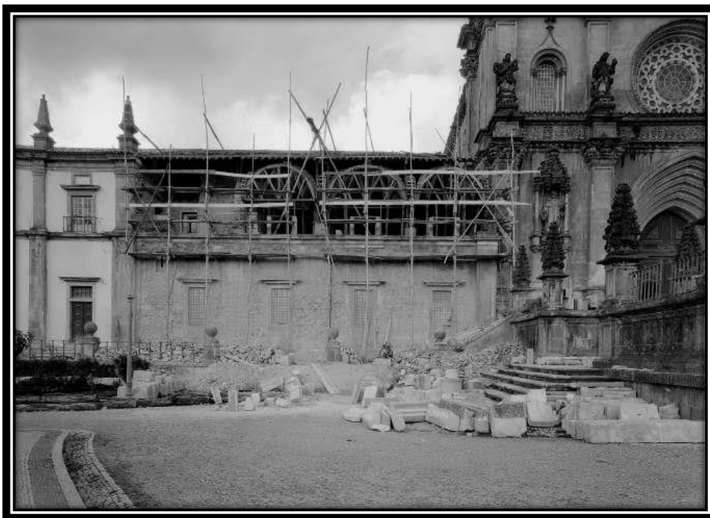
FOTO 265: Fachada da Sala dos Reis
