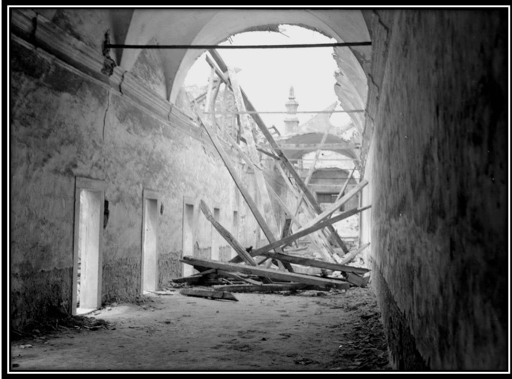
FOTO 319: 2º Piso do Dormitório
