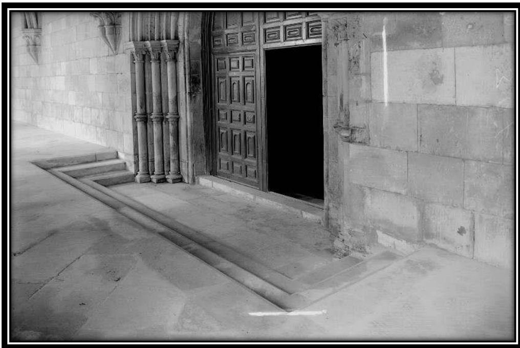
FOTO 228: Porta de entrada no Refeitório
