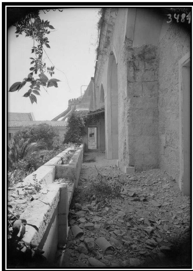
FOTO 288: Exterior do 1º Piso do Dormitório
