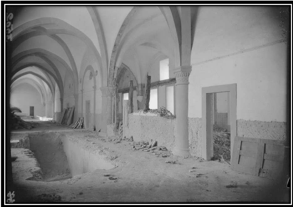
FOTO 297: 1º Piso do Dormitório
