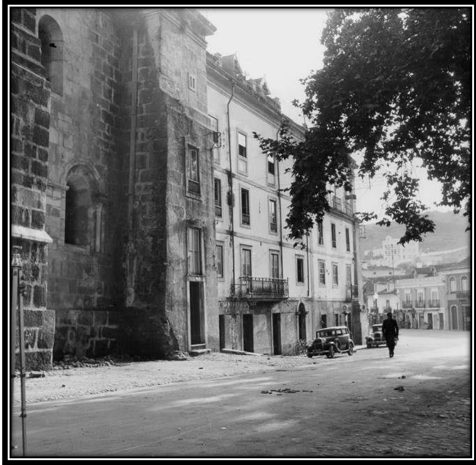
FOTO 431: Fachada Norte do Mosteiro
