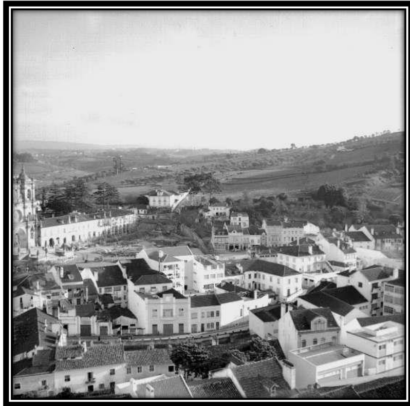
FOTO 13: Praça 25 de Abril em Obras e Fachada do Mosteiro
