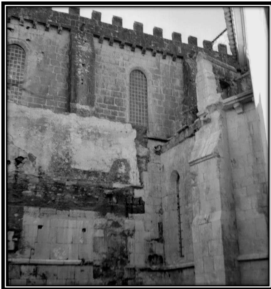
FOTO 396: Fachada Nascente do Braço Sul do Transepto
