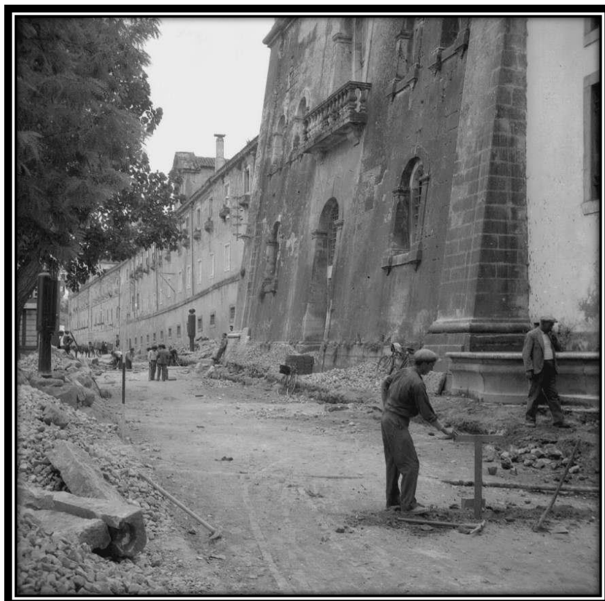
FOTO 436: Fachada Norte do Mosteiro
