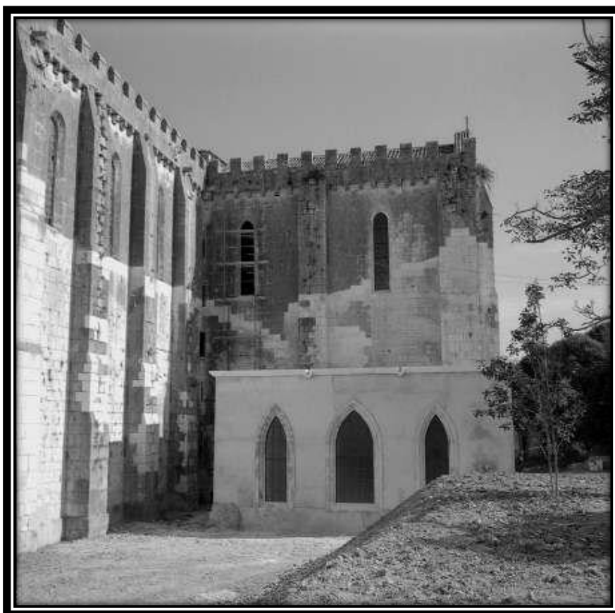
FOTO 401: Fachada Sul da Igreja
