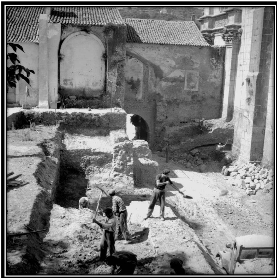
FOTO 416: Fachada Nascente da Ala Sul
