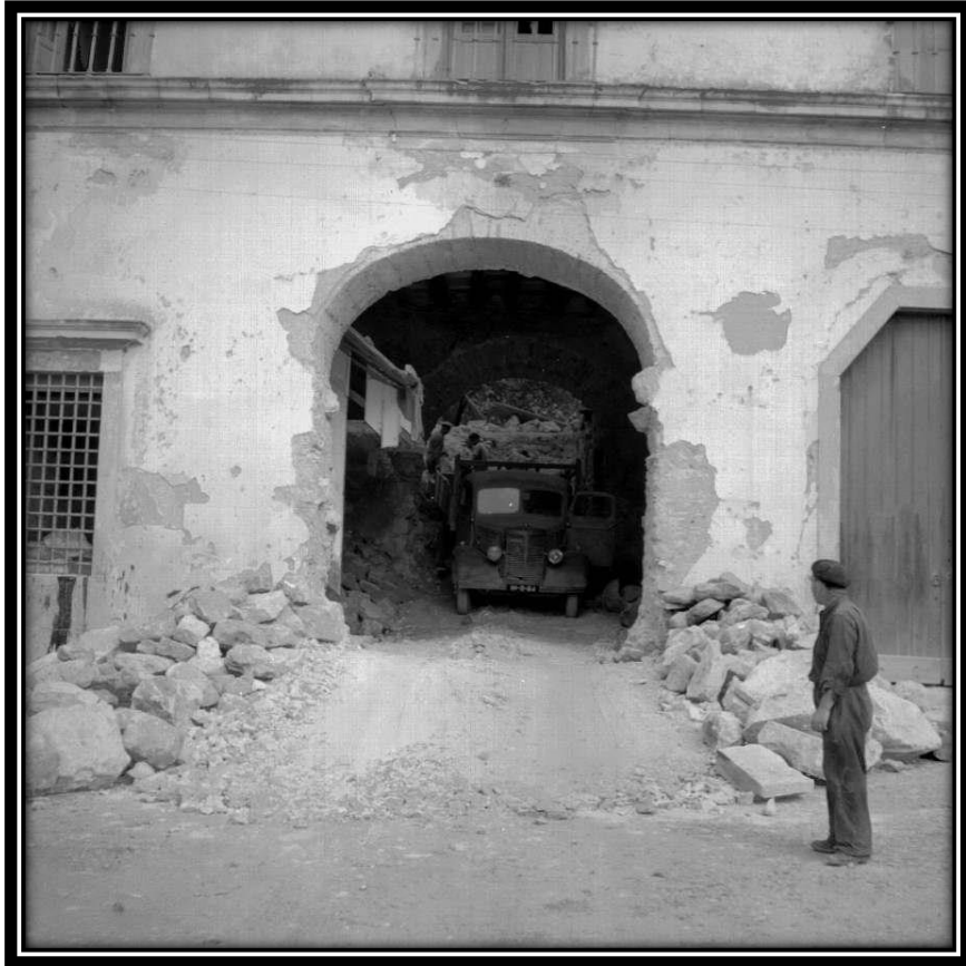
FOTO 415: Fachada Poente da Ala Sul
