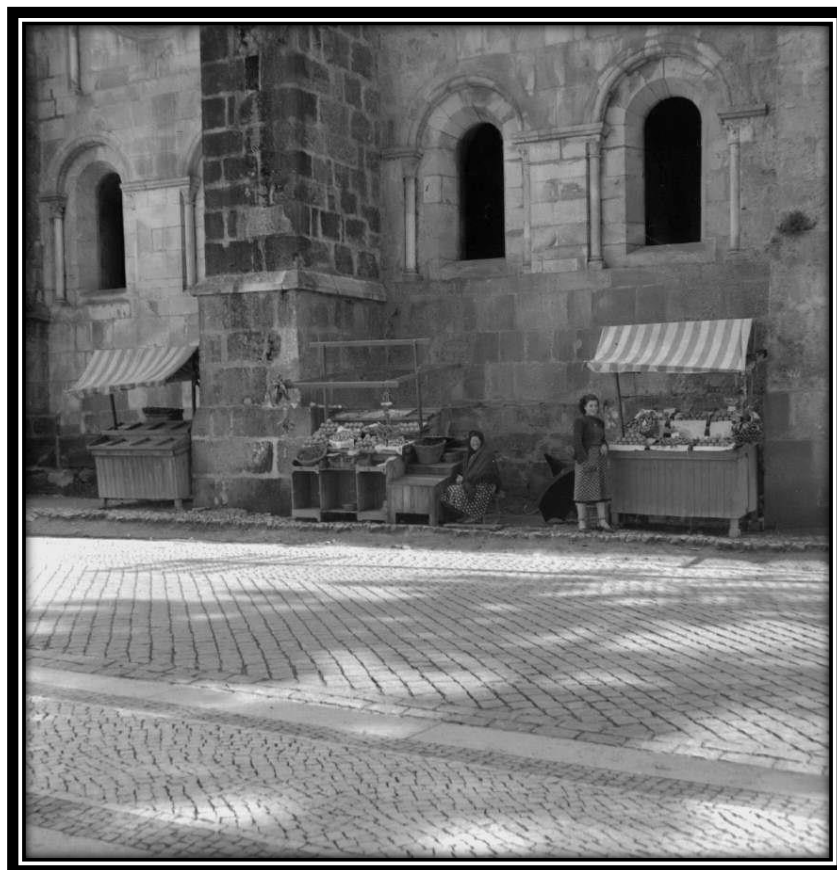
FOTO 254: Fachada do Refeitório
