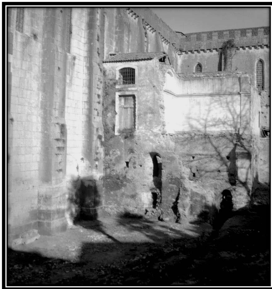
FOTO 388: Fachada Sul da Igreja
