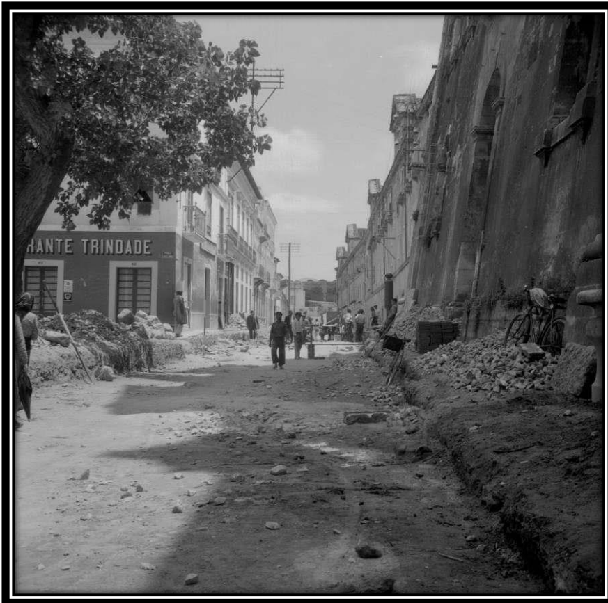
FOTO 435: Fachada Norte do Mosteiro
