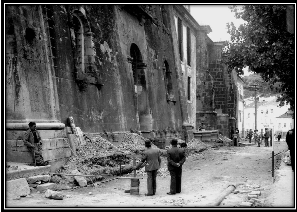
FOTO 433: Fachada Norte do Mosteiro
