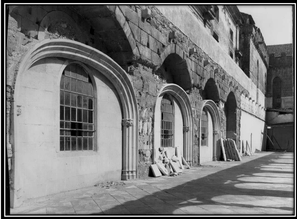
FOTO 289: Exterior do 1º Piso do Dormitório
