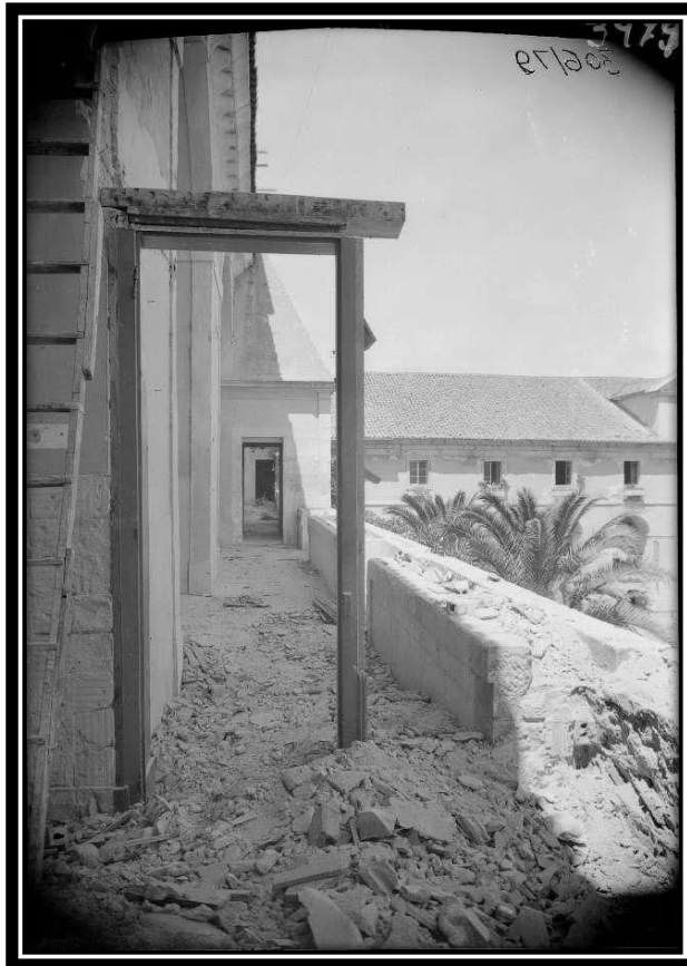
FOTO 287: Exterior do 1º Piso do Dormitório
