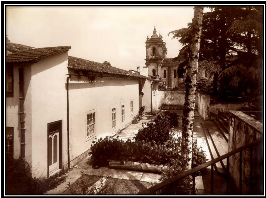
FOTO 406: Fachada Nascente da Ala Sul
