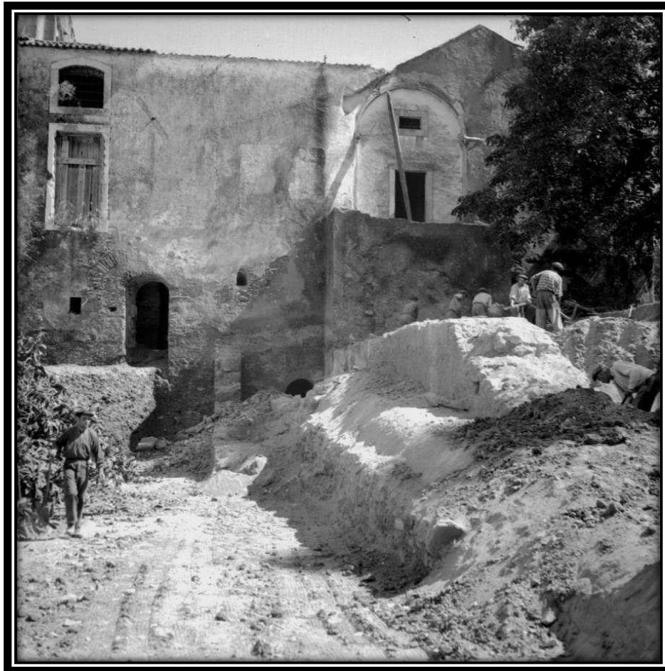
FOTO 417: Fachada Nascente da Ala Sul
