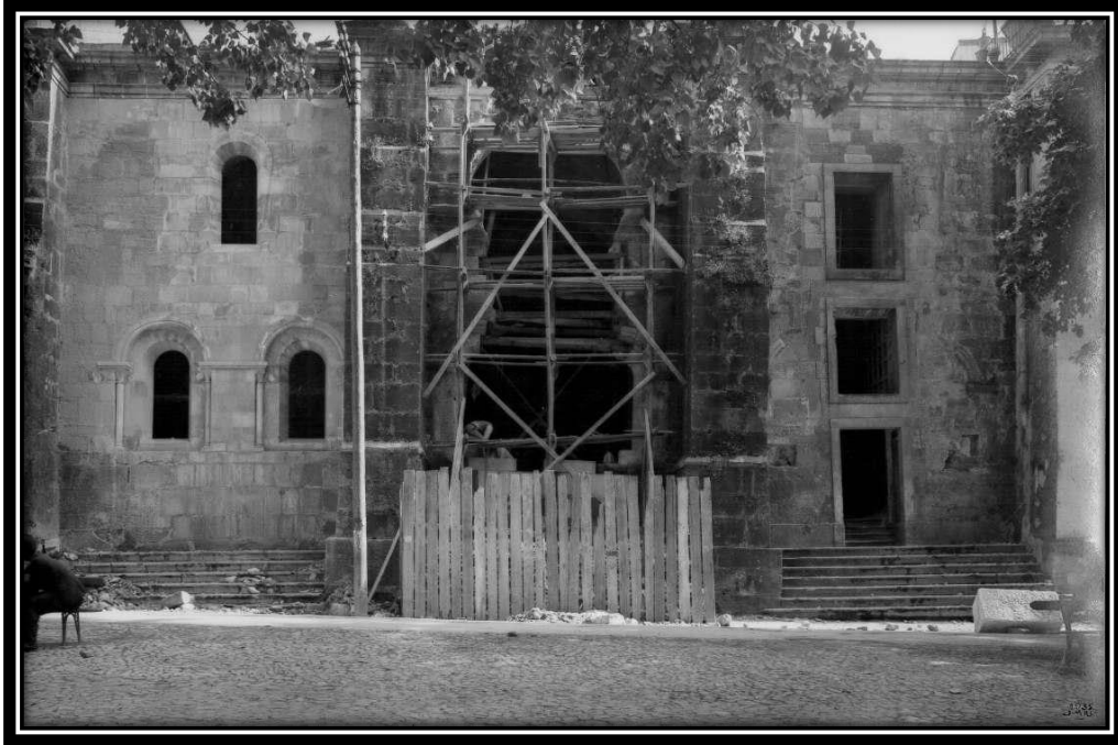
FOTO 229: Fachada do Refeitório
