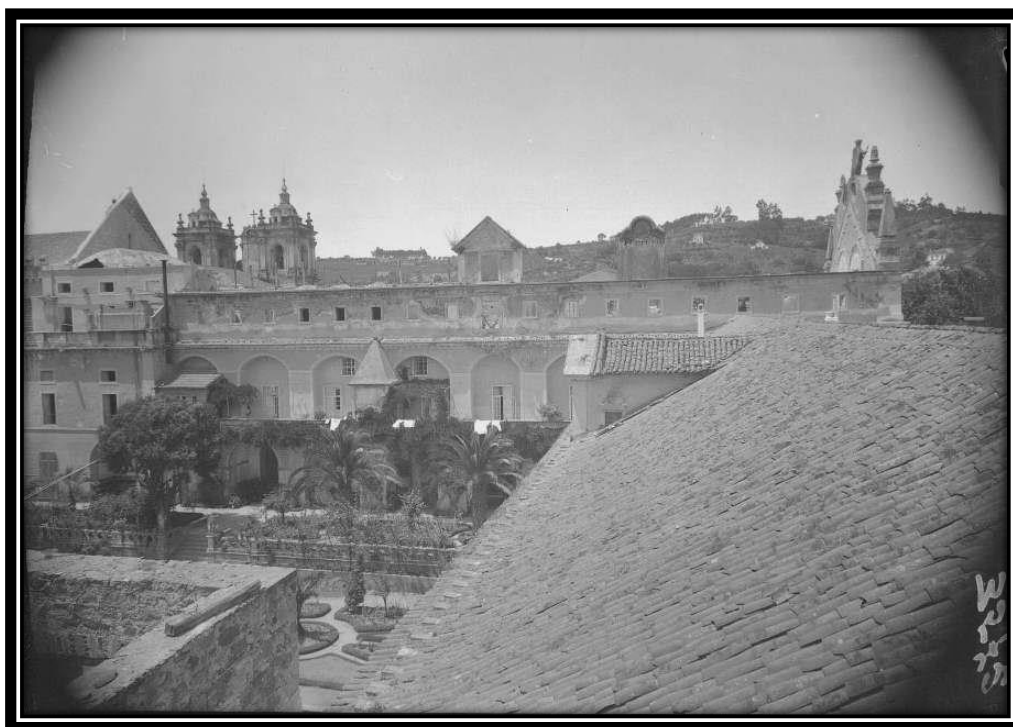
FOTO 285: Exterior do 1º Piso do Dormitório
