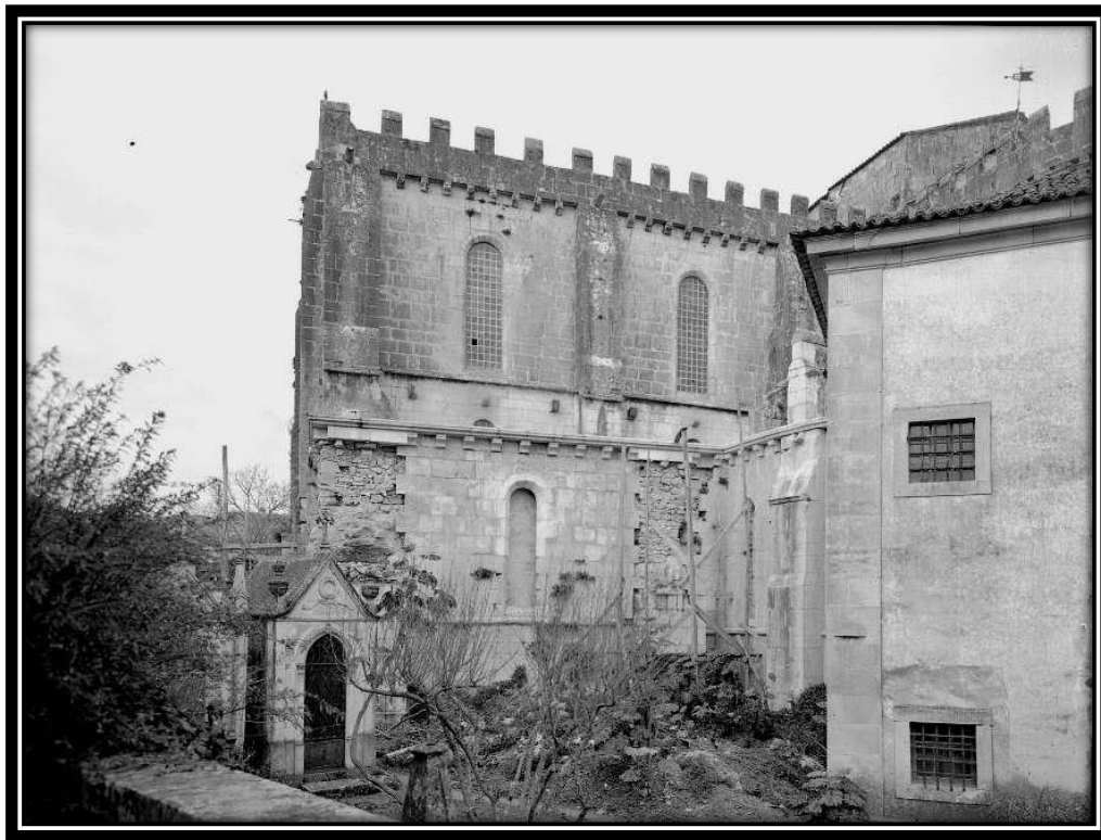
FOTO 397: Fachada Nascente do Braço Sul do Transepto
