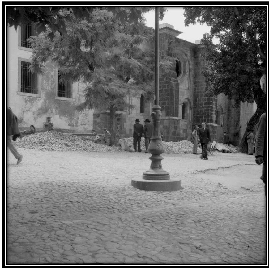
FOTO 434: Fachada Norte do Mosteiro
