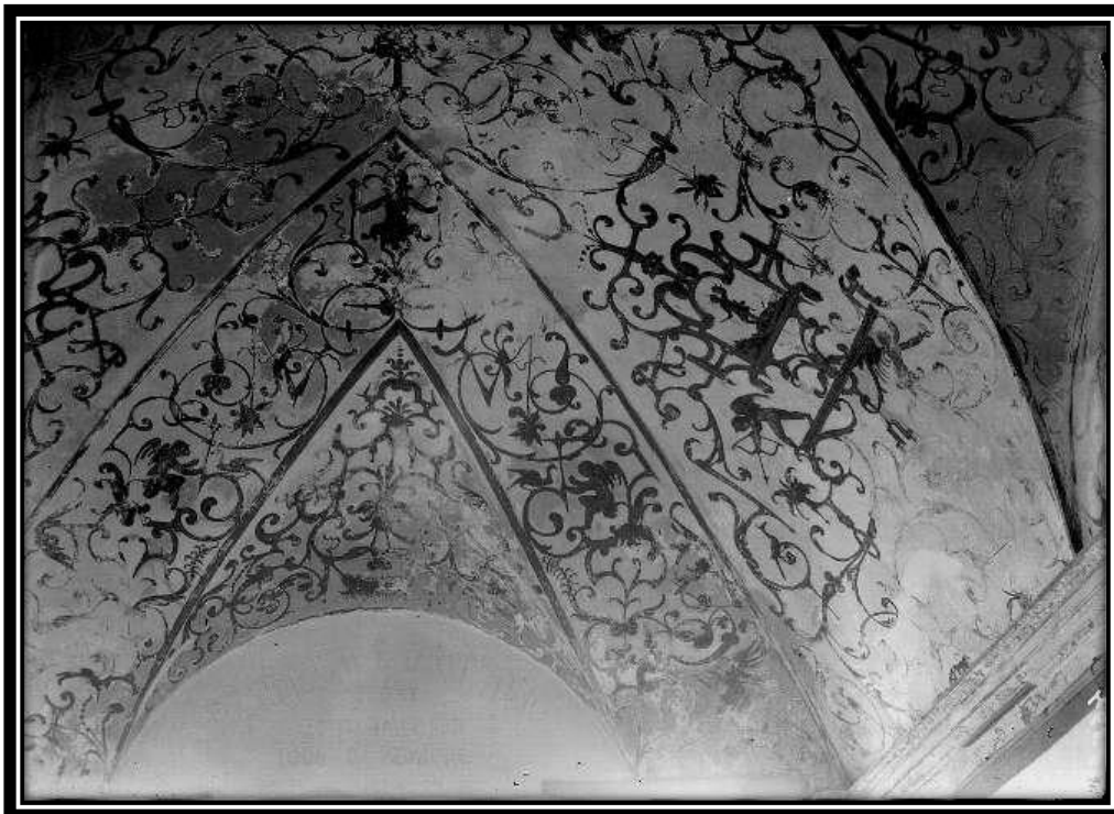
FOTO 322: 2º Piso do Dormitório
