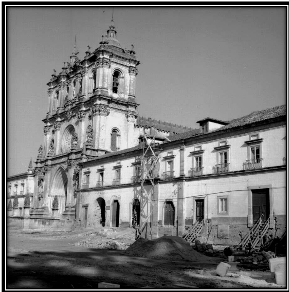
FOTO 410: Fachada Poente da Ala Sul
