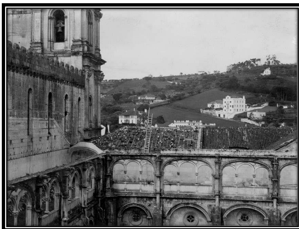
FOTO 268: Fachada da Sala dos Reis
