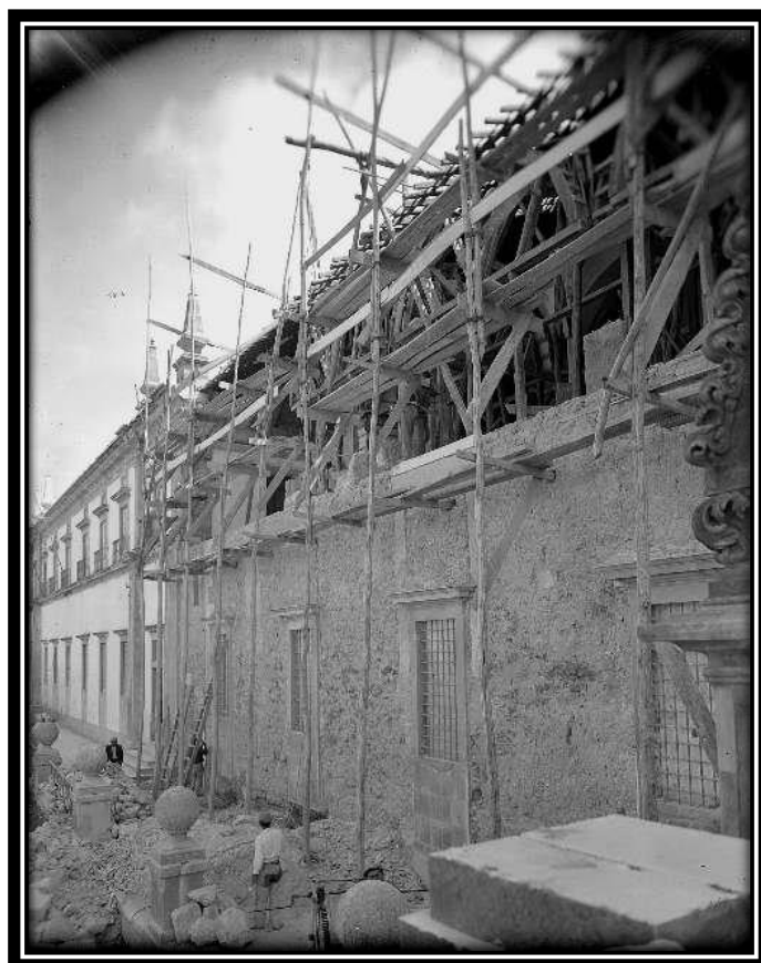
FOTO 267: Fachada da Sala dos Reis
