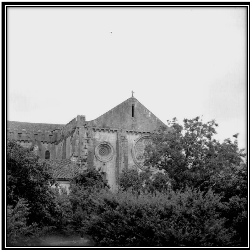
FOTO 384: Fachada Sul da Igreja
