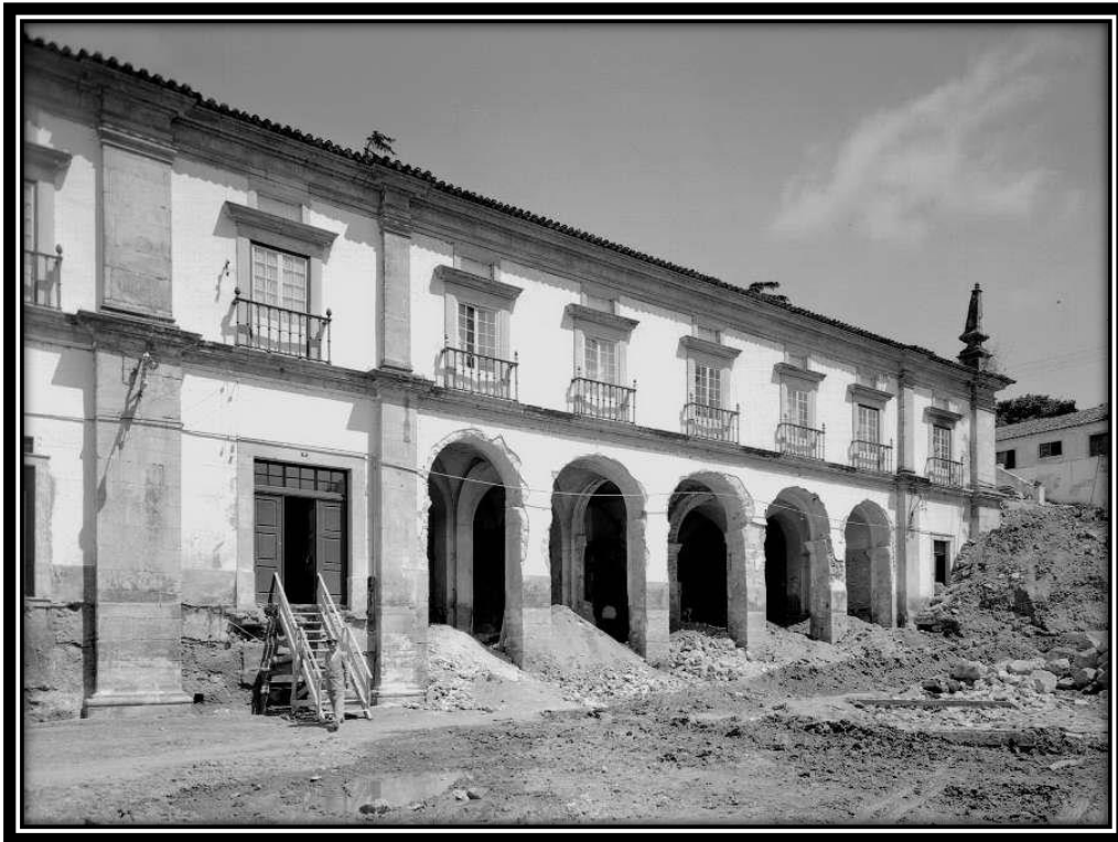
FOTO 411: Fachada Poente da Ala Sul
