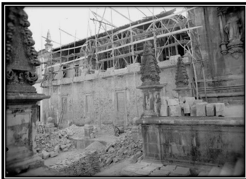
FOTO 266: Fachada da Sala dos Reis
