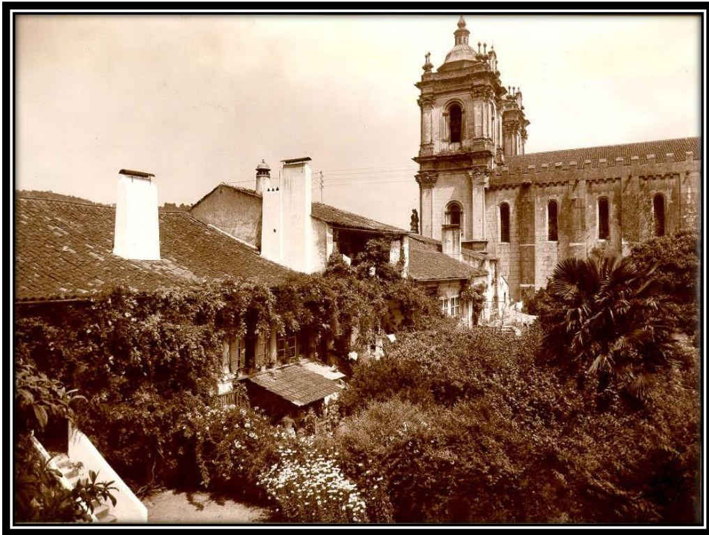
FOTO 405: Fachada Nascente da Ala Sul
