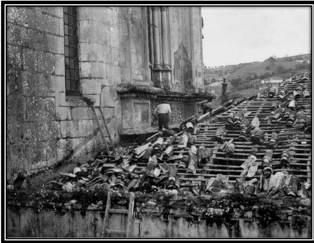
FOTO 269: Telhado da Sala dos Reis
