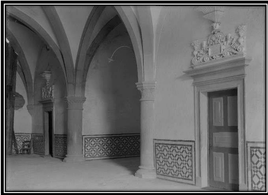
FOTO 295: 1º Piso do Dormitório
