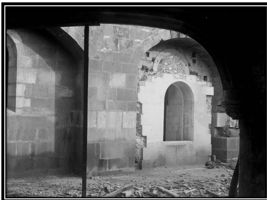
FOTO 292: Exterior do 1º Piso do Dormitório
