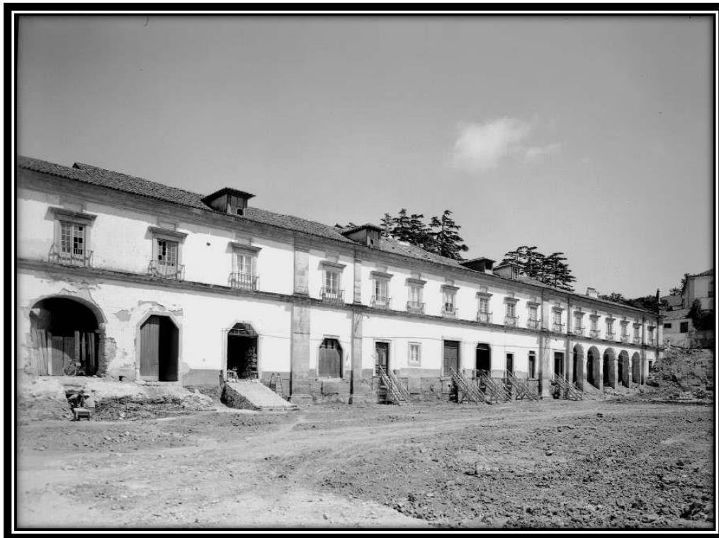
FOTO 408: Fachada Poente da Ala Sul
