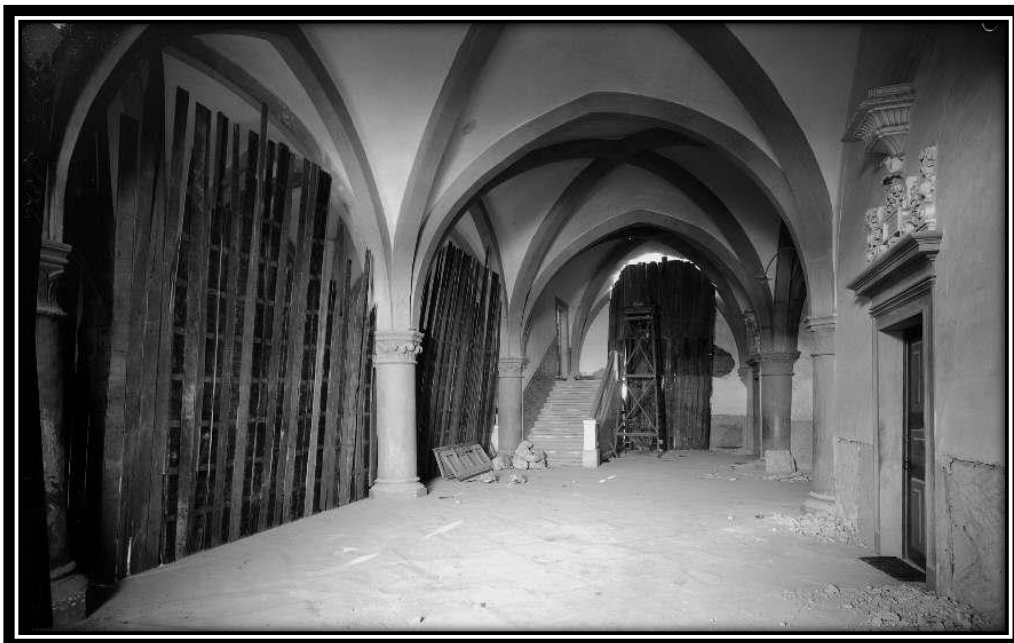
FOTO 304: 1º Piso do Dormitório
