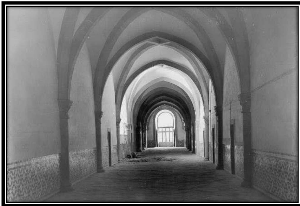
FOTO 293: 1º Piso do Dormitório
