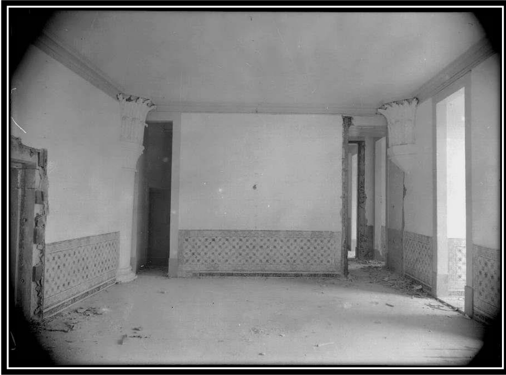
FOTO 301: 1º Piso do Dormitório
