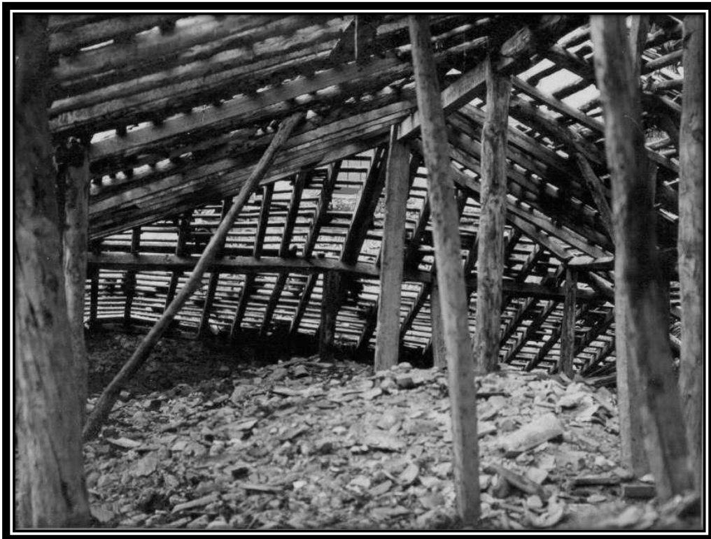
FOTO 272: Telhado da Sala dos Reis
