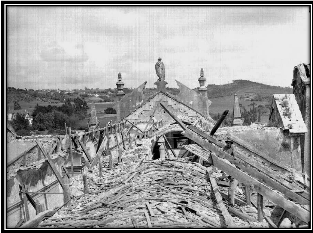
FOTO 277: Exterior do 2º Piso do Dormitório
