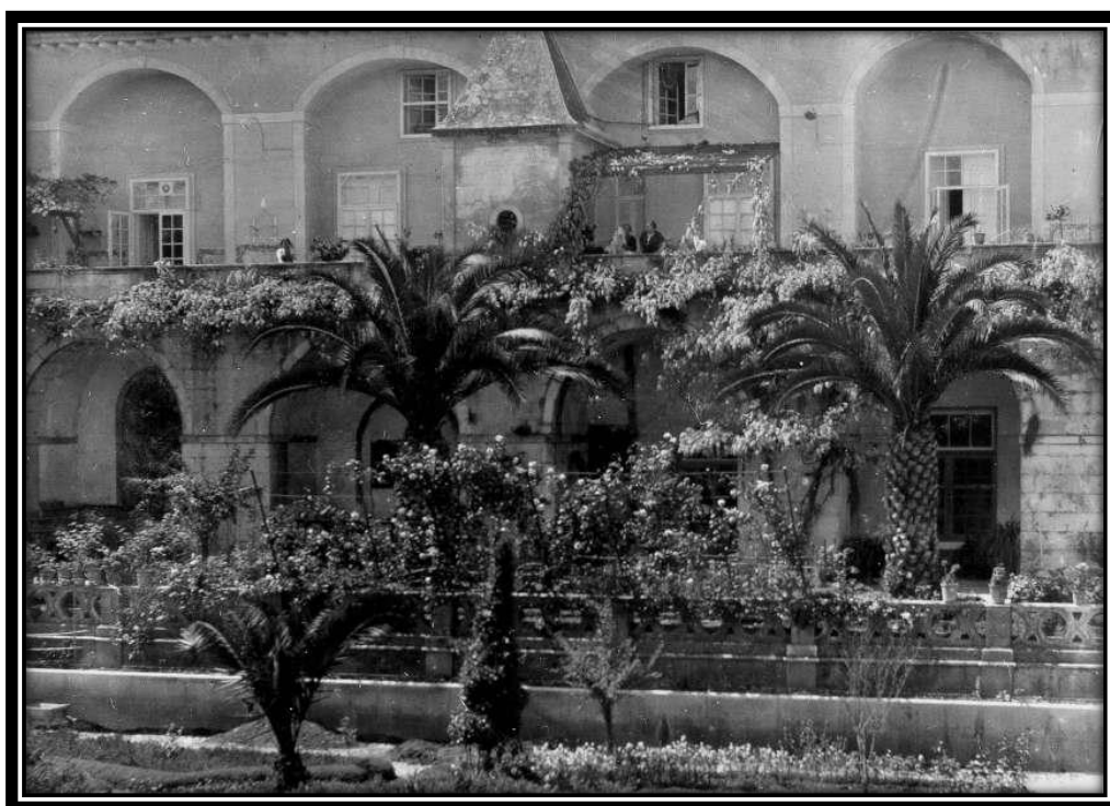
FOTO 286: Exterior do 1º Piso do Dormitório
