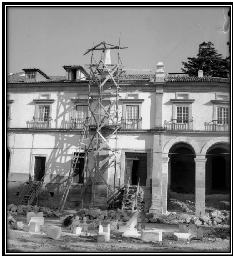
FOTO 413: Fachada Poente da Ala Sul
