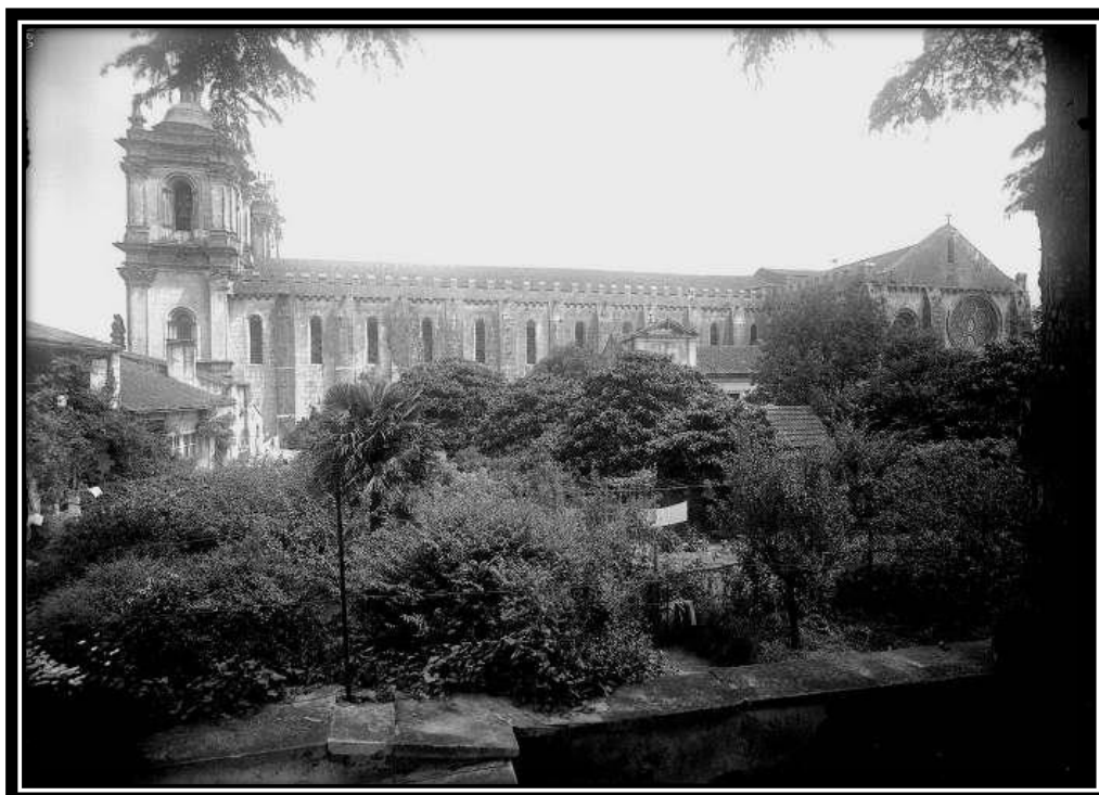
FOTO 379: Fachada Sul da Igreja
