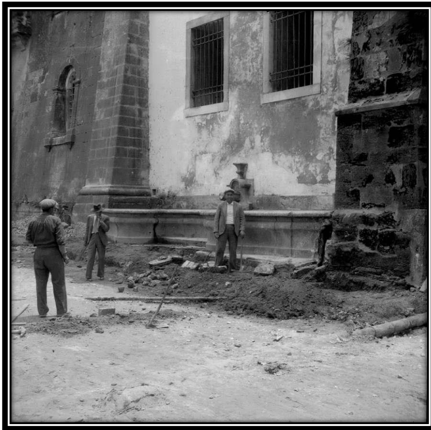
FOTO 437: Fachada Norte do Mosteiro
