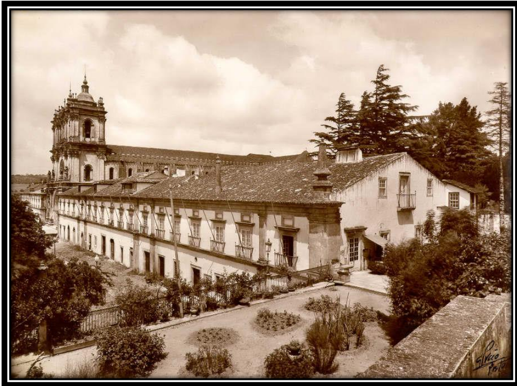
FOTO 403: Fachada Poente da Ala Sul
