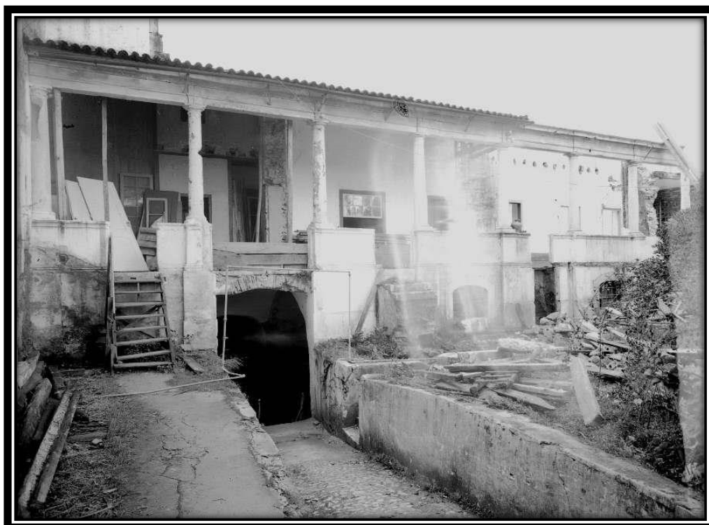
FOTO 418: Fachada Nascente da Ala Sul
