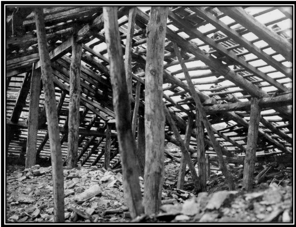
FOTO 271: Telhado da Sala dos Reis
