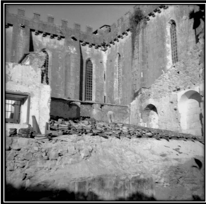
FOTO 389: Fachada Sul da Igreja
