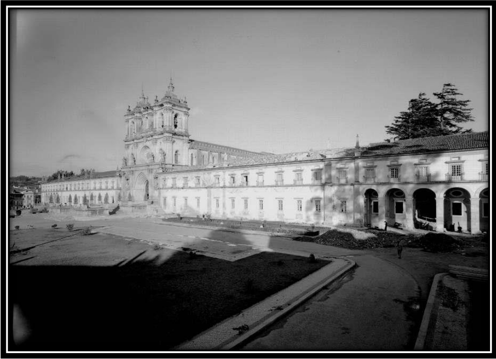
FOTO 427: Fachada Poente do Mosteiro
