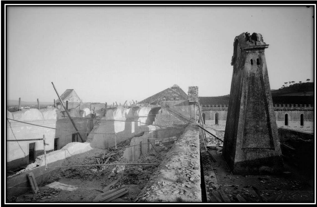
FOTO 279: Exterior do 2º Piso do Dormitório
