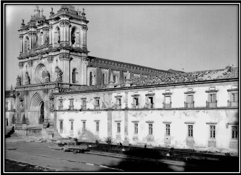
FOTO 425: Fachada Poente da Ala Sul
