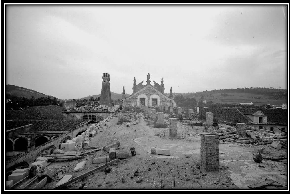
FOTO 281: Exterior do 2º Piso do Dormitório
