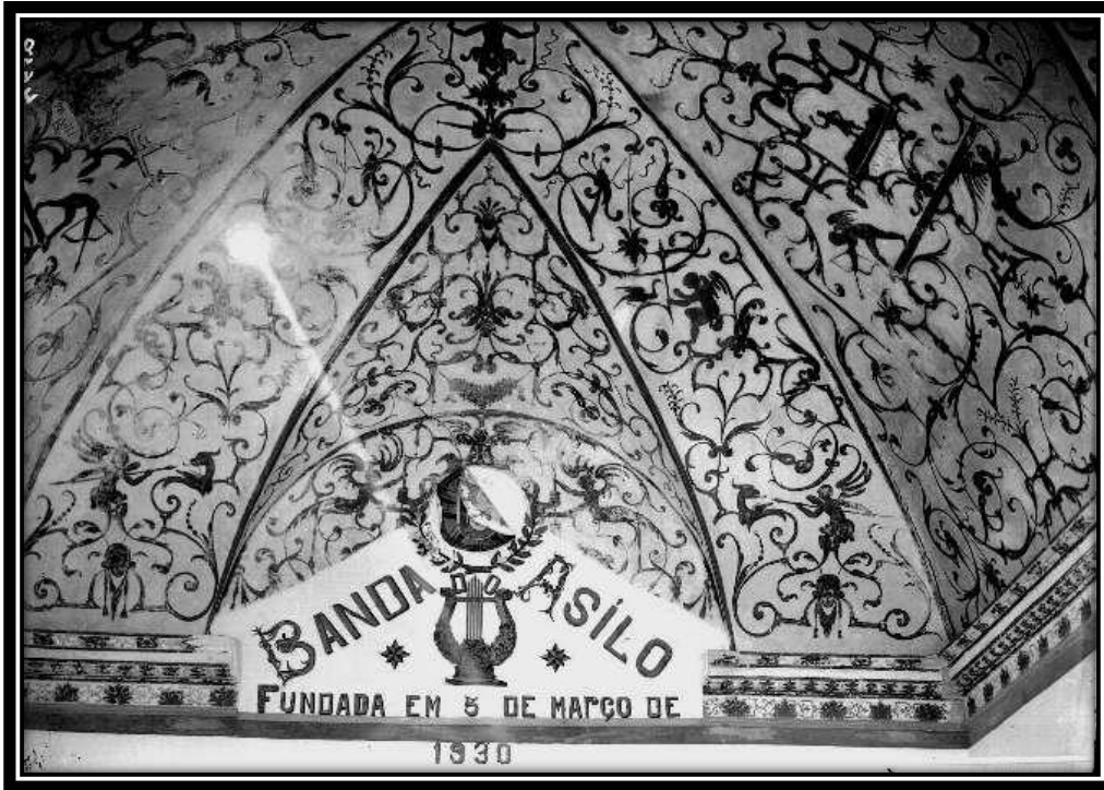
FOTO 321: 2º Piso do Dormitório
