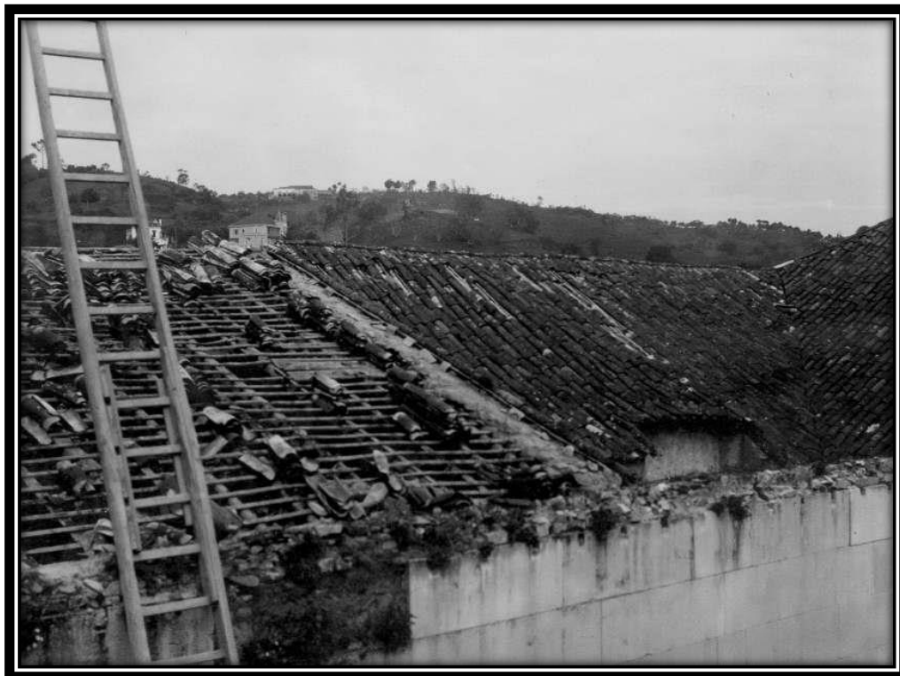
FOTO 270: Telhado da Sala dos Reis
