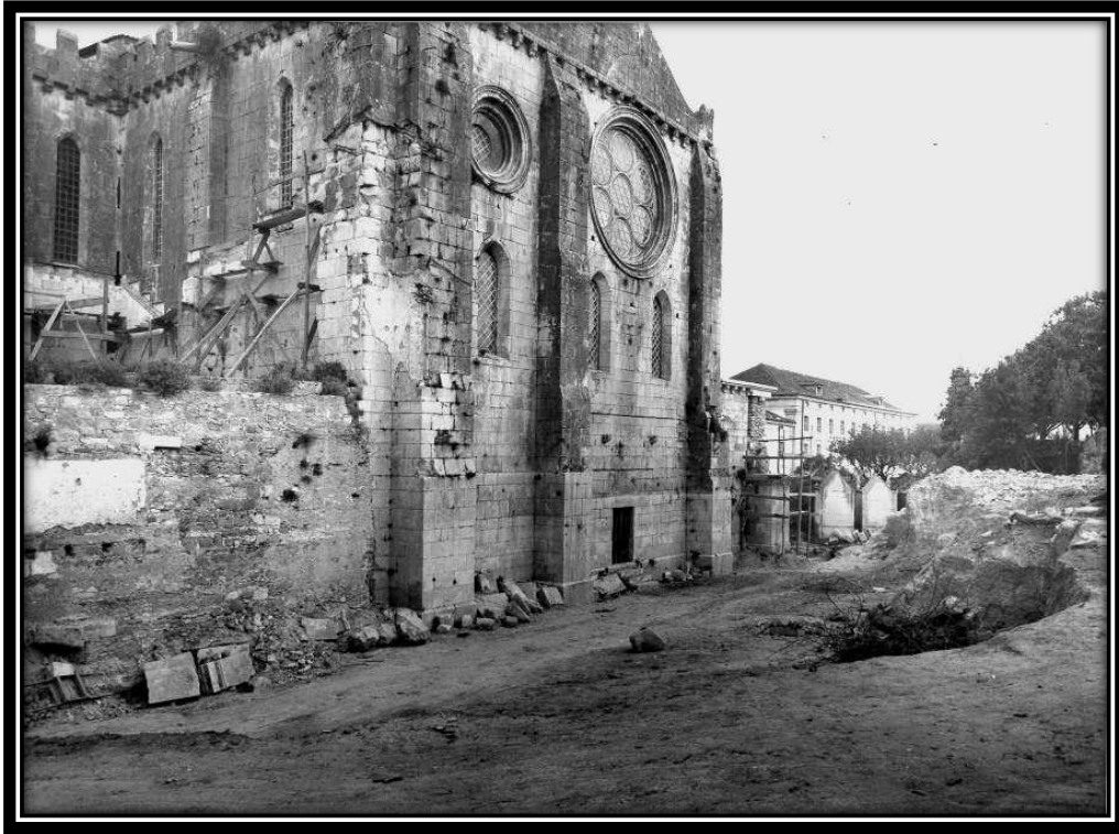
FOTO 393: Fachada Sul do Transepto
