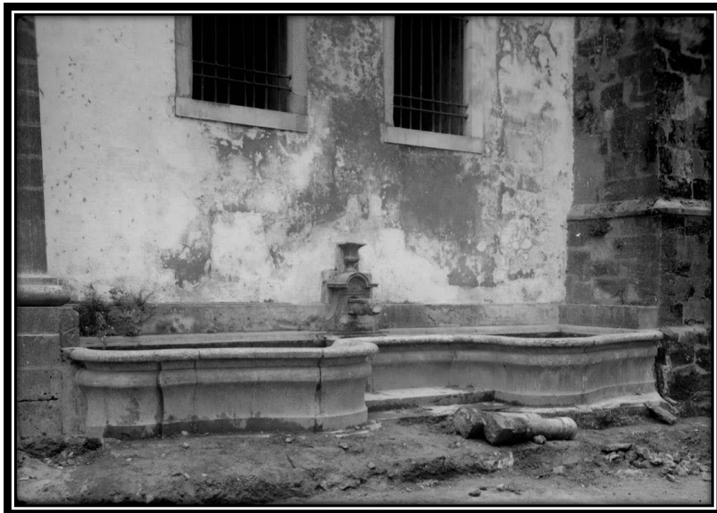
FOTO 438: Fachada Norte do Mosteiro
