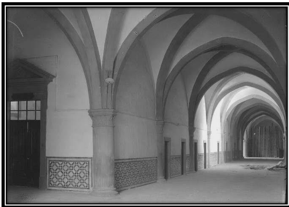
FOTO 294: 1º Piso do Dormitório
