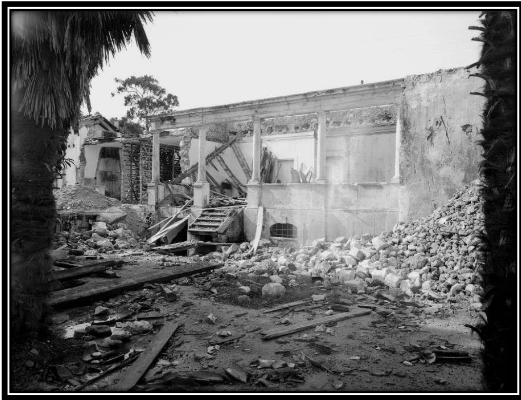
FOTO 419: Fachada Nascente da Ala Sul
