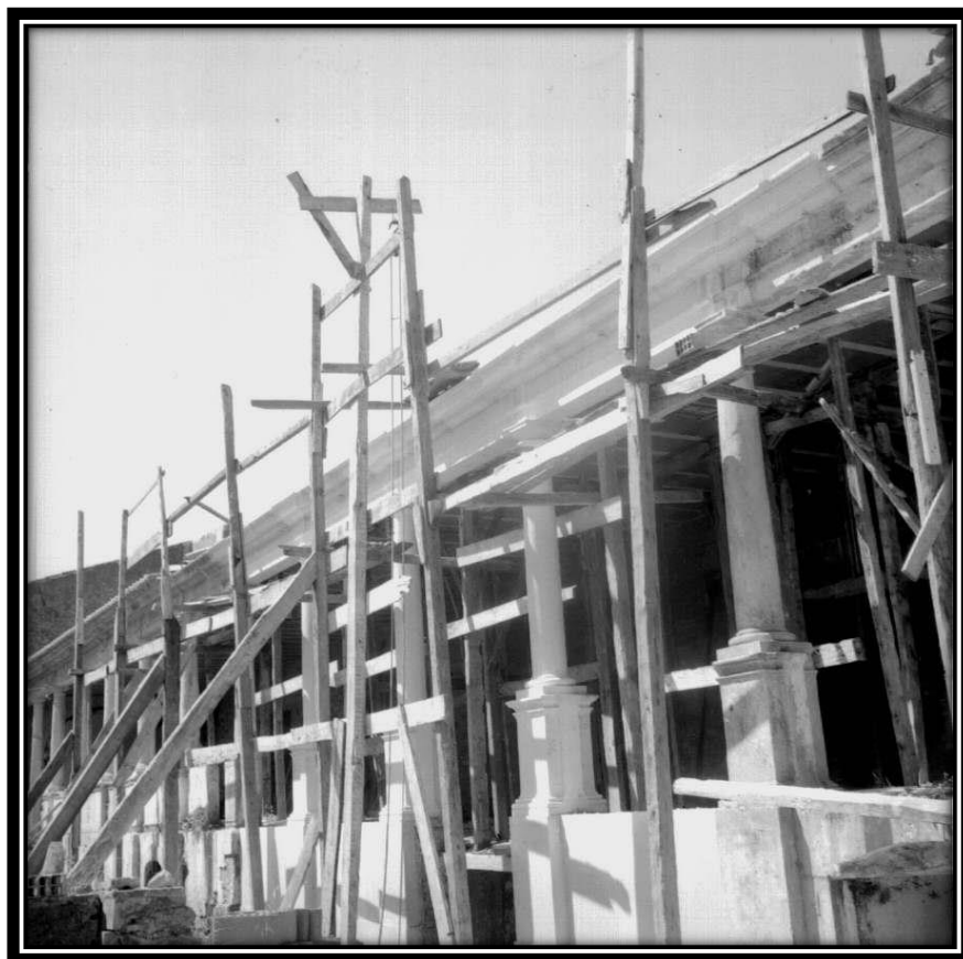
FOTO 420: Fachada Nascente da Ala Sul
