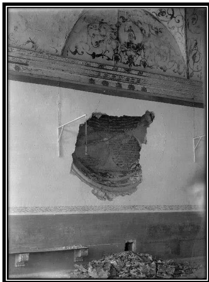
FOTO 323: 2º Piso do Dormitório
