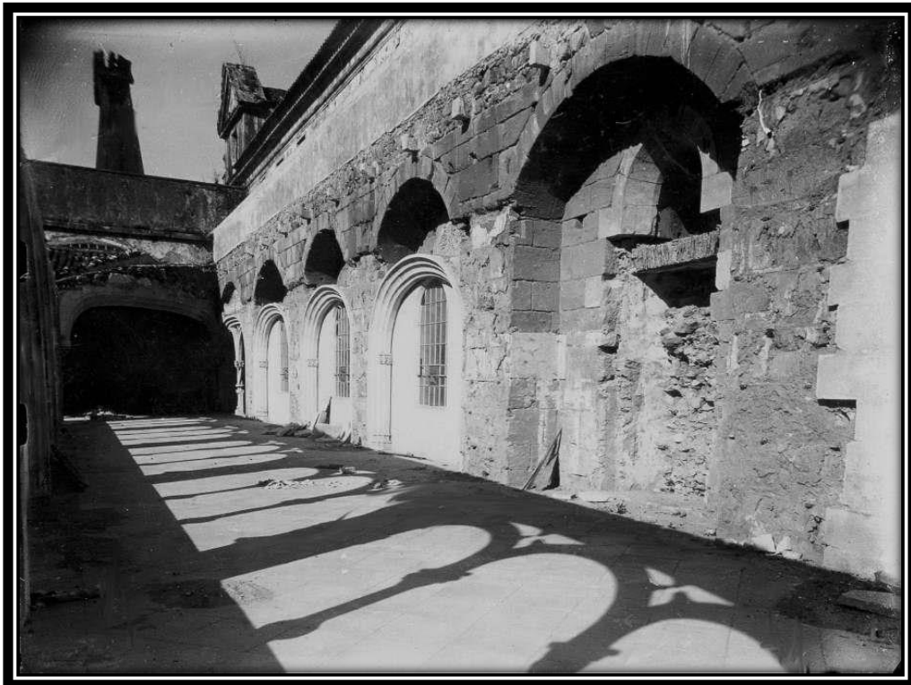
FOTO 290: Exterior do 1º Piso do Dormitório
