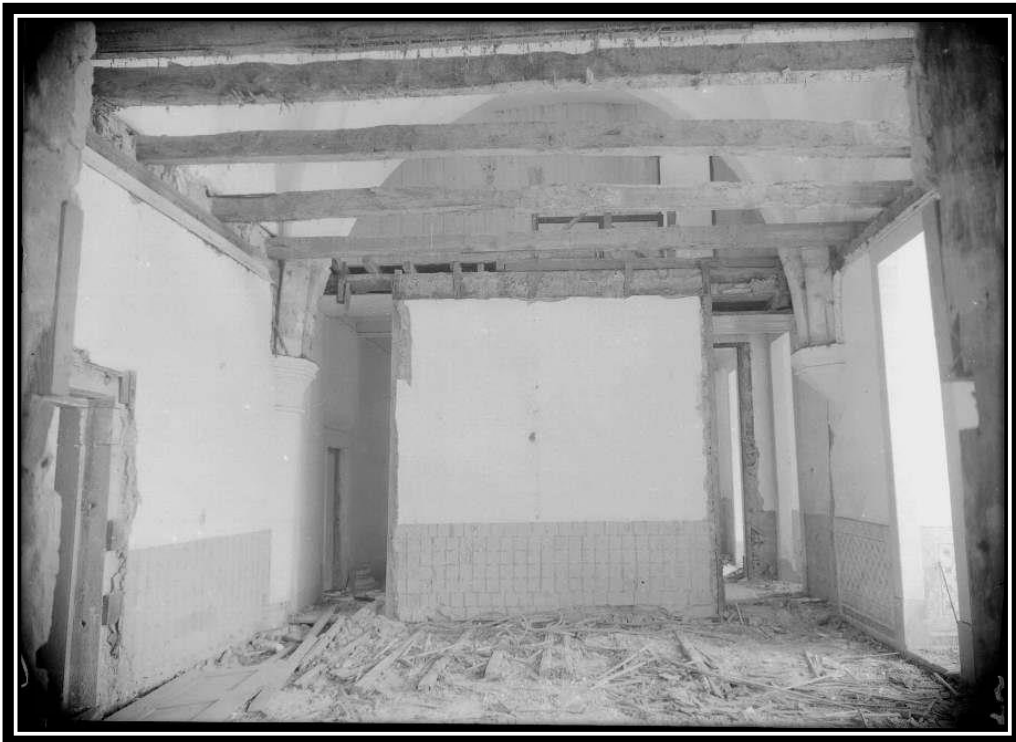
FOTO 302: 1º Piso do Dormitório
