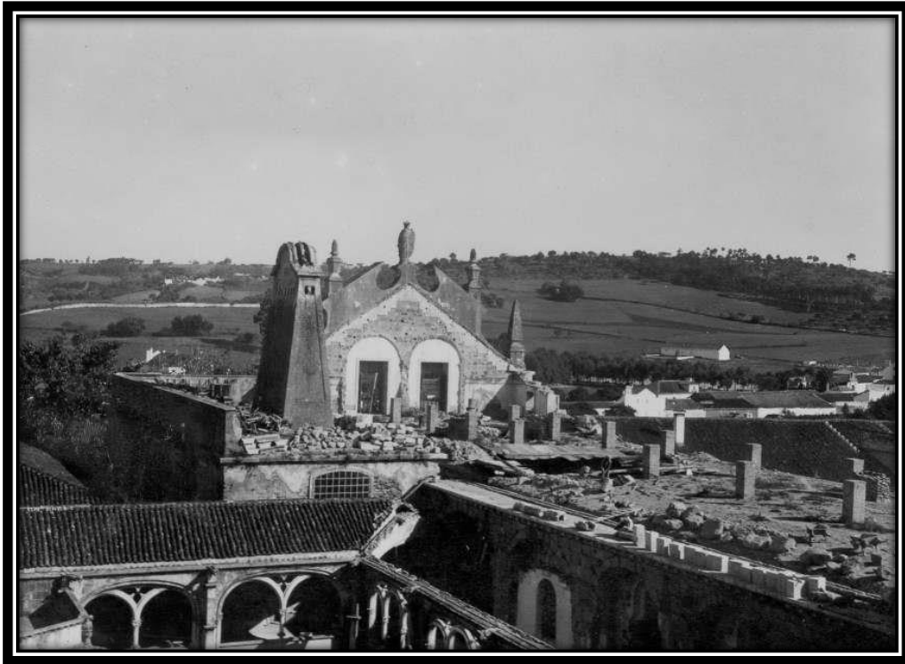
FOTO 283: Exterior do 2º Piso do Dormitório
