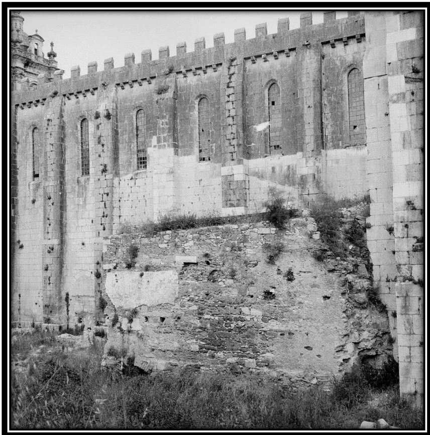
FOTO 400: Fachada Sul da Igreja
