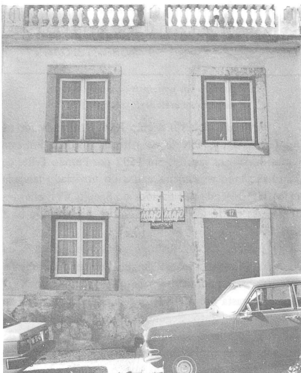
Habitação operária edificada em 1749
